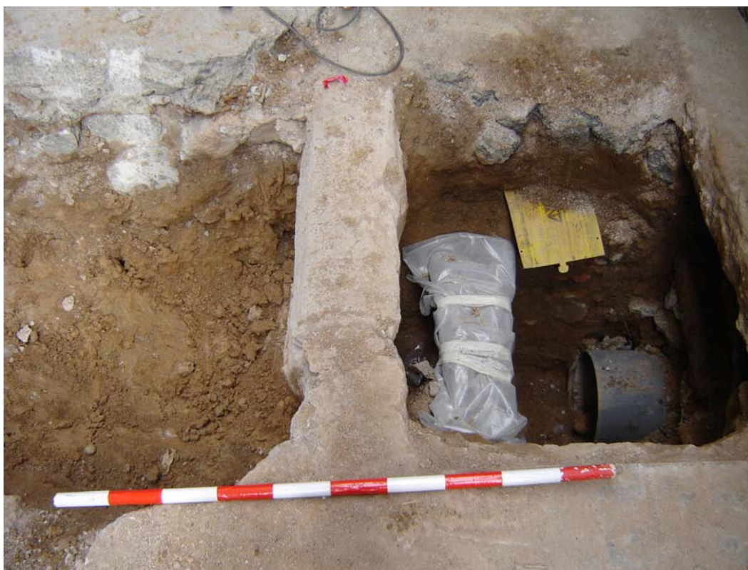
Vista general de la rasa durant el procés d'excavació
