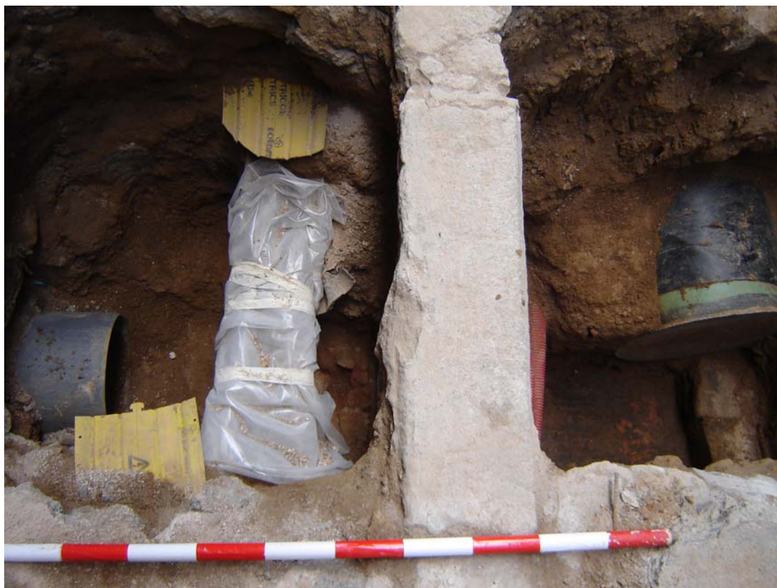
Vista general de la rasa al final de l'excavació.
