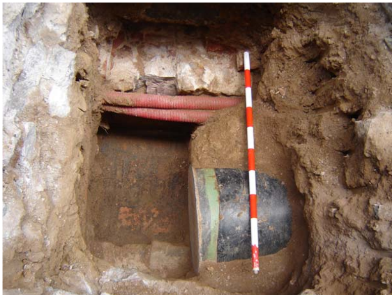
Vista general de la claveguera u. e. 08 amb el tub RPSU que se li recolza
