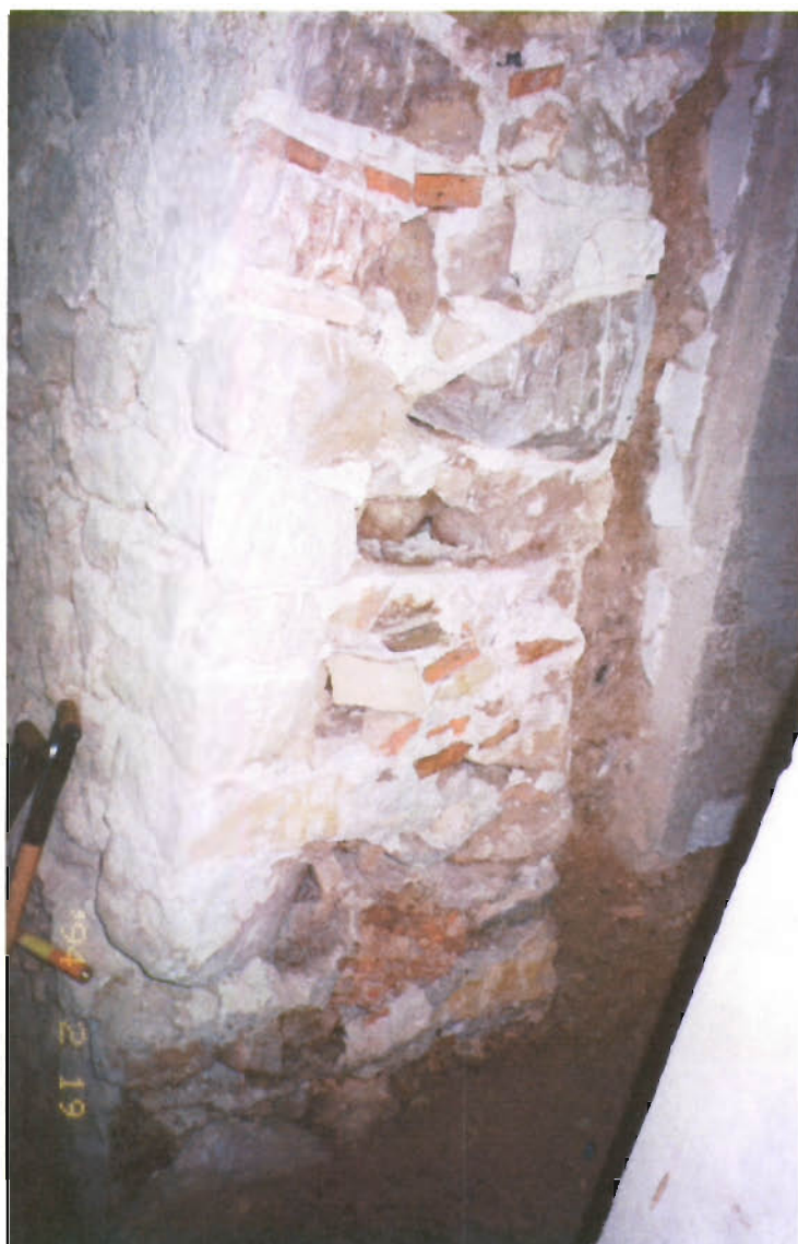
FOTO 6. Detall de l'interior del mur del Palau. Al tall s'hi pot apreciar la tècnica constructiva
