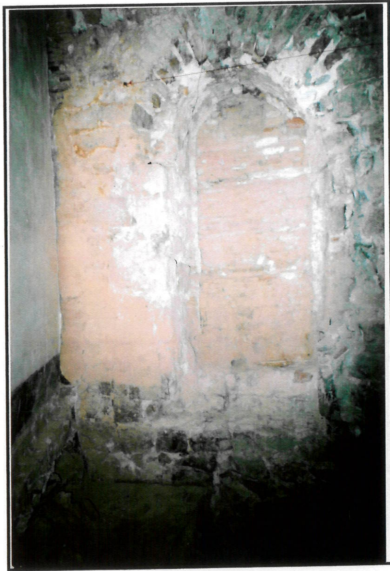
F.9. Detall de la finestra meridional del mur oest de la torre. A la seva part baixa s'hi observa el canvi de parament en aquell parament.. També s'hi observa la paret que divideix actualment la propietat de l'immoble.
