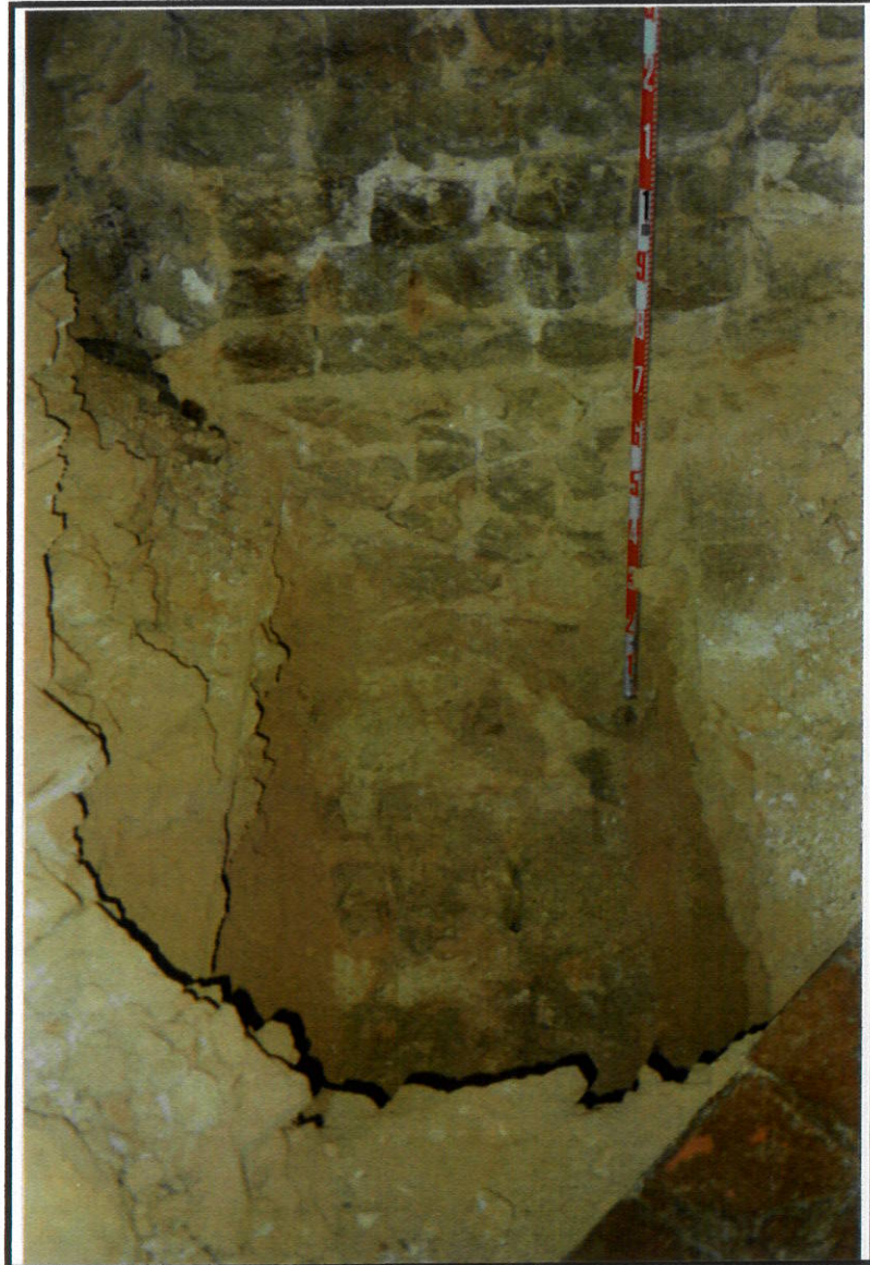
F.6. Detall del petit sondeig realitzat en l'angle nordoest del petit dormitori. S'hi veu el massís interior de la part baixa de la torre 67 i el canvi de parament en la paret oest d'aquesta.
