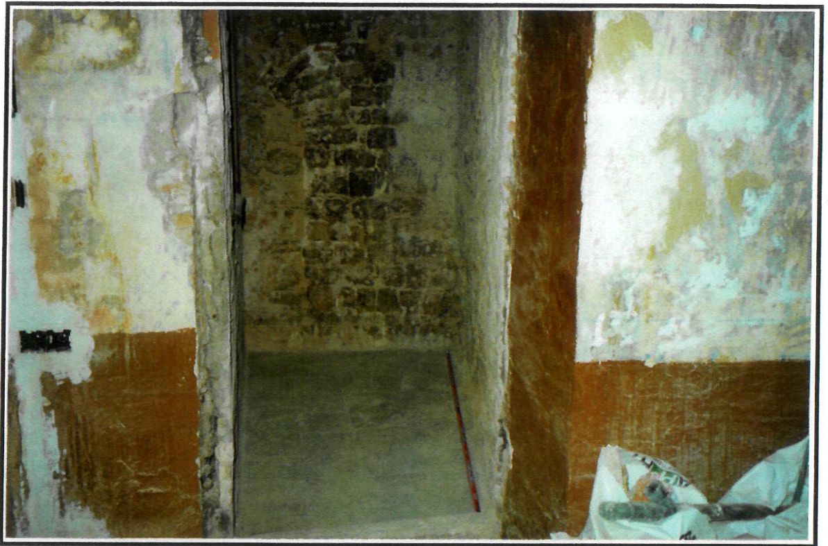
F. 1. Vista general de l'angle interior nord/oest de la torre romana 67. Des del pati interior.
