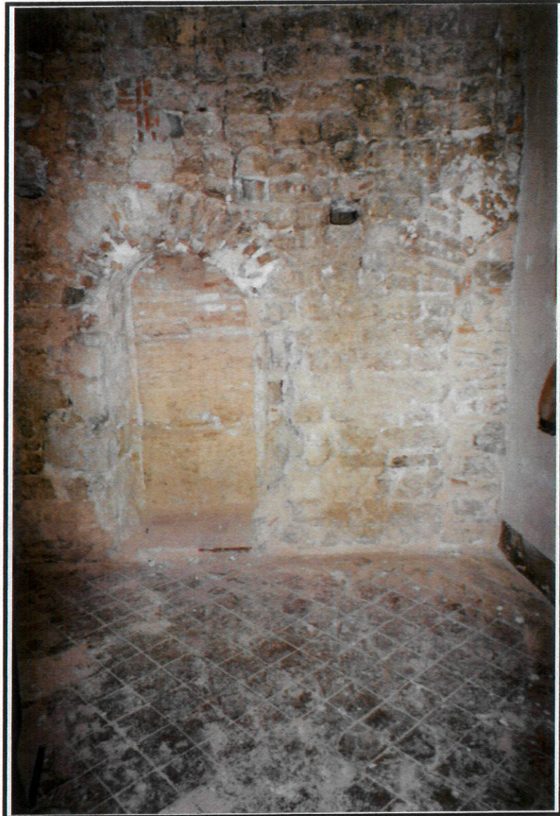
F. 4. Vista general del mur oest de la torre romana 67. S'hi veuen les dues finestres d'aquesta paret. Des del petit dormitori de l'immoble actual.
