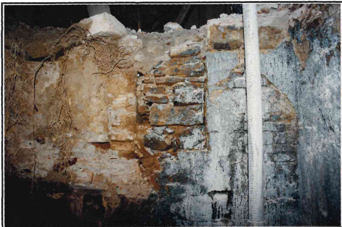
F.3. Vista de la paret sud de la sínia i de les U.E. 1012,1030 i 1031.
