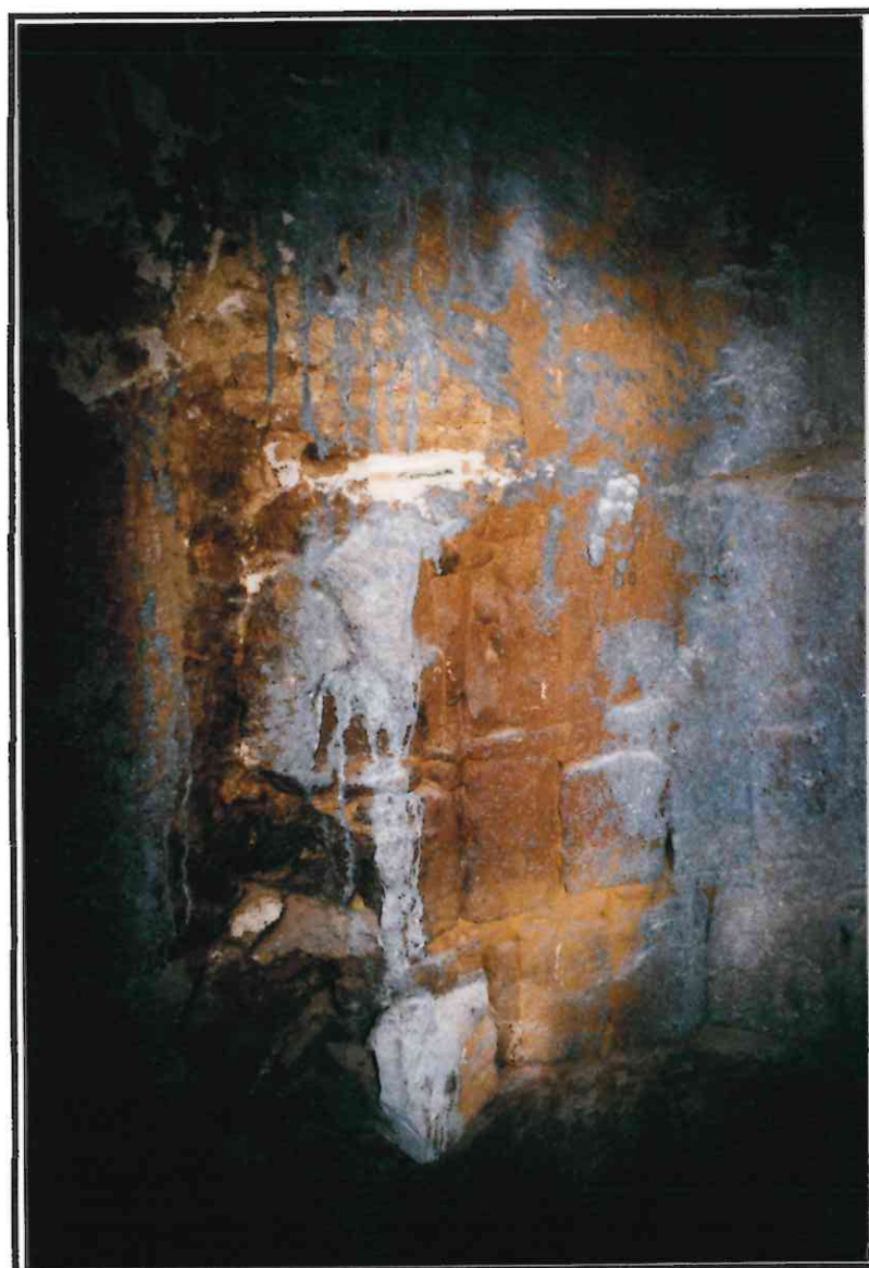
F.9. Detall del parament parcialment destruït del pou trobat dins la sínia.
