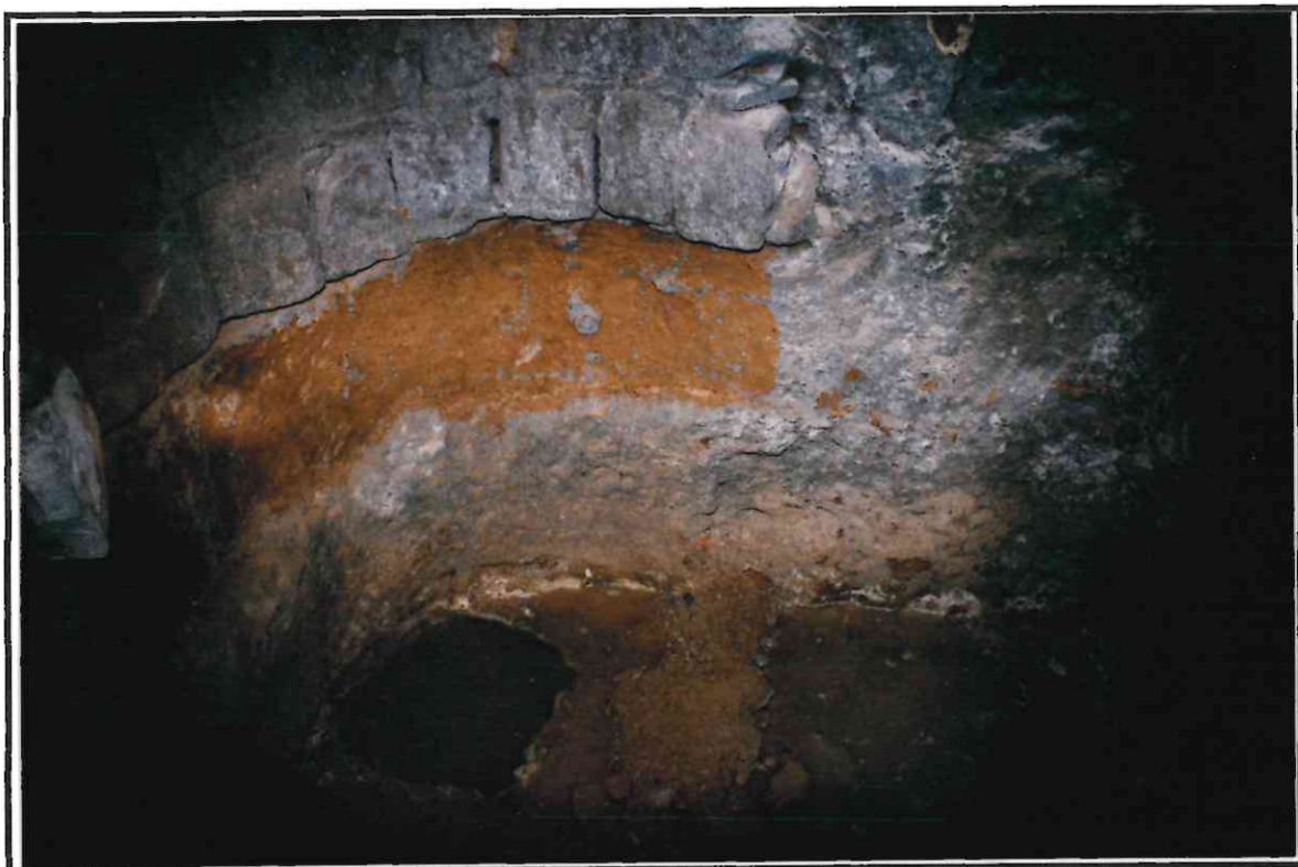
F.7. Detall de la part obrada del pou de la sínia i com talla el terreny natural.
