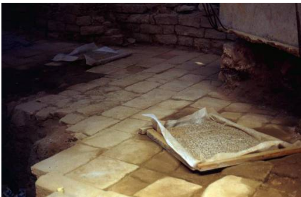
Zonas protegidas con Geotextil y arena estéril
