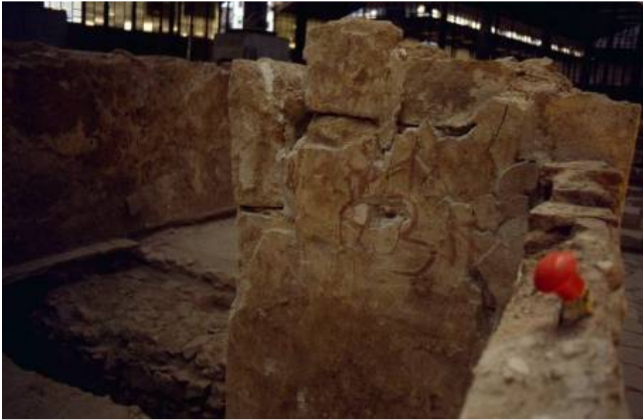
Limpieza y consolidación de revestimientos con mortero de cal.
