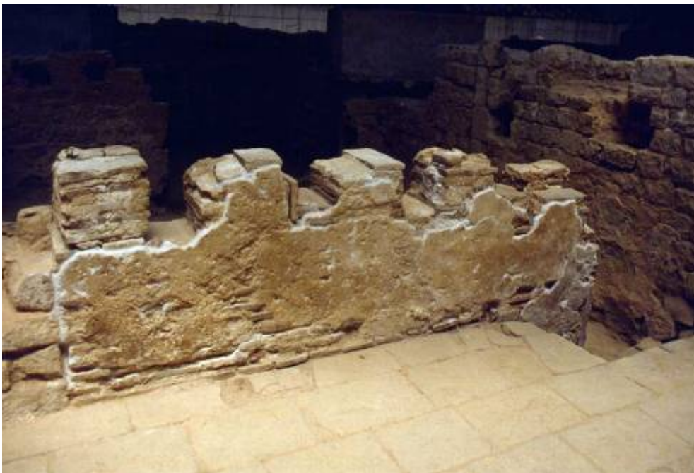
Limpieza y consolidación de revestimientos con mortero de cal.
