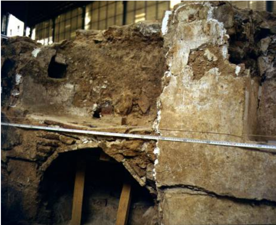
Apuntalamientos provisionales en una cocina.
