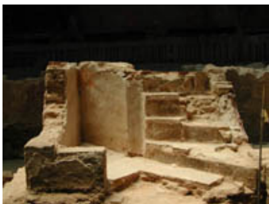
Escalera de caracol ue 619.
