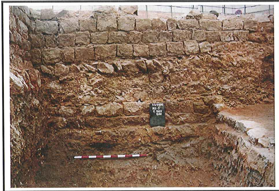
Alçat del mur E. 1003 on s'observen les dues fases constructives.
