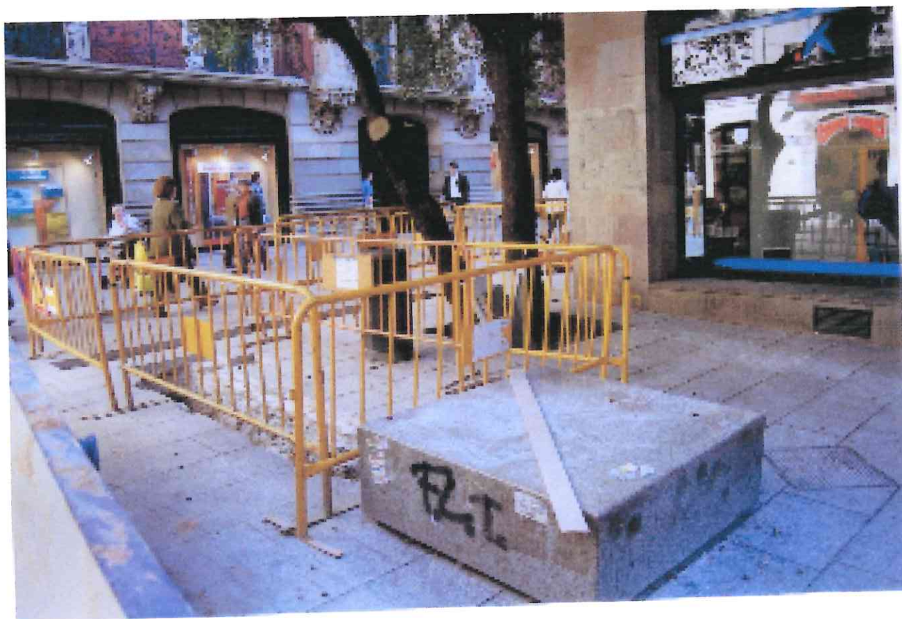
FOTO 6 Vista de la intervenció amb la cala de prova 6 ( U.E. 600 )
