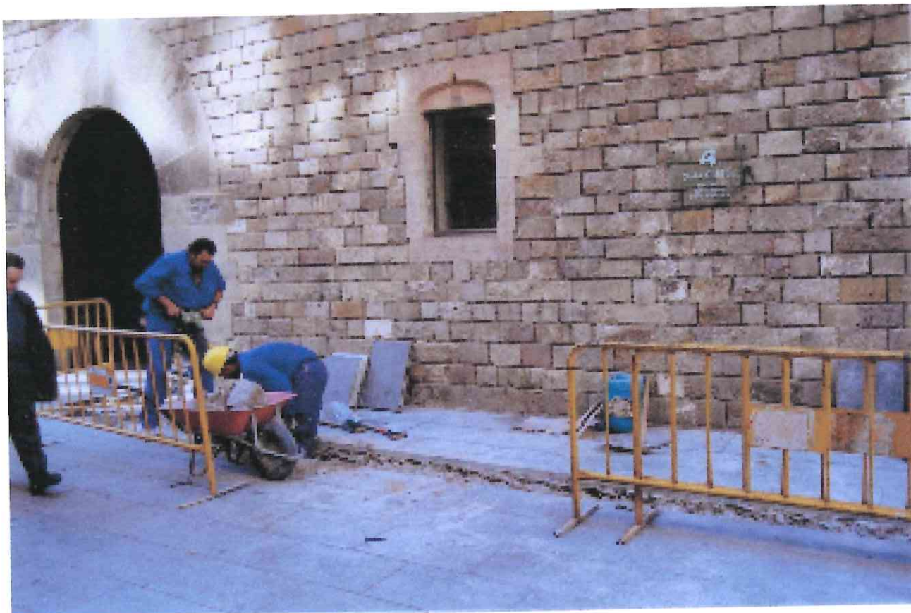
FOTO 5 Treballs d'obertura de la rasa 1 ( U.E. 1000 )
