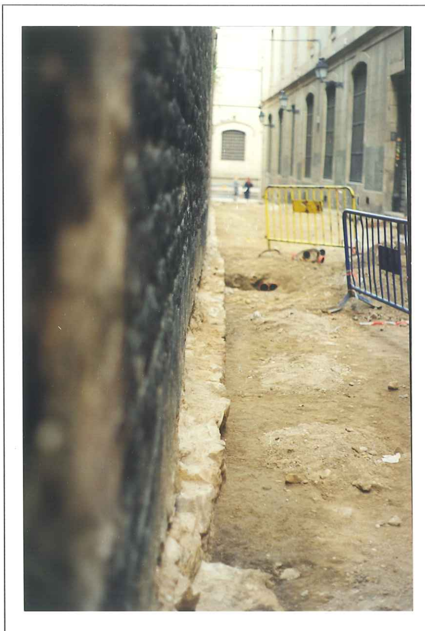
FOTO 1. Vista general de la fonamentació de la façana oest de l'església dels Sant Just i Pastor, al carrer Hèrcules.
