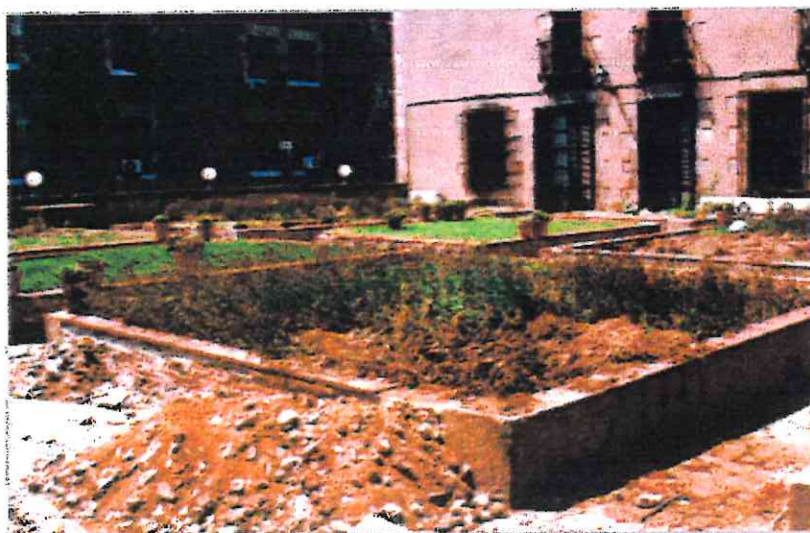
Fot.8 Sector 900. Detall pati de la planta superior abans de la reforma.
