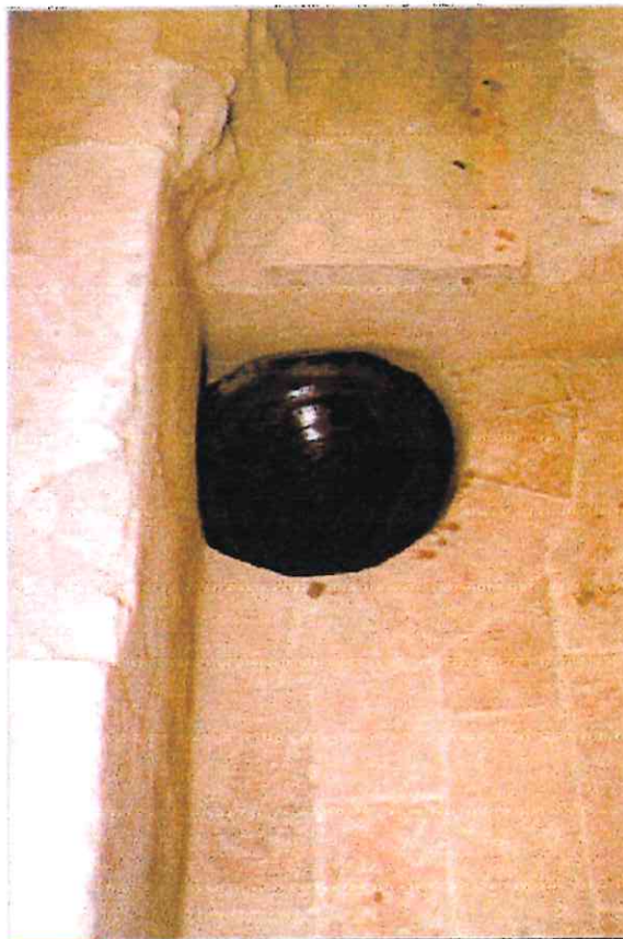
Fot.11 Sector 1500. Detall del desguàs del trull de l'oli. (UE 1505).
