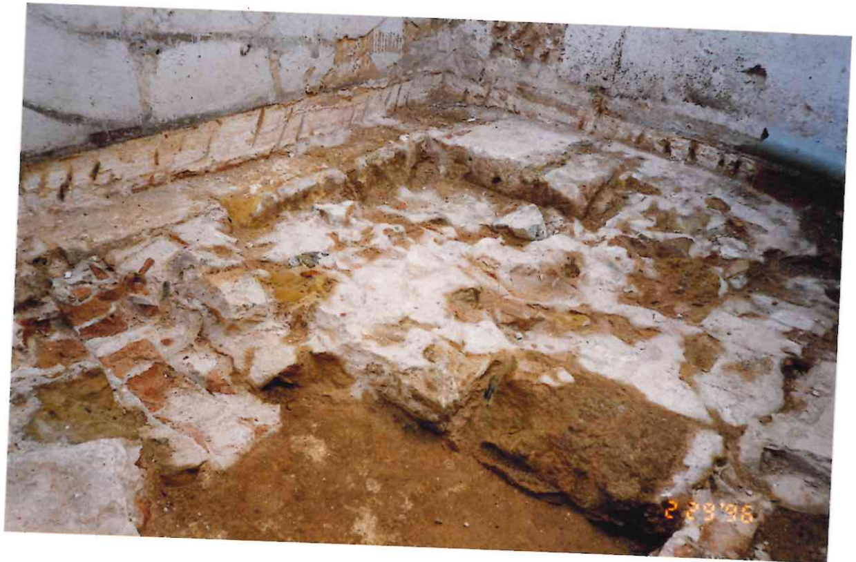
Figura 9.- Vista general del pati.S'observa l'angle NO de la torre número 62.
