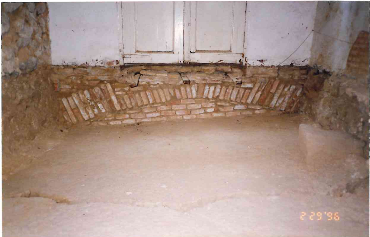
Figura 4.- Vista general de les parts baixes de les parets de L'habitació i el paviment d'Opus signinum del pas de ronda de la muralla. Al fons s'observa l'arc de descàrrega del balcó.
