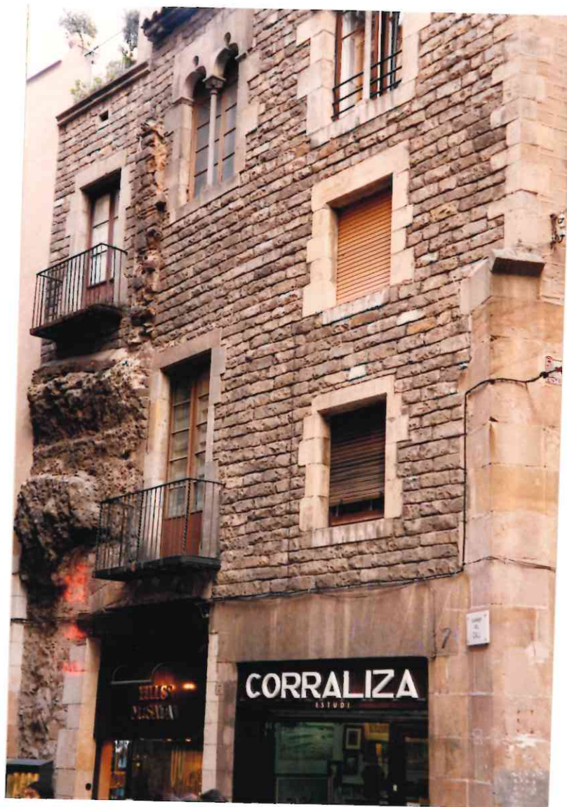
Figura 1.- Vista del jaciment des del carrer del Call.
