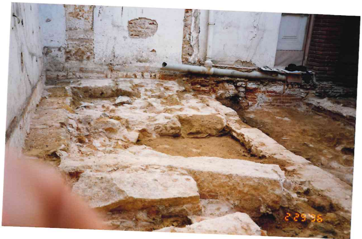
Figura 7.- Vista general del pati.S'observa l'angle oest de la torre número 62.
