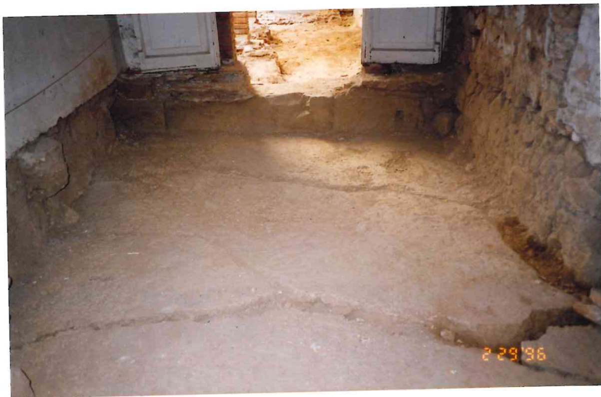
Figura 5.- Vista de l'entrega del paviment d'Opus signinum del pas de ronda a la paret de la torre número 62.
