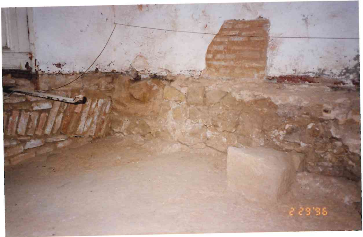
Figura 3.- Vista del parapet,carreu encastat i paviment d'Opus signinum del pas de ronda de la muralla.
