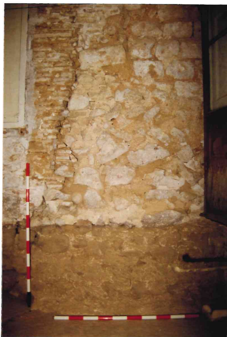
Figura 2.- Vista de la paret A de l'habitació i del paviment d'Opus signinum del pas de ronda de la muralla.
