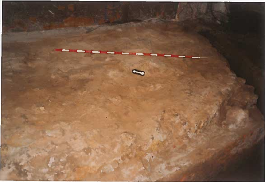
FOT.5 Rebliment intern de la torre Baix Imperial (opus caementicium) adosat al qual, es troba la paret de maons del clavegueram general de la finca.
