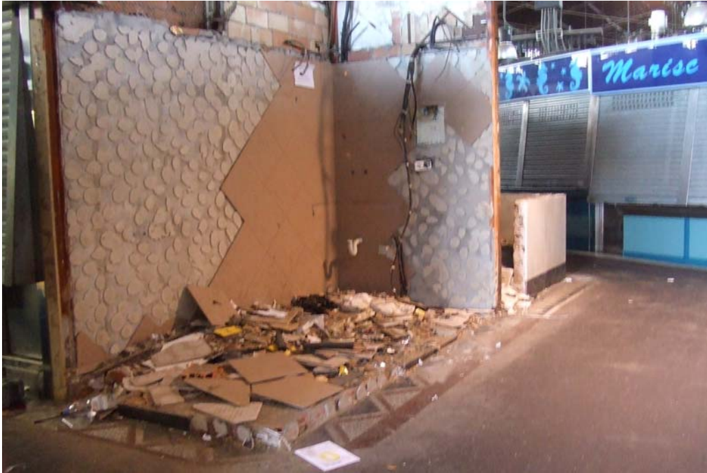
Fotografia núm. 1: estat de les parades a l'inici dels treballs
