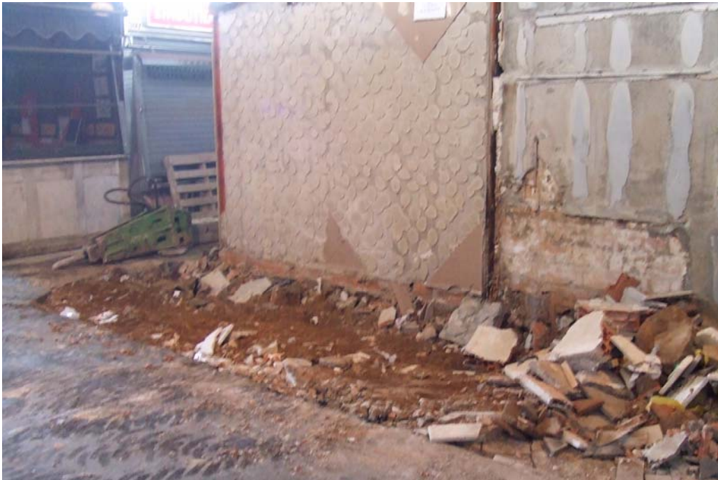
Fotografia núm. 2: estat de les parades a l'inici dels treballs
