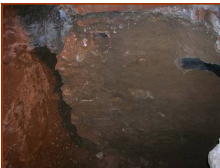
Fotografia 6. Mur fet amb pedres i morter ataronjat de sorres i calç UE108
