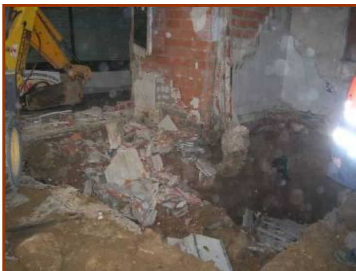
Fotografia 3. Vista general rebaix parada 594-595-596
