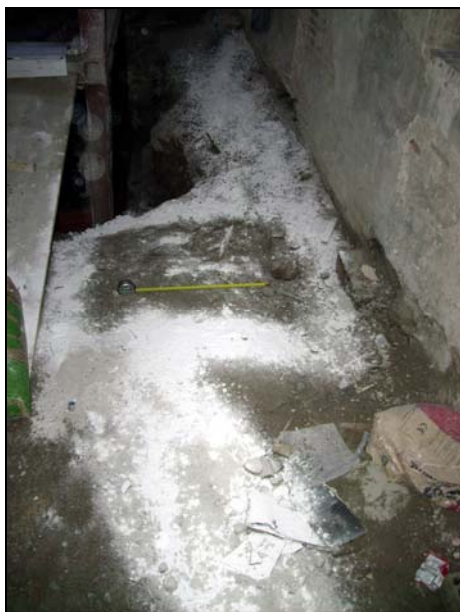
FOTO 1. Pati de llums de la finca amb arqueta i part de la rasa marcats
