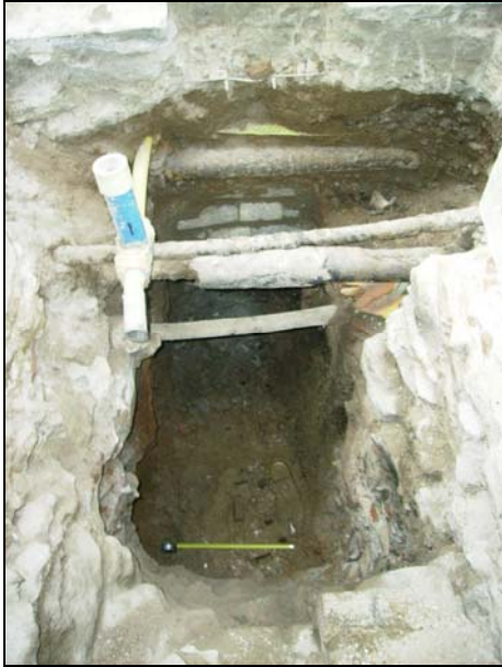
FOTO 9. Rasa 2 en via pública. En primer terme, fonament (UE 8) i, al fons, serveis (UE 4)
