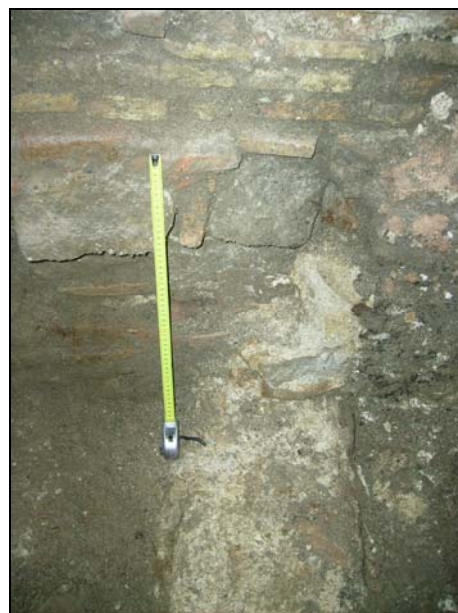
FOTO 6. Fonament UE 18, cobert en part per la fonamentació UE 13
