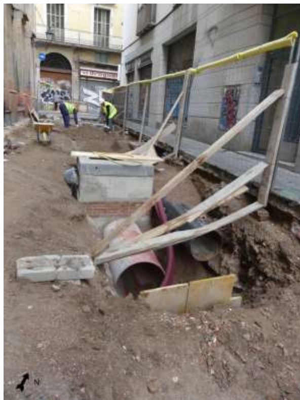
Imatge 23. Imatge del formigonat i cobriment dels nous serveis de RSU i clavegueram al Carrer de L'Est.
