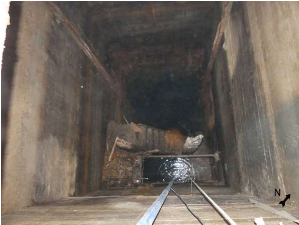
Fotografia 1. Imatge de l'interior del pou. Es poden veure les restes d'una escala i dues bigues laterals que sustentaven el muntacàrregues.
