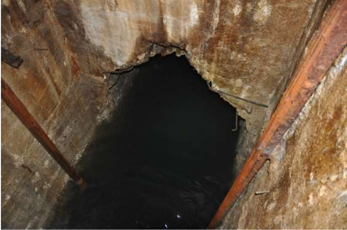
Fotografia 3. Imatge de les bigues que sustentaven el muntacàrregues del pou i un accés. Autoria: Mossos d'Esquadra.
