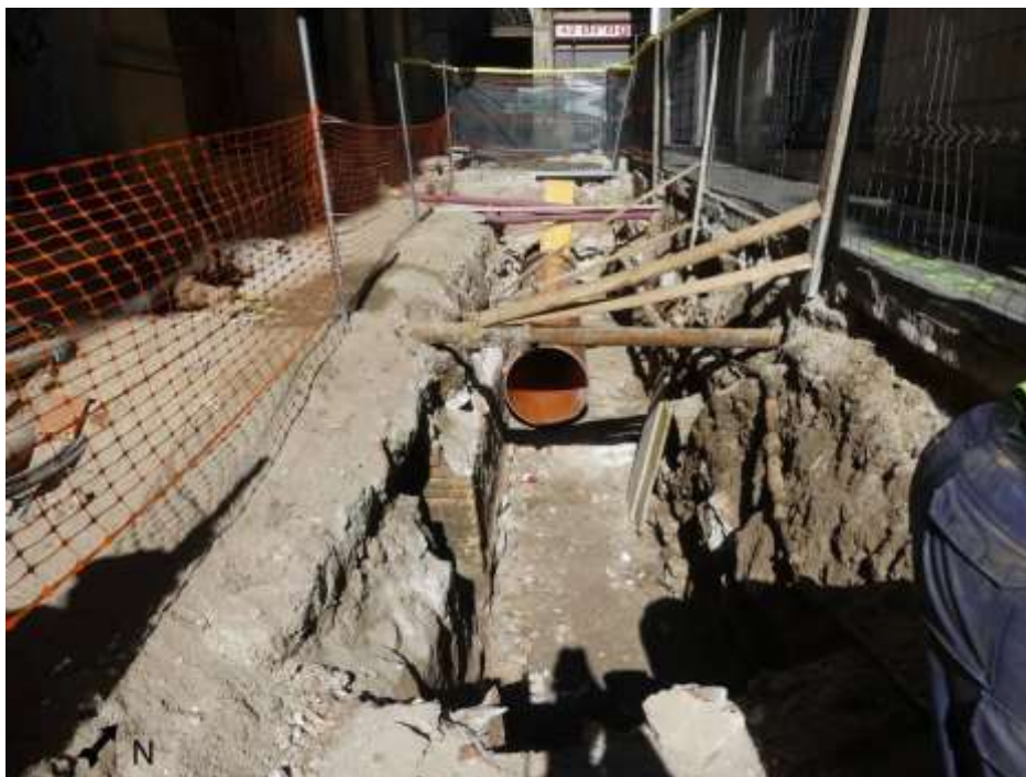
Imatge 20. Imatge de la instal·lació del tub de RSU seguint el tram de l'antic col·lector al Carrer de L'Est.
