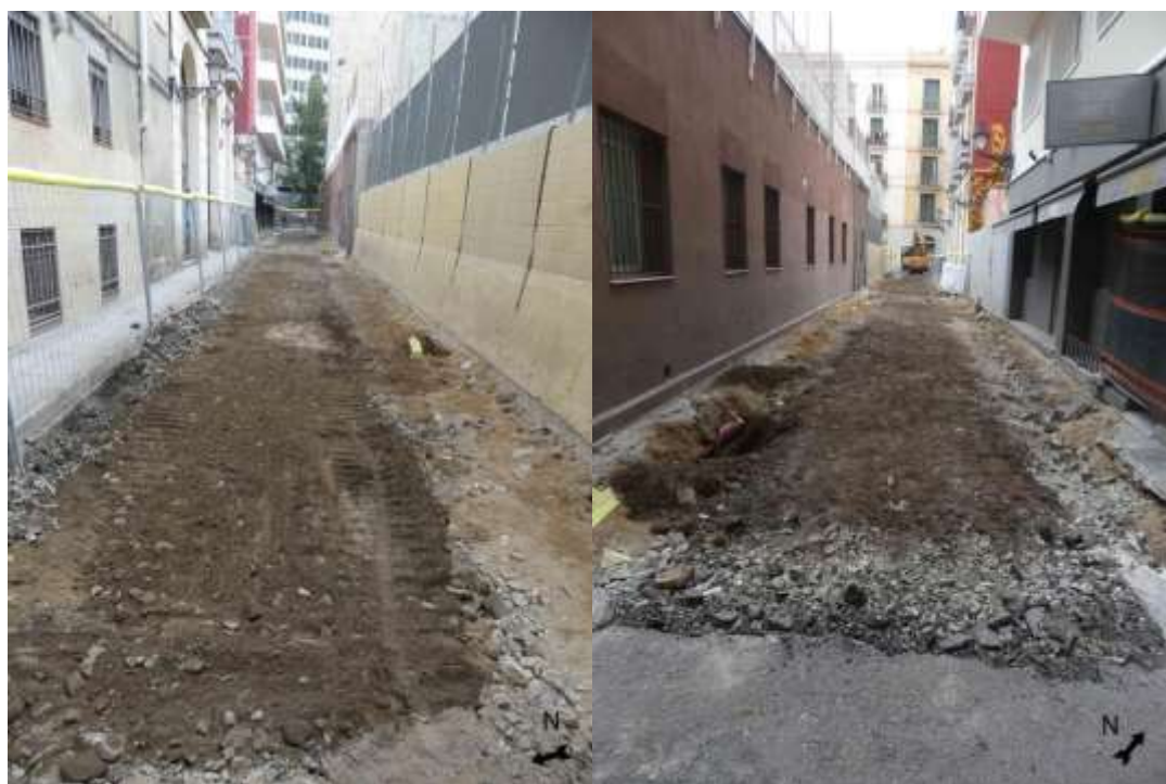
Imatge 33. A l'esquerra, imatge del procés d'excavació, vista des del NO. A la dreta, imatge del procés d'excavació, vista des del SE.
