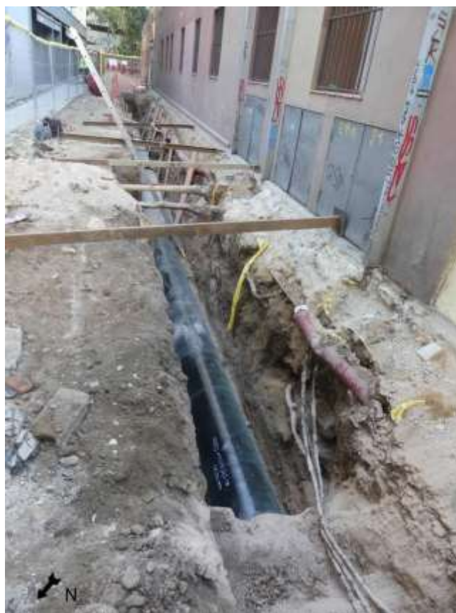
Imatge 39. Imatge de la instal·lació del tub de clavegueram.
