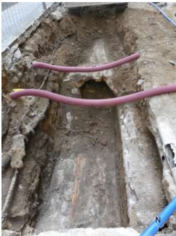
Imatge 4. Imatge de la demolició del col·lector al Carrer de L'Est.
