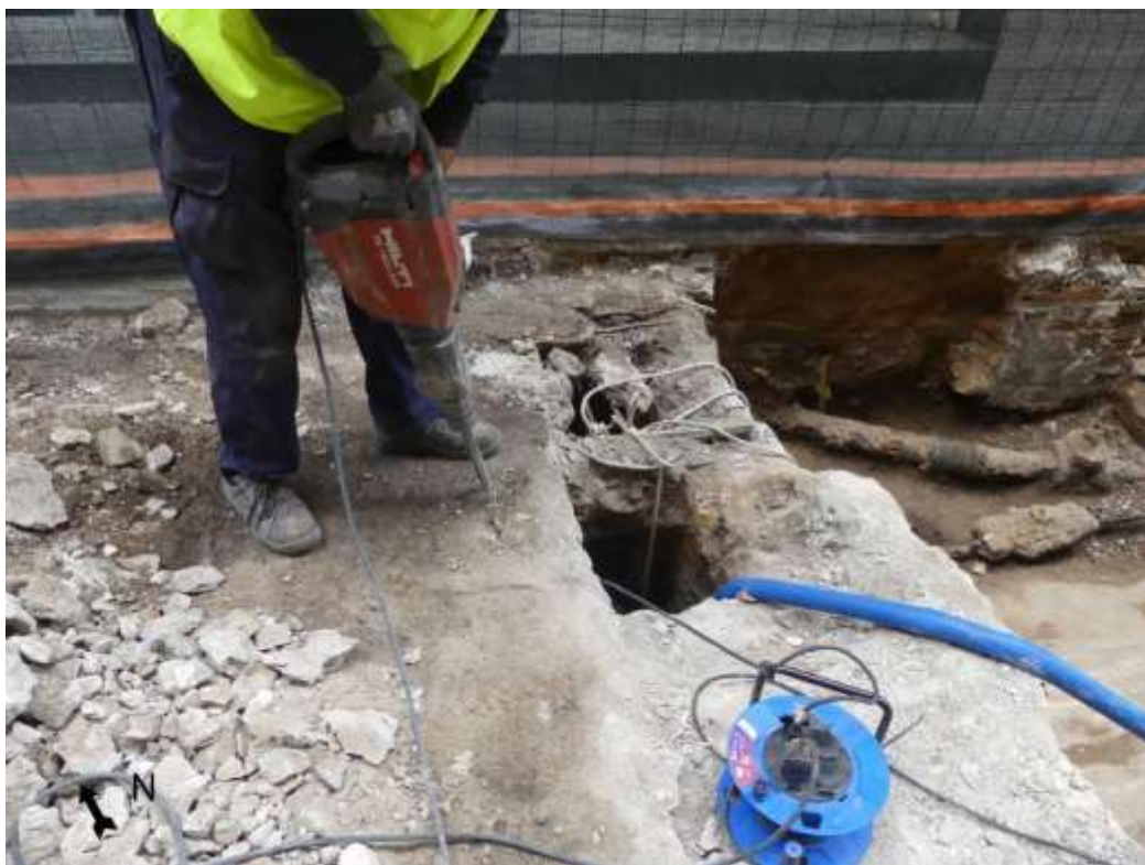
Imatge 5. Imatge de la descoberta del mur 1003 i el pou d'atac del metro de 1931-1933.
