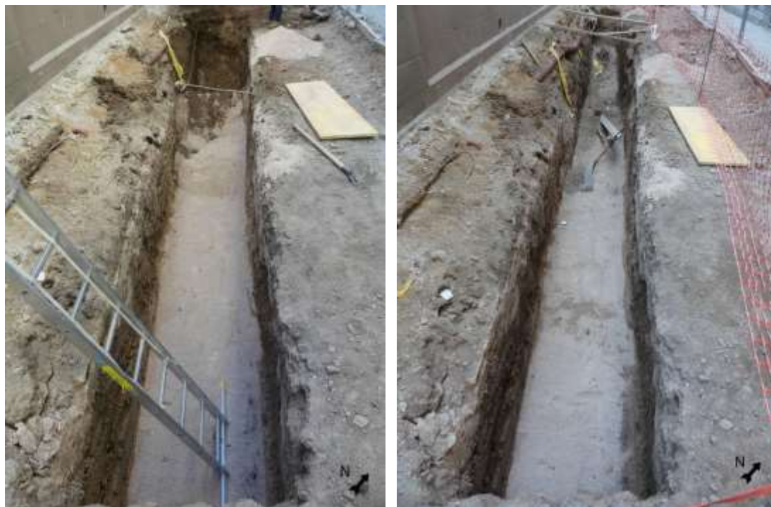
Imatge 38. Imatges del procés de cobriment de la rasa
