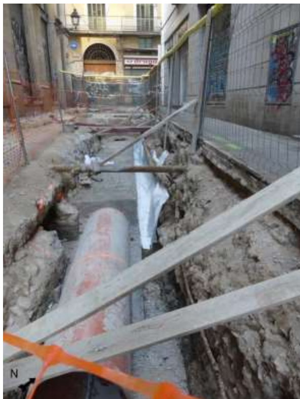
Imatge 22. Imatge del formigonat que cobreix el tub de RSU al Carrer de L'Est.
