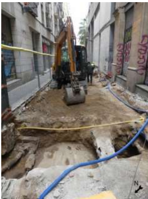
Imatge 2. Imatge del procés d'excavació del farciment sota el paviment actual al Carrer de L'Est.
