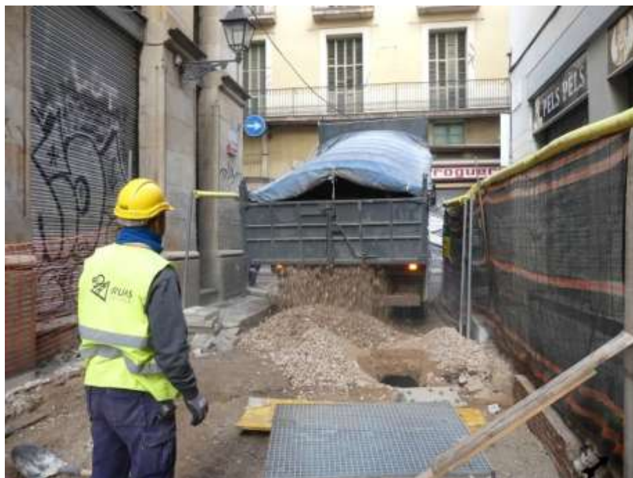
Imatge 19. Imatge del cobriment del pou d'atac del metro amb grava.
