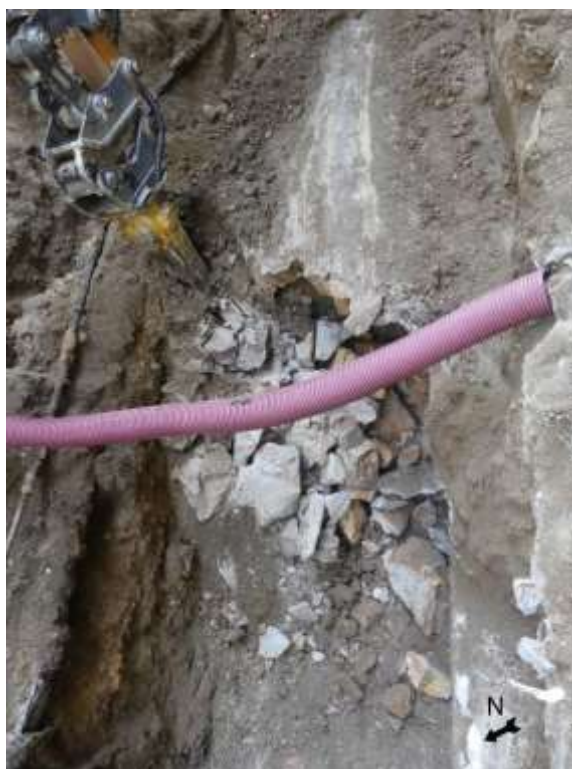
Imatge 3. Imatge de la demolició del col·lector al Carrer de L'Est.
