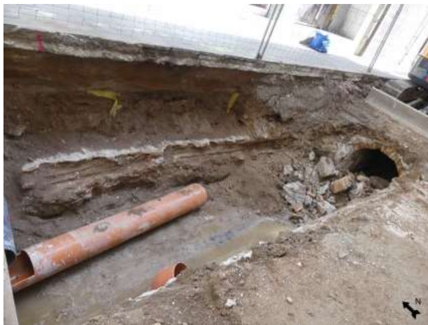
Imatge 21. Imatge de la instal·lació del tub de RSU seguint el tram de l'antic col·lector al Carrer de L'Est.
