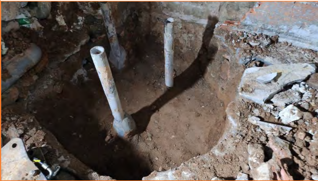
Foto 29. Vista del P.14 on es pot observar la fonamentació del mur UE 7.
