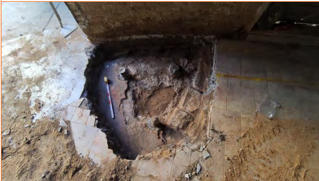
Foto 31. Vista del paviment UE 10 i de la claveguera UE 32 al P.6.
