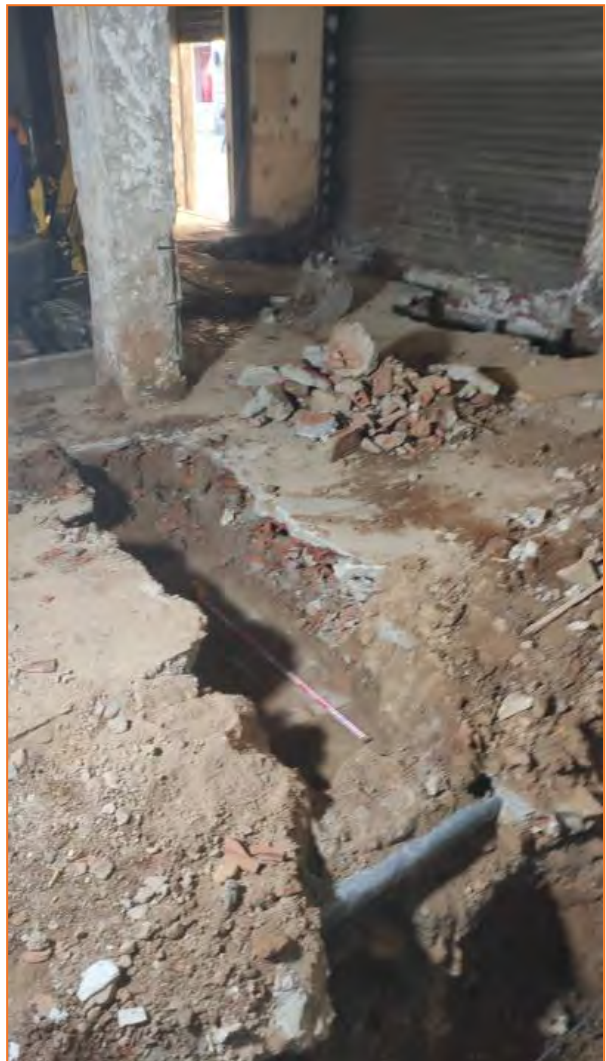
Foto 12. Vista del paviment UE 20 a la riostra entre P07 i P08.
