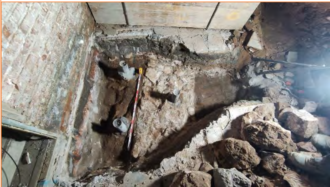
Foto 34. Vista de la fonamentació UE 36 al P.13.
