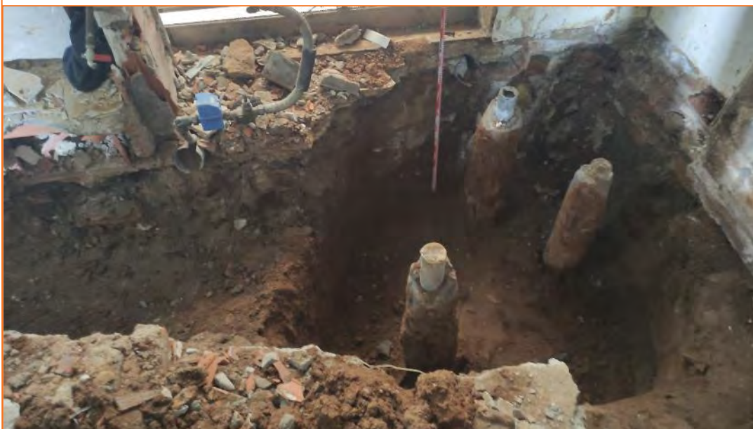
Foto 26. Vista de la fonamentació UE 18 a P.01.
