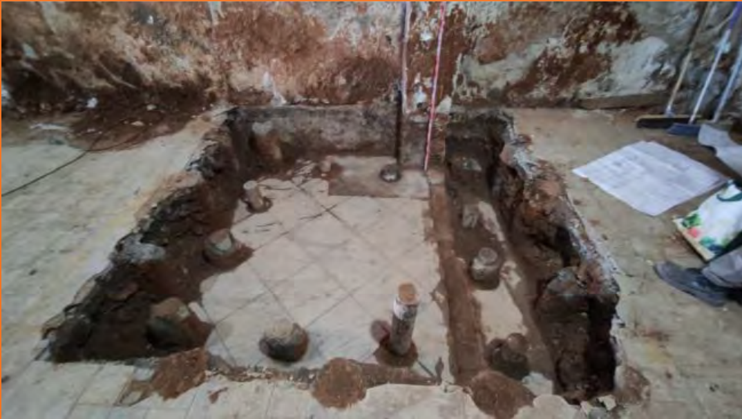
Foto 15. Vista del paviment UE 3 al fossat de l'ascensor – grua.
