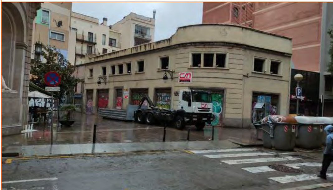
Foto 1. Vista de l'edifici on s'ha realitzat la intervenció.
