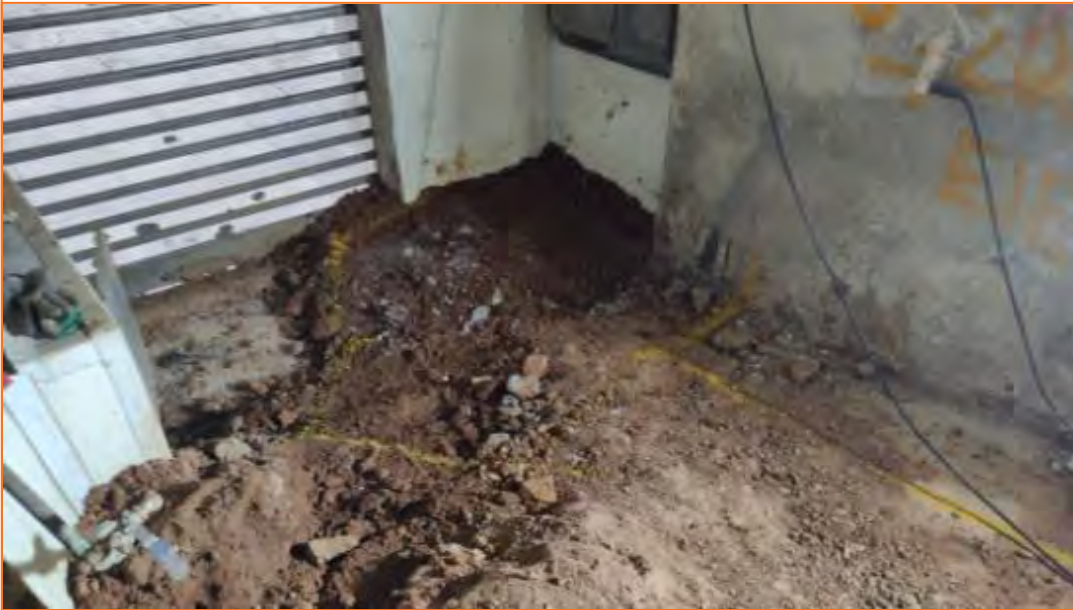
Foto 7. Vista de la riostra entre P01 i P07.
