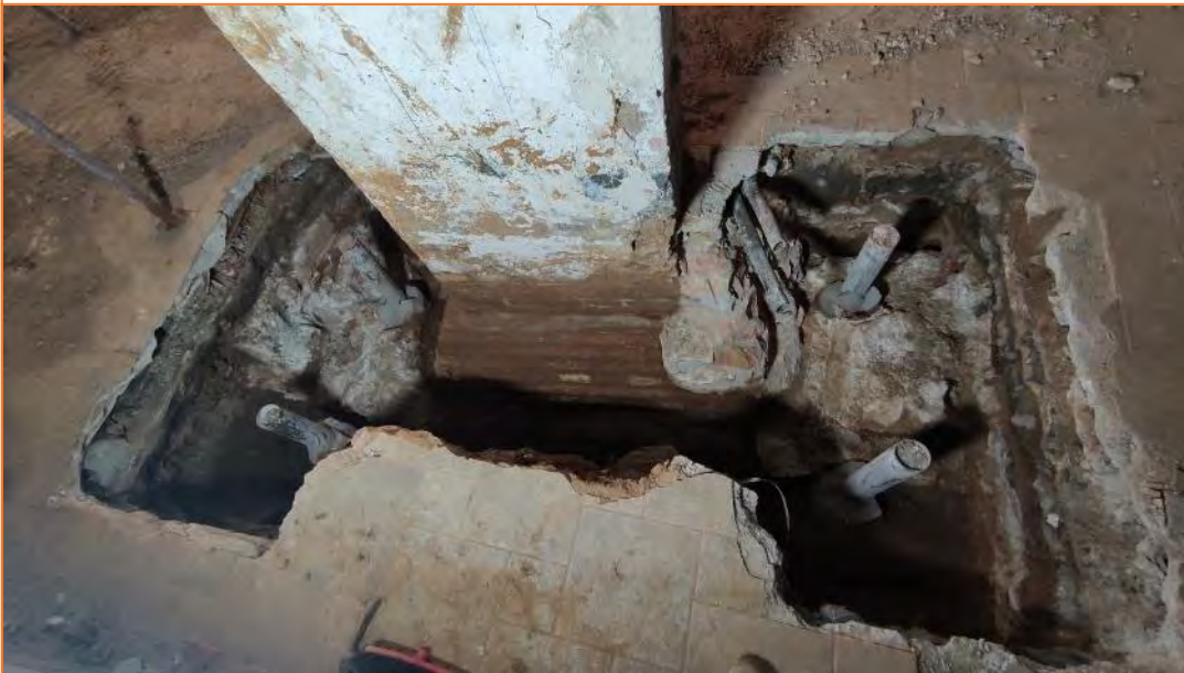
Foto 27. Vista del pilar UE 18 i la fonamentació UE 22 a P.10.
