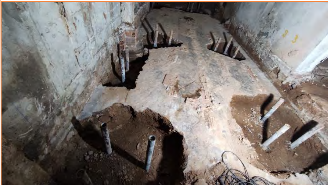
Foto 28. Vista de la UE 3 al Sector 2.
