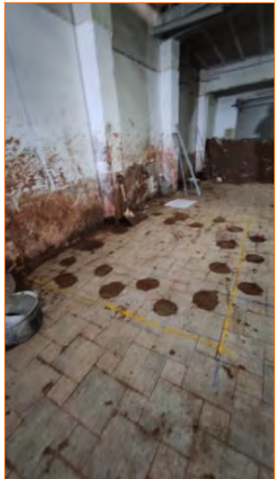
Foto 14. Vista inicial del fossat de l'ascensor - grua.
