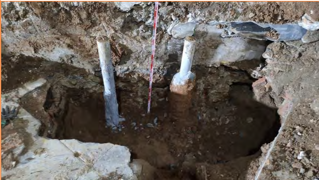
Foto 30. Vista del P.21 on es pot observar la fonamentació del mur UE 5.
