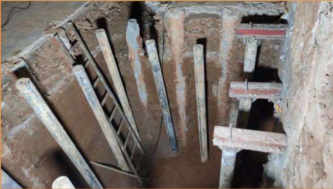
Foto 17. Vista final del rebaix del fossat de l'ascensor - grua.
