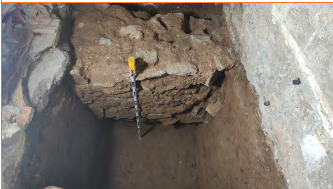
Foto 10. Vista de la fonamentació UE 26.
