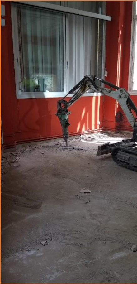
Foto 10. Foto d'exemple de la retirada de paviment al menjador.
