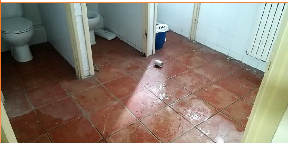
Foto 3. Foto inicial de la zona del lavabo.
