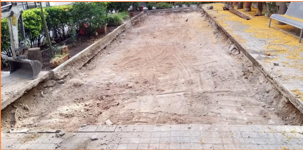
Foto 8. Foto final del rebaix a la zona del jardí.
