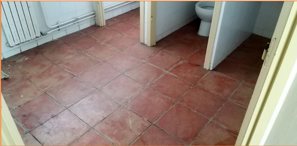
Foto 4. Foto inicial de la zona del lavabo.
