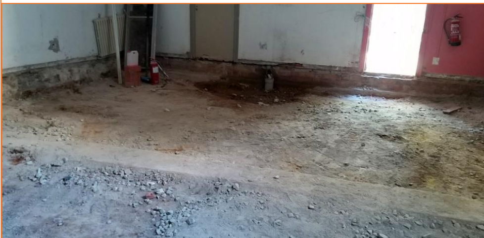
Foto 9. Foto final del rebaix a la zona polivalent.
