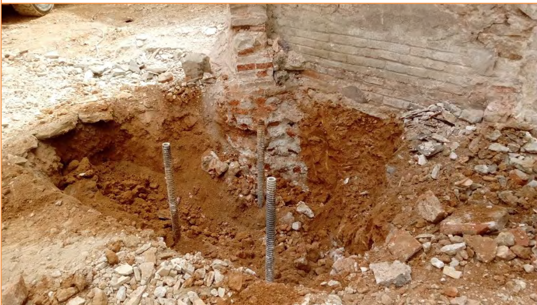
Foto 12. La riosta de fonamentació UE 12 a l'encepat 4.
