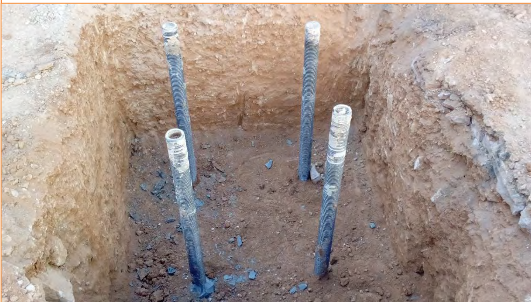
Foto 16. Estat final de l'excavació de l'encepat 8.
