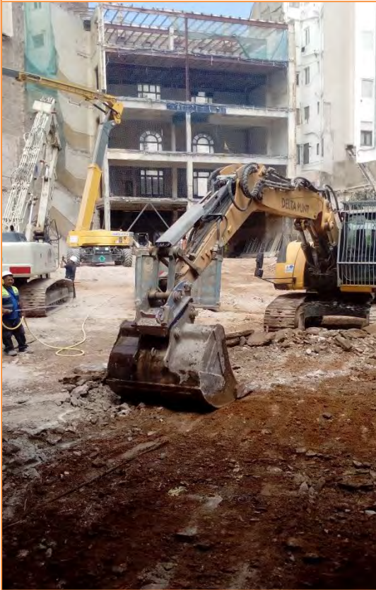
Foto 3. Procés de retirada de la solera de formigó UE 1.
