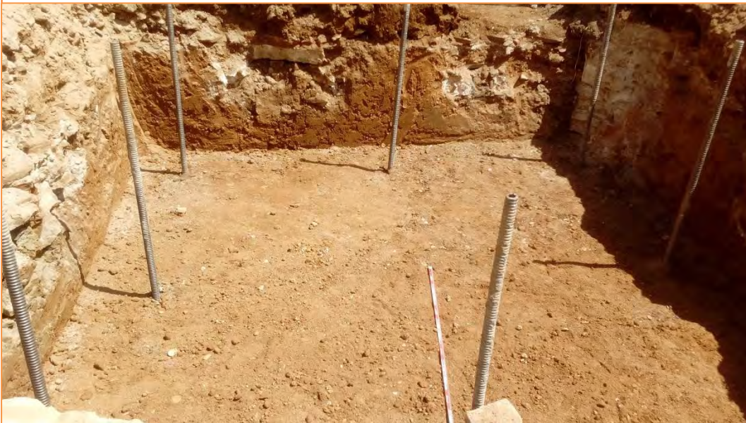
Foto 8. Estat final de l'excavació del fossat de la grua.
