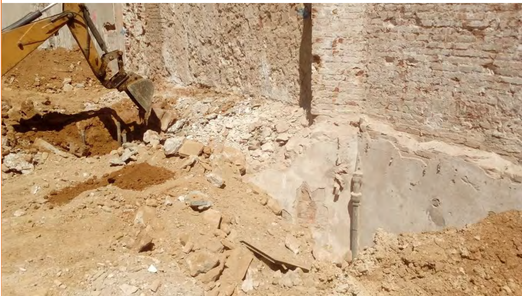
Foto 20. Vista de l'excavació de l'encepat 12, adossat al soterrani de la finca.
