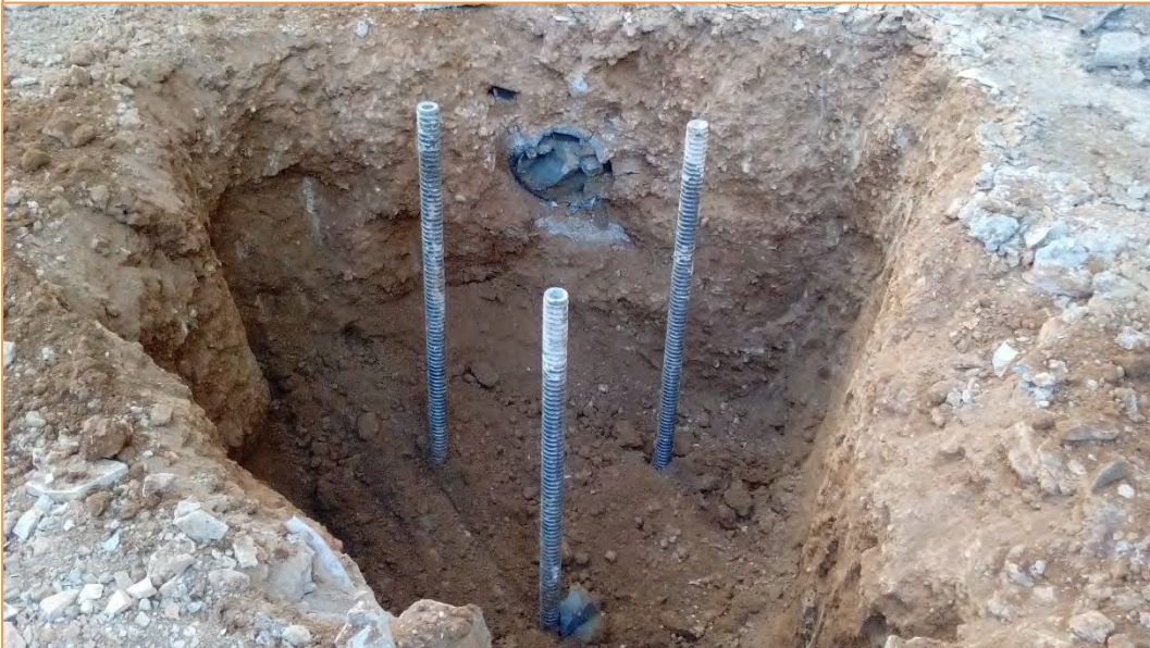
Foto 18. L'encepat 10 amb el tub de pluvials tallat en secció.
