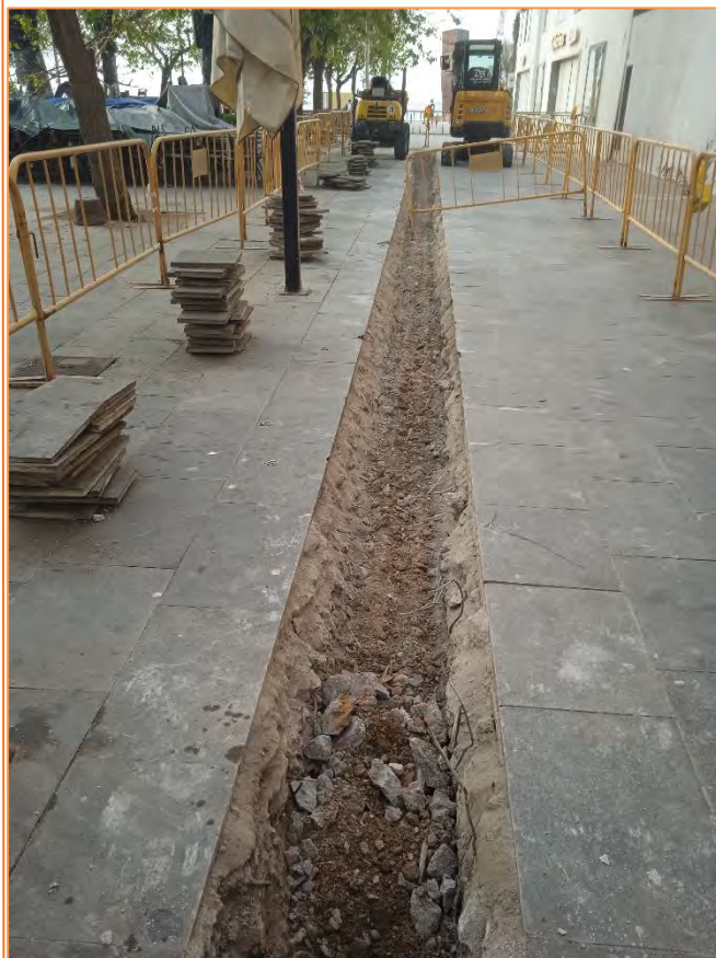
Foto 2. Retirada del paviment superficial UE 1 i aparició de l'estrat d'anivellació UE 2.
