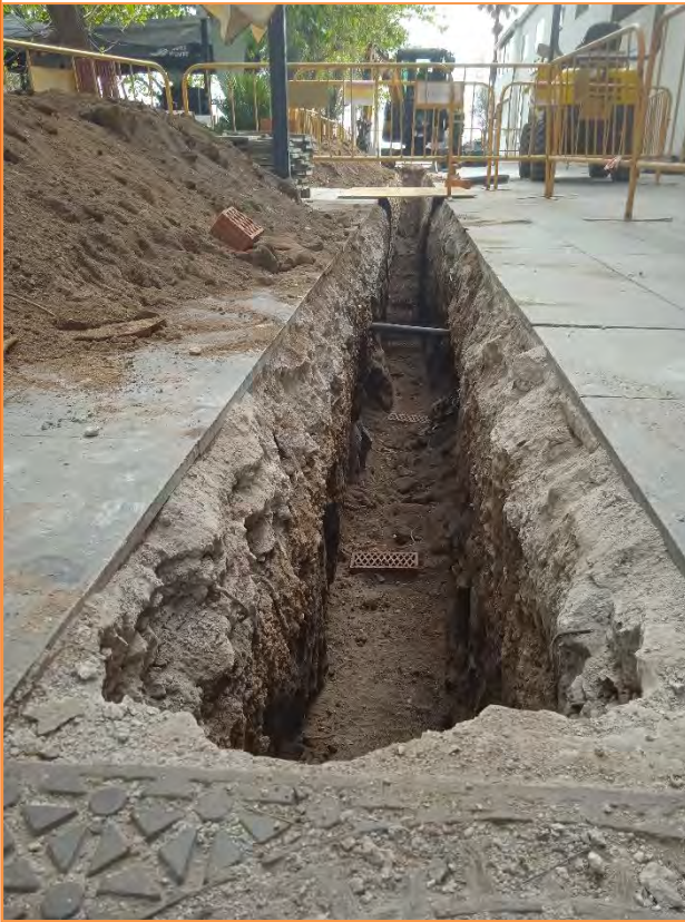
Foto 3. Rebaix de la UE 2 per a l'escomesa del sanejament.
