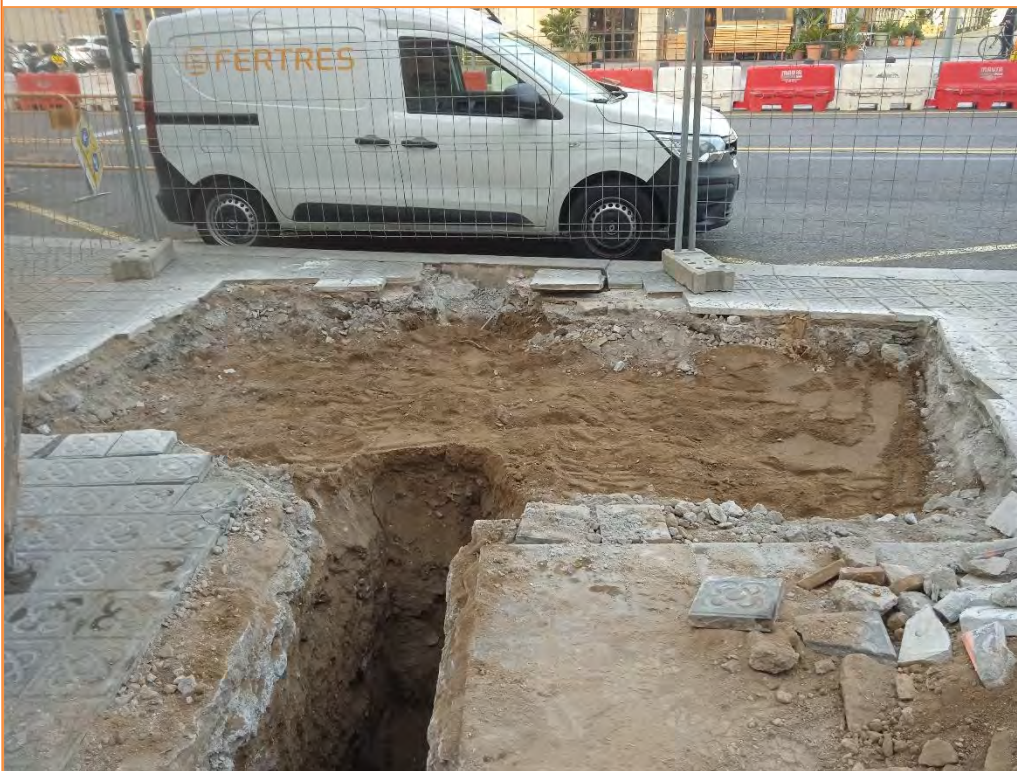
Foto 13. Calaix de la cabina a la plaça del Mar amb UE 4.
