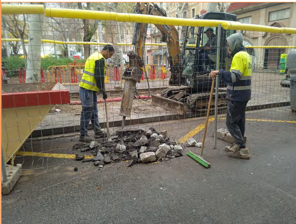
Foto 20. Eliminació de l'asfaltat UE 6 a la rasa de sanejament.
