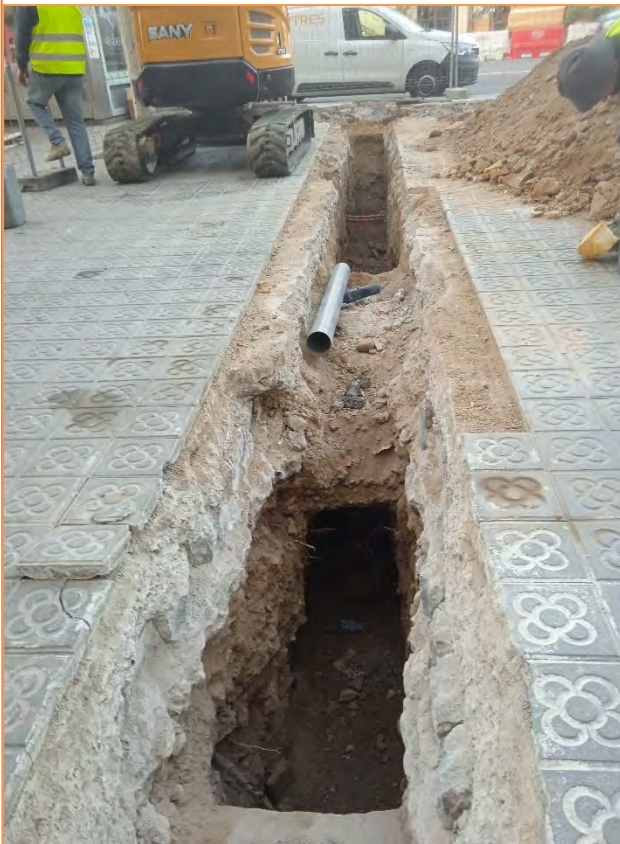
Foto 11. Rebaix de la UE 4 amb minat d'un prisma de telefonia.
