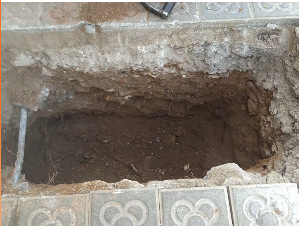
Foto 15. Detall del rebaix de la UE 4 per a disposar-hi la connexió amb el servei d'aigua.
