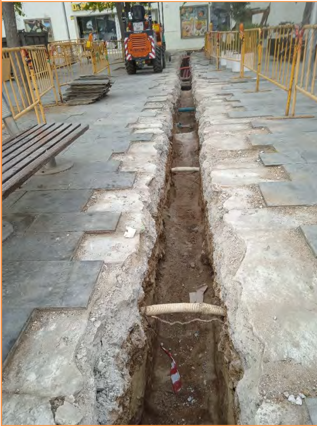
Foto 7. Obertura de la rasa del servei elèctric al carrer Àtlàntida.
