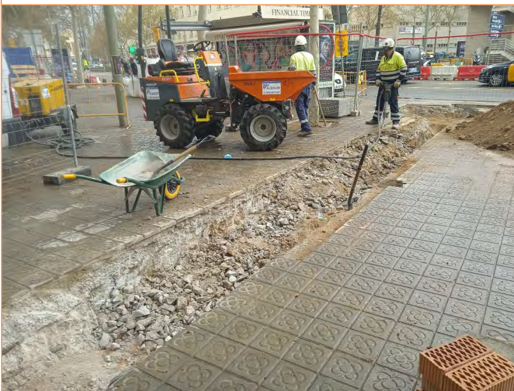
Foto 14. Obertura de la rasa de la llum adossada a la rasa de sanejament. Repicat del paviment UE 3.
