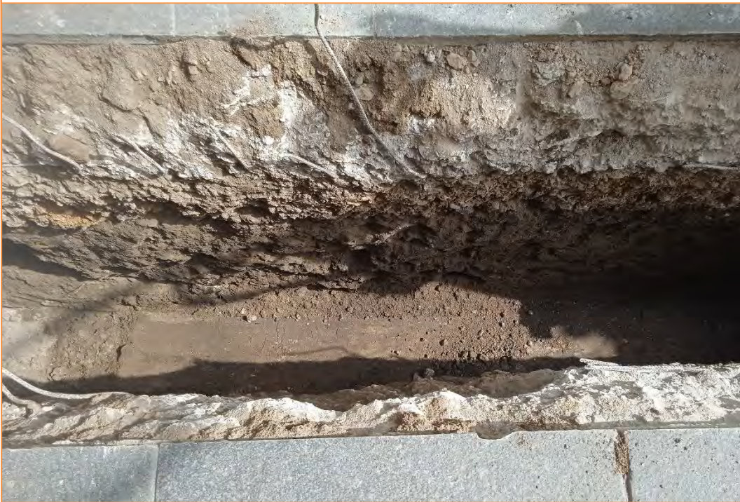
Foto 4. Detall de la UE 2 a la rasa de sanejament.
