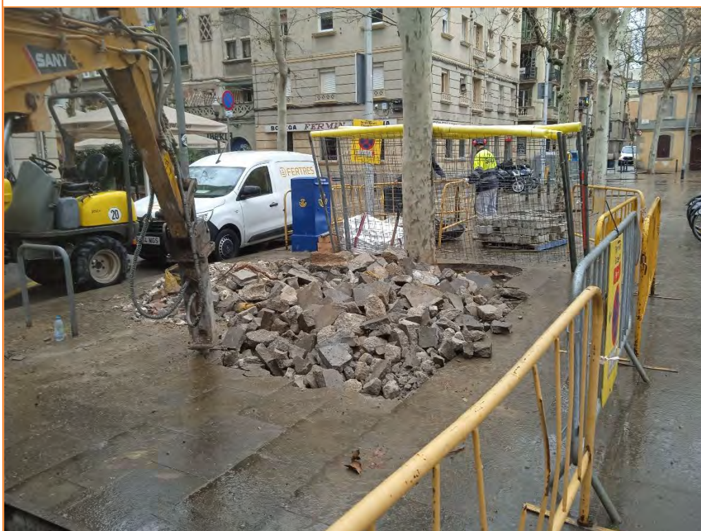
Foto 17. Eliminació del paviment UE 5 a la plaça del Poeta Boscà.
