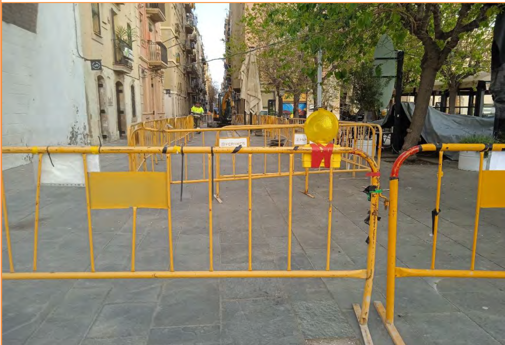
Foto 1. Estat inicial de la intervenció al carrer de l'Àtlàntida.
