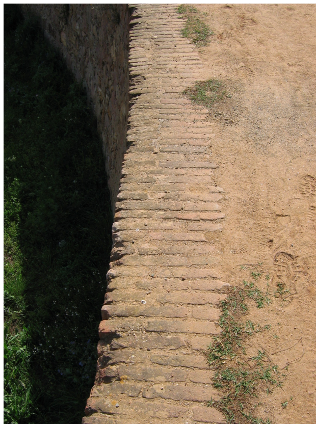
Imatge 6. Coronament de la contraescarpa del fossat del castell de Monjuïch.
