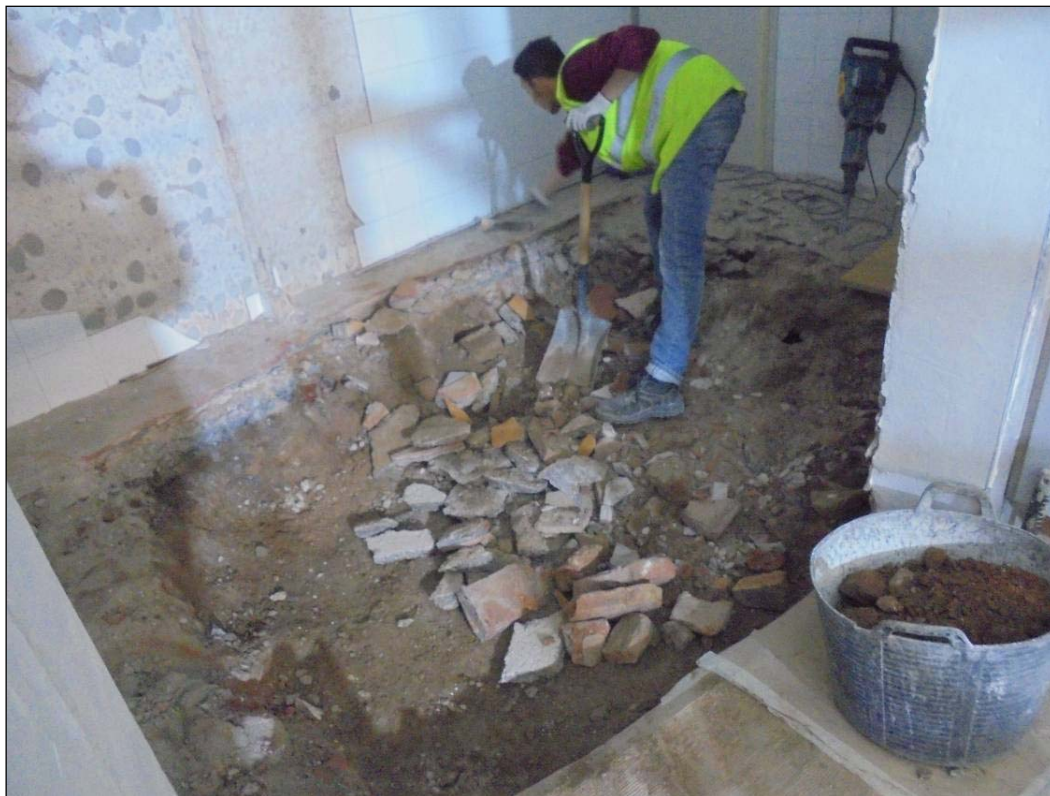
Fotografia 24: Rebaix de 40 cm del terra de la Zona 3.
