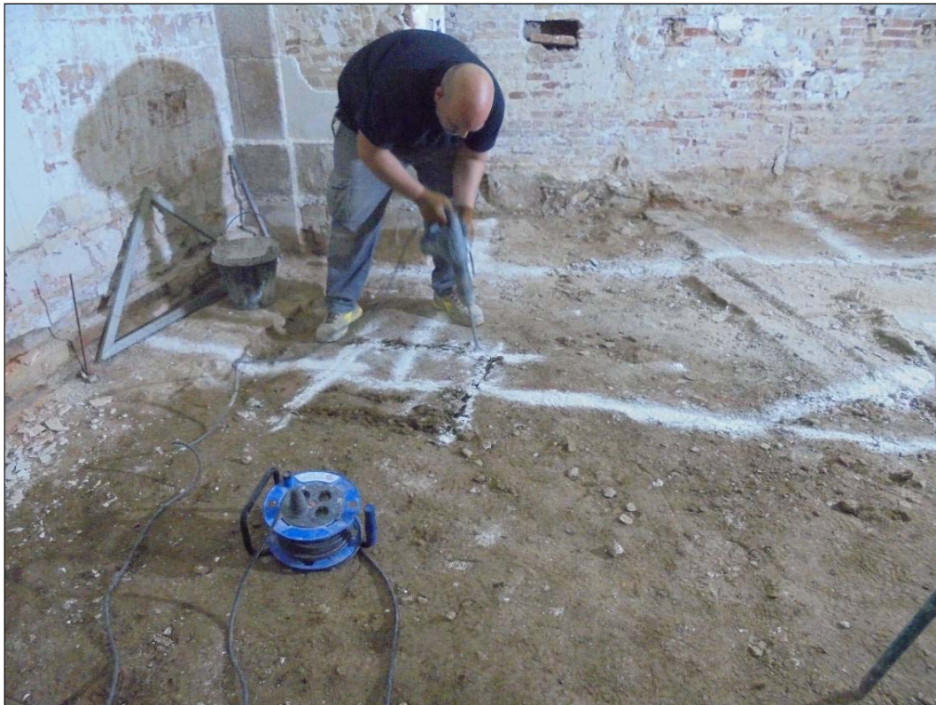
Fotografia 20: Inici excavació de l'arqueta de desguàs general dels nous serveis.
