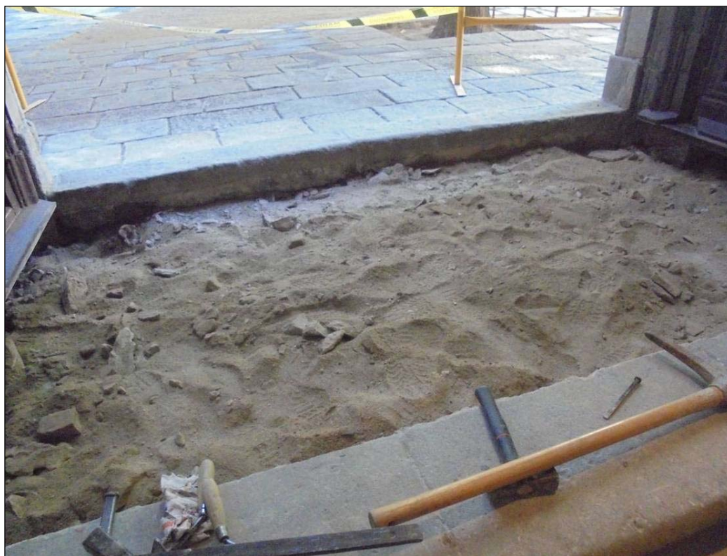
Fotografia 4: Detall de la sorra sota les pedres de pavimentació.
