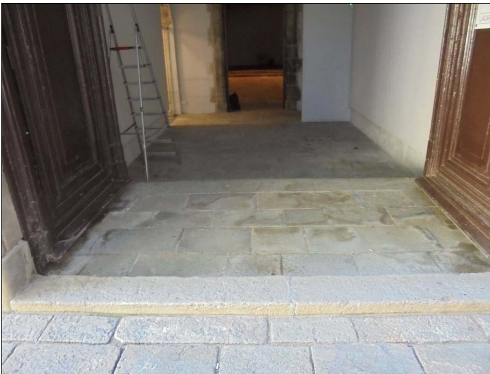
Fotografia 2: Vista de l'entrada al vestíbul que precedeix a La Capella abans de les obres.
