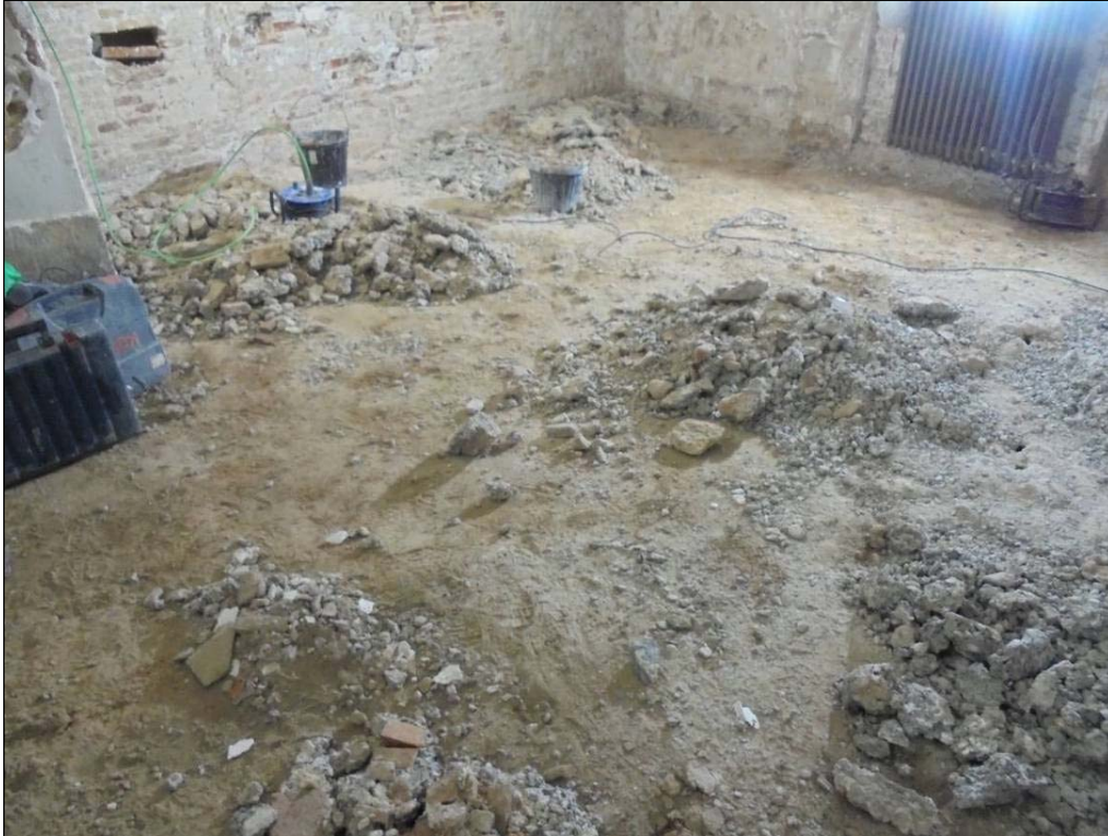
Fotografia 9: Vista general de la zona de magatzem sense les rajoles del paviment.
