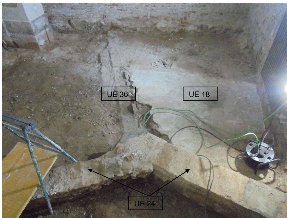
Fotografia 26: Vista general de l'espai de magatzem després dels desmuntatges, amb les restes conservades: solera UE 36, solera UE 18 i claveguera UE 24.
