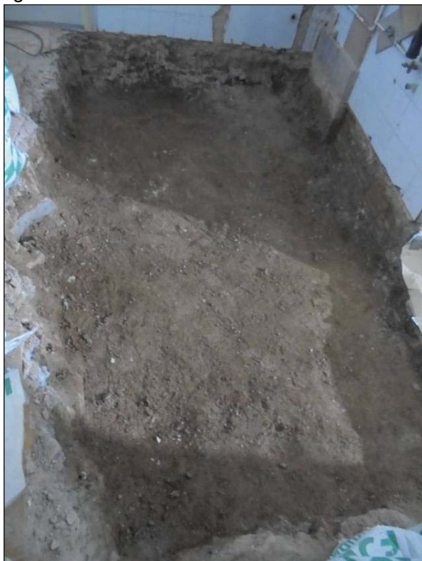
Fotografia 24: Rebaix de 40 cm del terra de la Zona 3.
