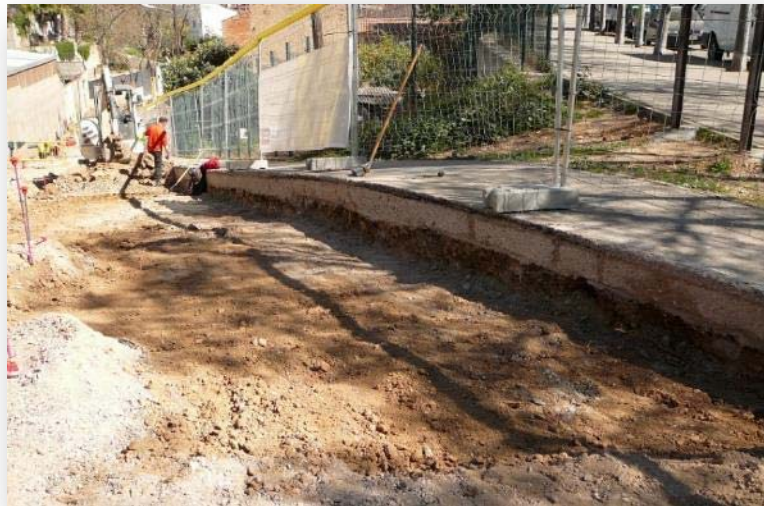
Rebaix a la zona de la cruïlla Carrer d'Alarcón/carrer de Lisboa
