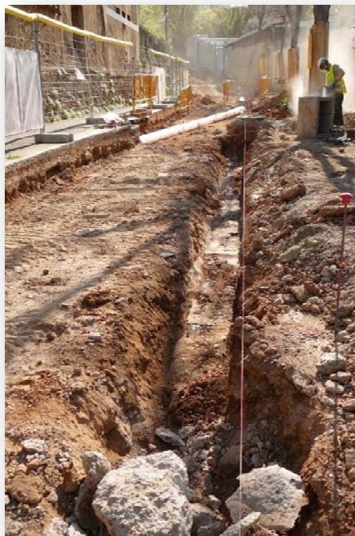
Exemple de rasa practicada en el Tram 2 del carrer d'Alarcón
