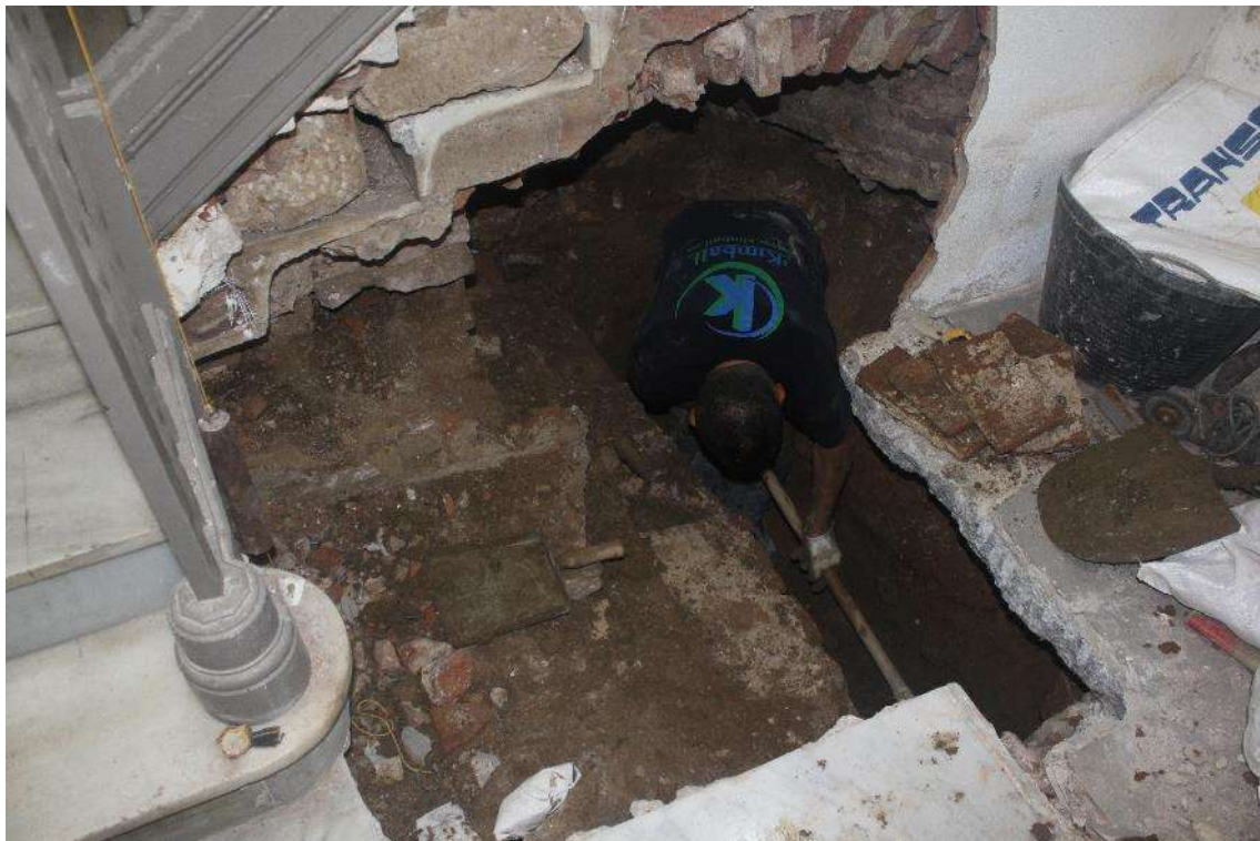
Procés d'excavació manual de la fossa (PL. Artigues 2019).
