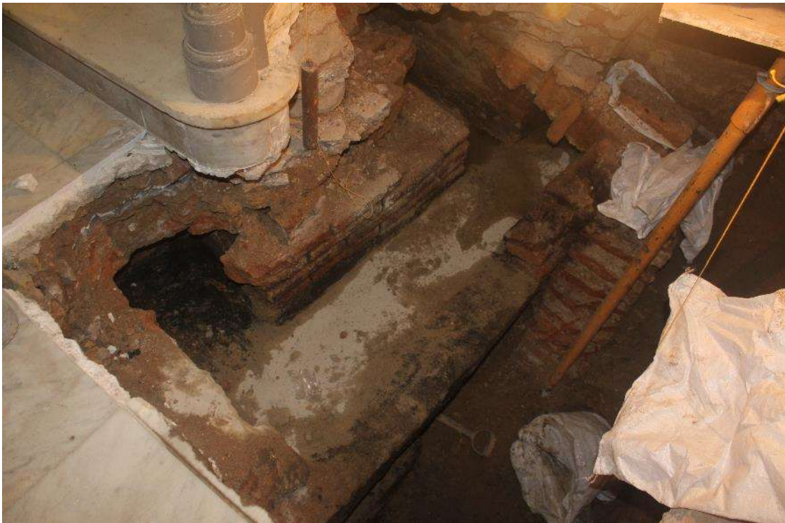
Vista del col·lector UE 113 després d'haver desmuntat la seva coberta on es poden veure les conduccions laterals (PL. Artigues 2019)
