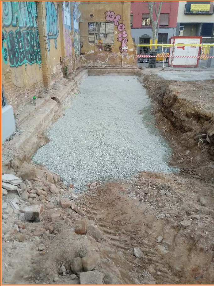
Foto 15. Cobriment final amb graves de la superfície excavada.
