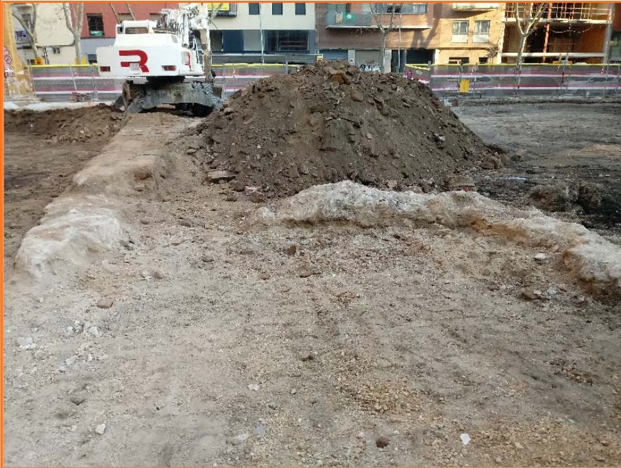
Foto 5. Vista dels murs UE 3 i 4, a poca distància del mur UE 2.
