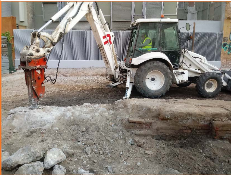
Foto 13. Control del desmuntatge del mur UE 2.
