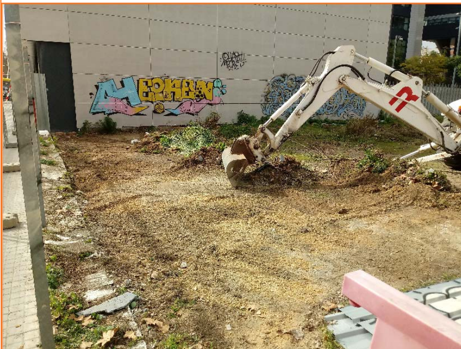
Foto 2. Seguiment dels treballs de desbrossat del solar.
