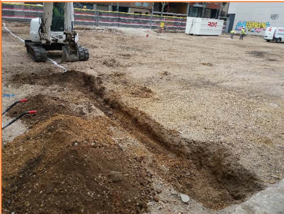
Foto 14. Control de l'excavació de la rasa de l'enllumenat.
