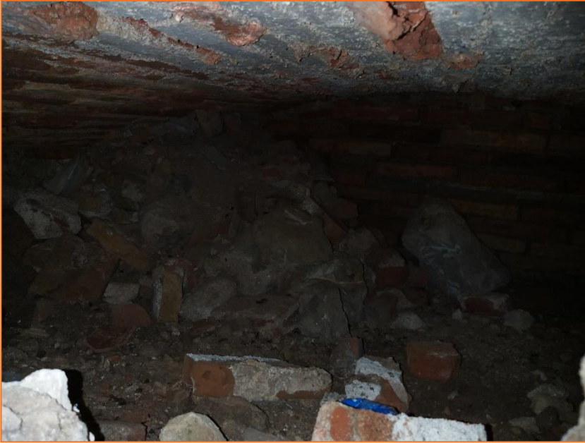
Foto 17. Interior del dipòsit UE16.
