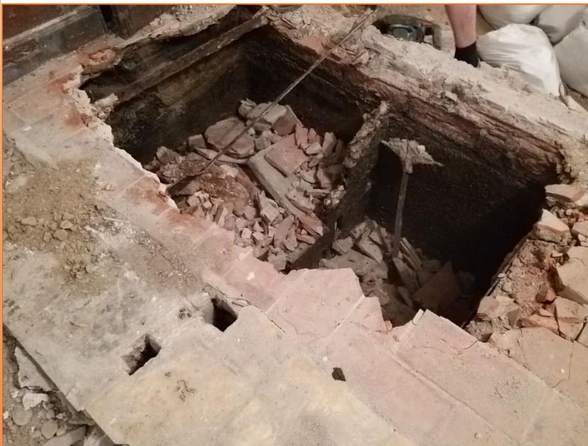
Foto 18. Vista de l'arqueta UE 41.
