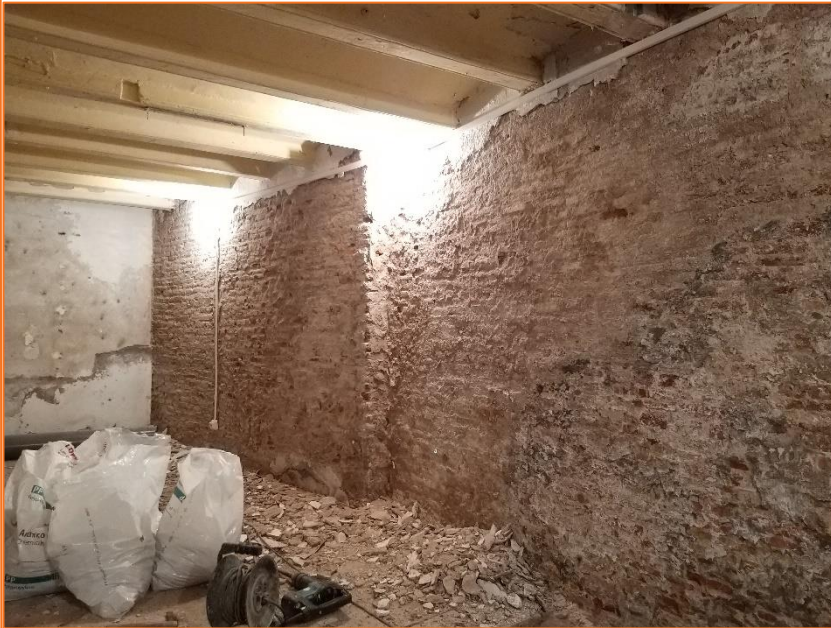
Foto 25. Vista del repicat de la paret nord, més propera al temple romà.
