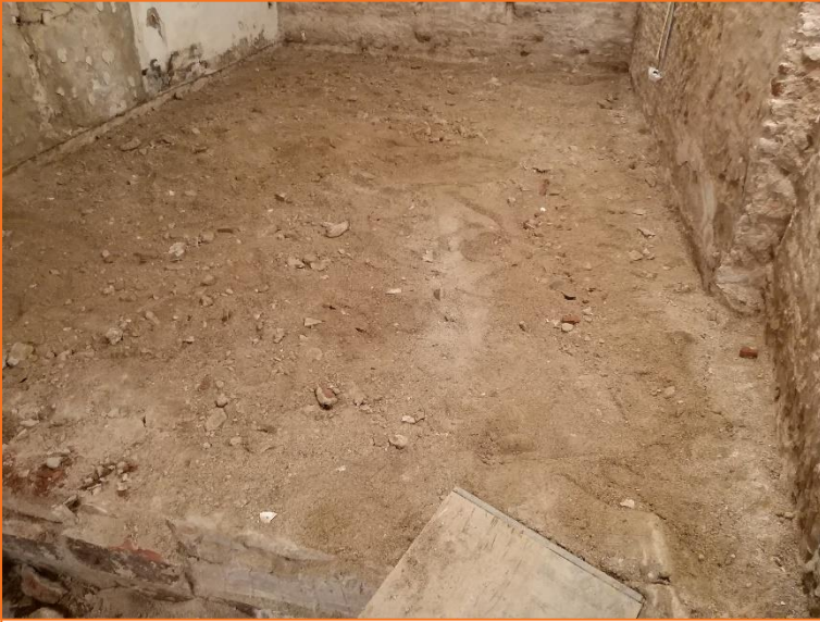
Foto 27. Zona NW del local, un cop retirat el paviment.
