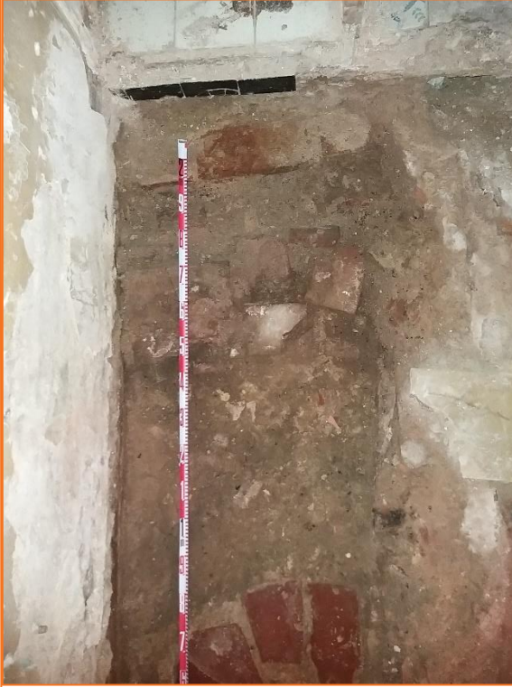
Foto 21. Claveguera UE 7, segon tram.
