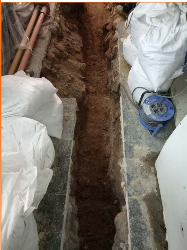
Foto 12. Foto final de la rasa.
