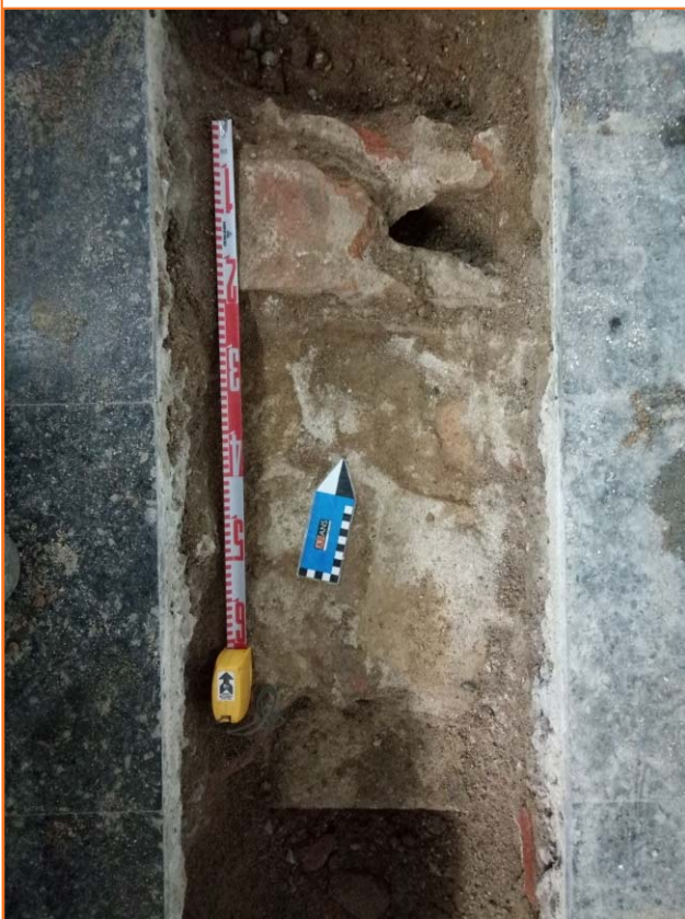
Foto 3. Claveguera UE 3 adossada a la riosta (UE 12) .
