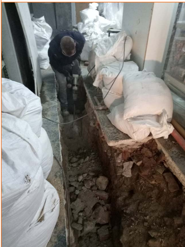
Foto 14. Procés de desmuntatge d'estructures.
