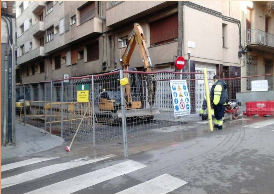
Foto 1. Vista general del xamfrà al punt d'inici de la intervenció. Fase I.
