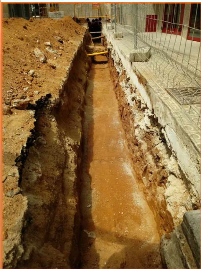
Foto 9. Vista general de la rasa . Fase II.
