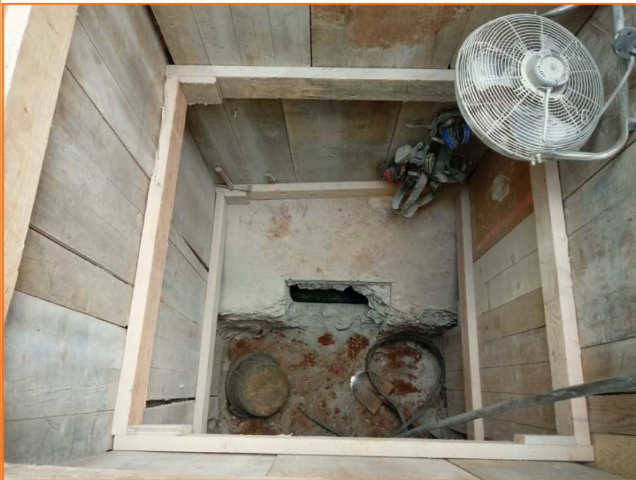
Foto 12. Connexió amb el col·lector d'aigües residuals. Fase II.
