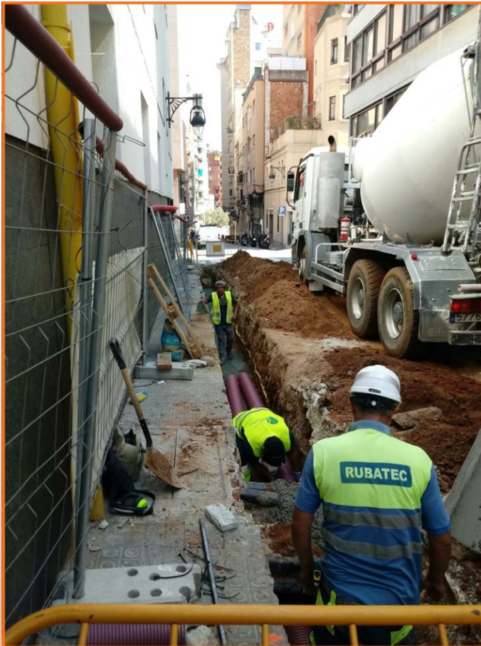
Foto 11. Instal·lació d'embornals. Fase II.
