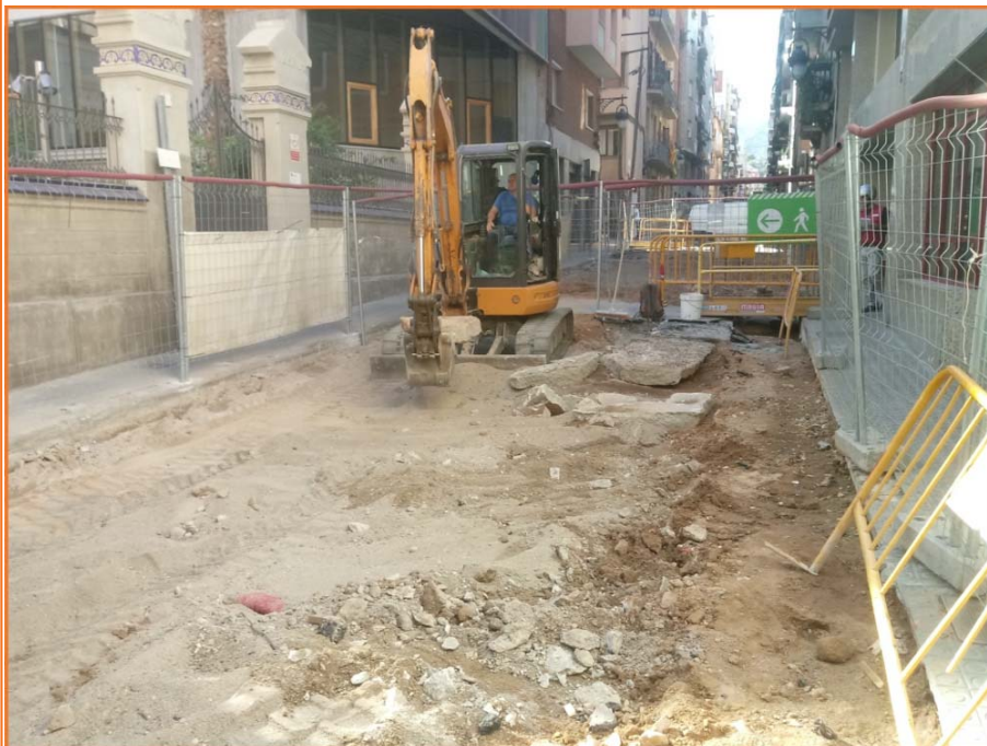
Foto 13. Seguiment dels treballs de rebaix del paviment del carrer. Fase II.
