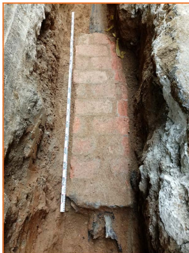
Foto 8. Localització de serveis durant el seguiment de la rasa . Fase II.
