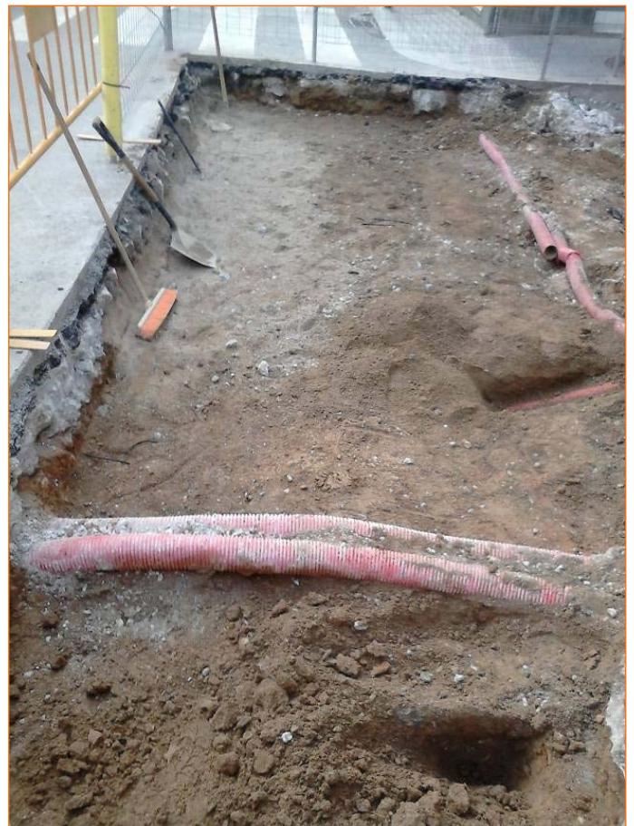
Foto 2. Rebaix de la caixa de paviments. Fase I.
