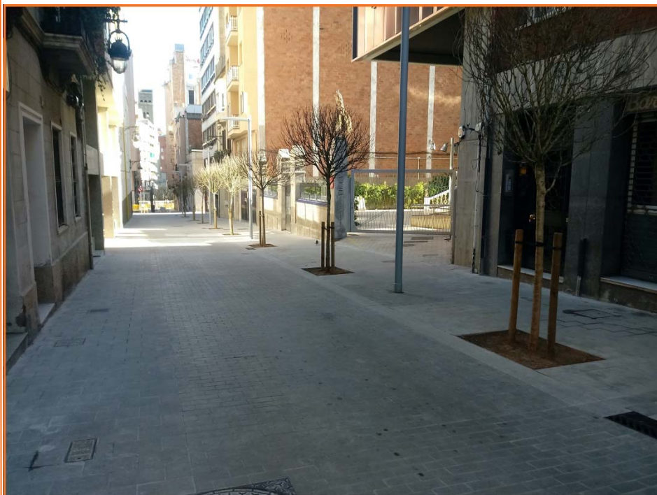
Foto 17. Resultat final de les obres. Fase II.
