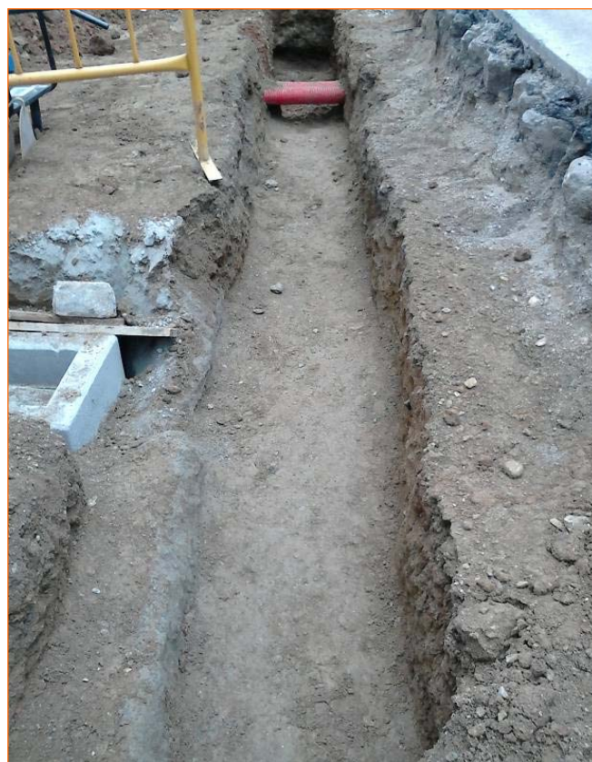
Foto 6. Rasa per als tubs de connexió de la xarxa de pluvials. Fase I.
