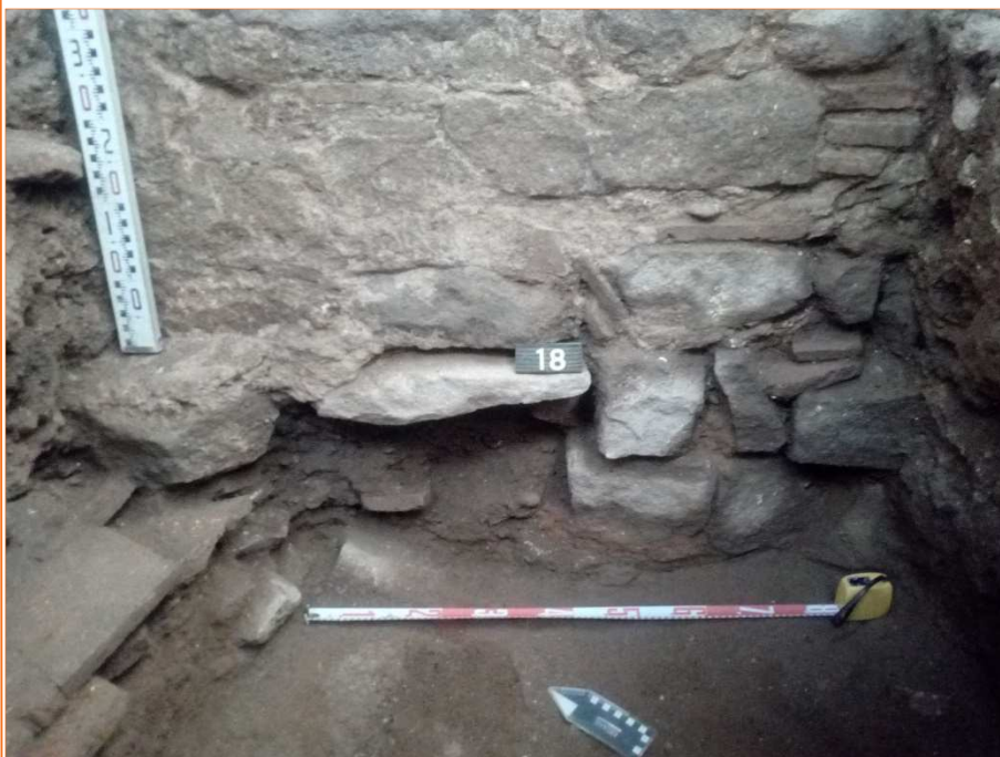
Foto 5. Detall del mur UE 18 (MR-2) amb la volta UE 22 trencada. Sondeig 1. Àmbit 1.
