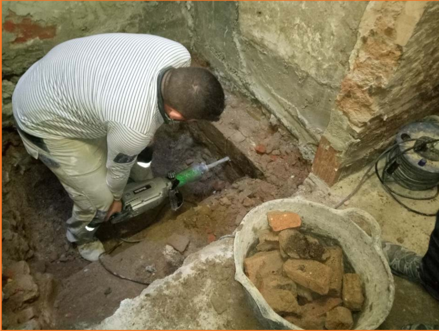
Foto 15. Treballs de desmuntatge d'estructures.
