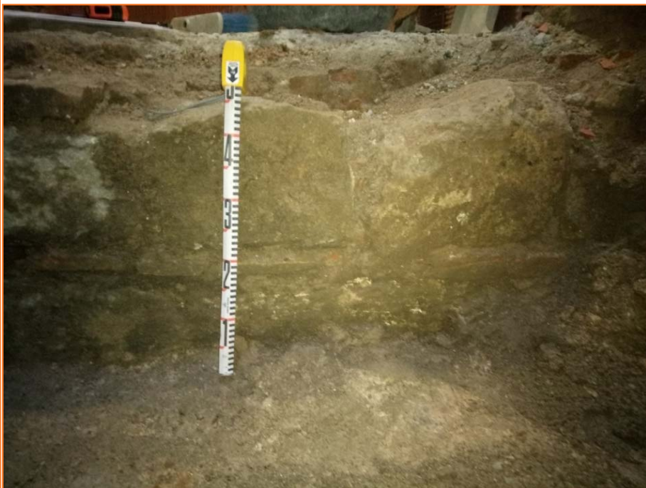
Foto 10. Fonamentació mur UE 16.
