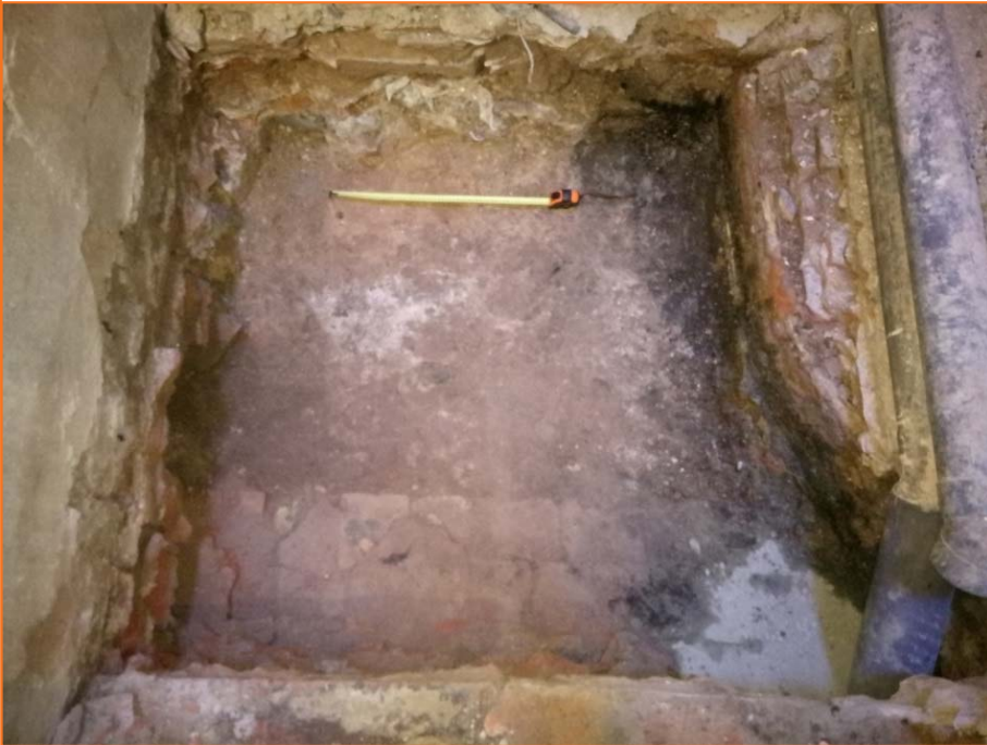
Foto 5. Paviment hidràulic (UE 7) i la seva preparació (UE 6).
