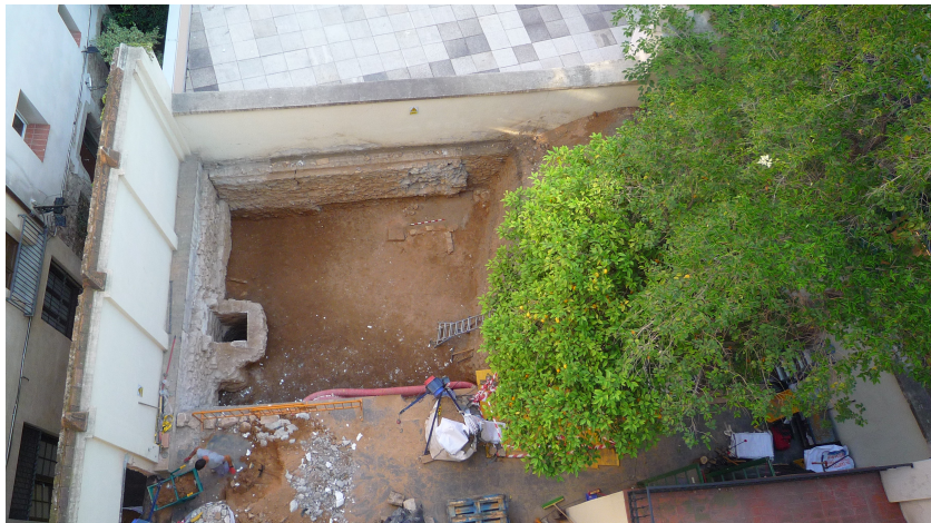
FOTO 5: Vista zenital de l'àrea d'excavació.
