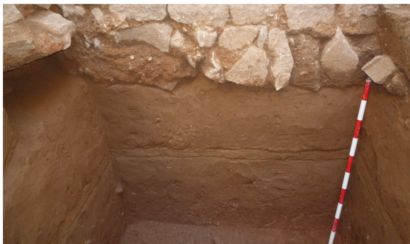
FOTO 27: Sondeig 1, detall de la sabata del mur UE 106
