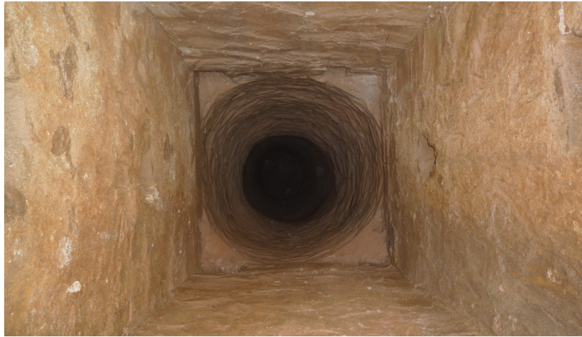
FOTO 4: Vista interior del pou. S'observa UE 104 i UE 105
