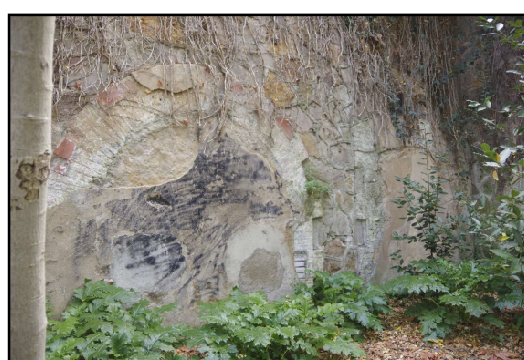
Obertures al mur
