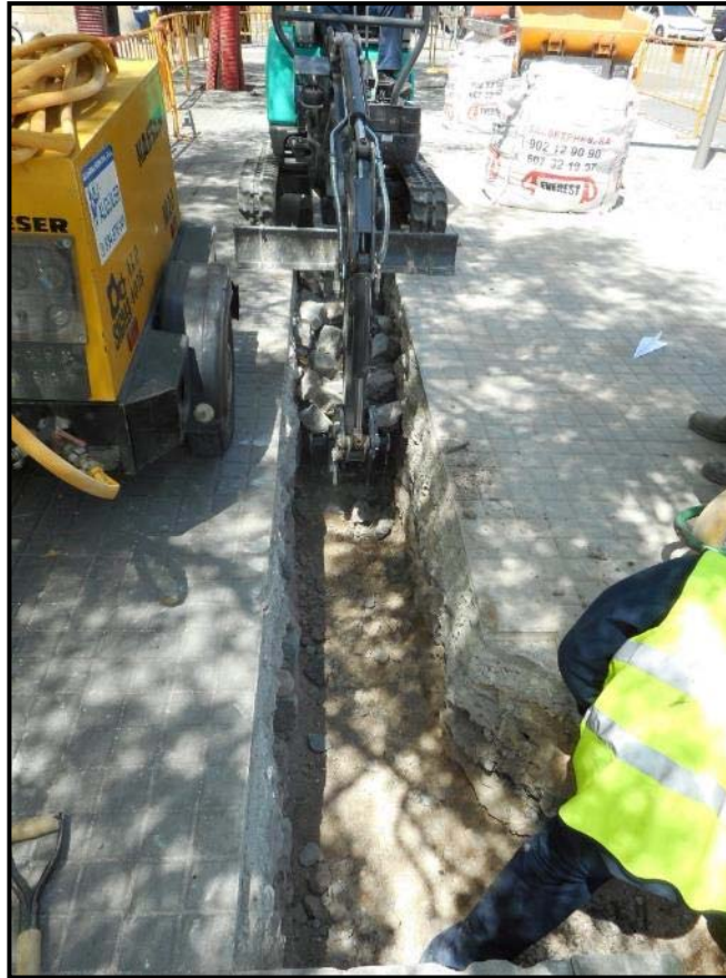
13. Buidat mecànic de la rasa en direcció Nord
