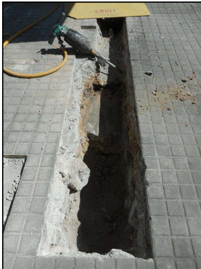
4. Inici de la rasa a la Plaça de Pau Vila.
