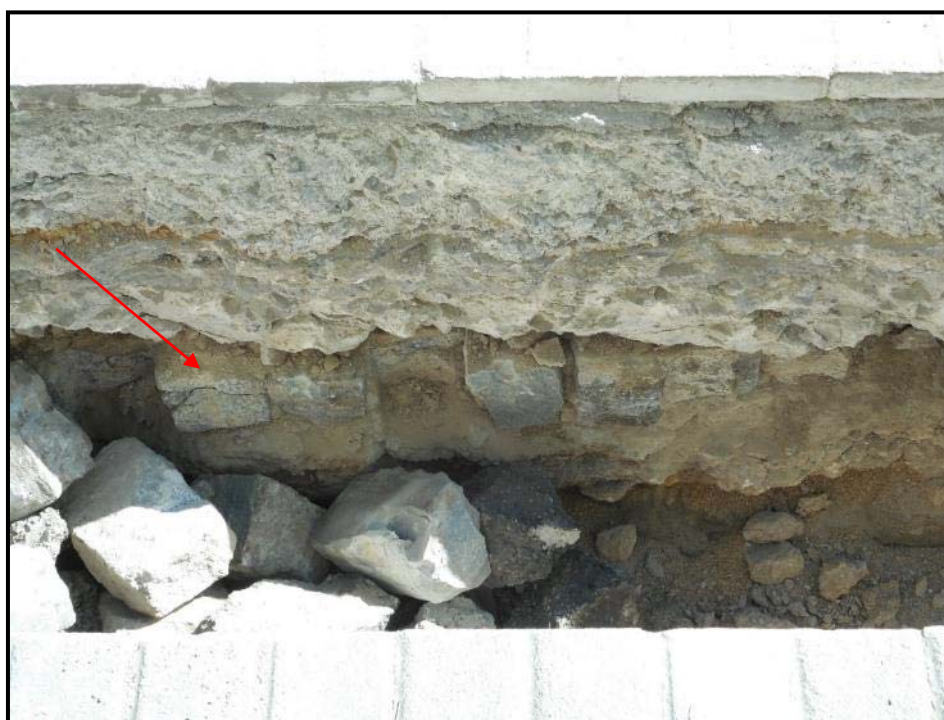
8. Secció del tram de rasa a la Plaça de Pau Vila. Assenyalat el paviment de llambordes UE005.
