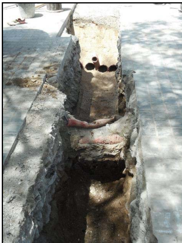
22. Finalització dels treballs de buidat de la rasa, instal·lació de tubs.
