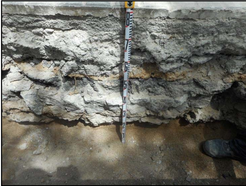
15. Secció del tram de rasa a la Plaça de Pau Vila.
