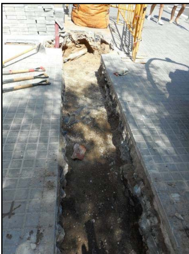
20. Buidat de la rasa en direcció Nord.
