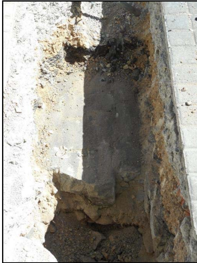
5. Paviment de llambordes UE005.
