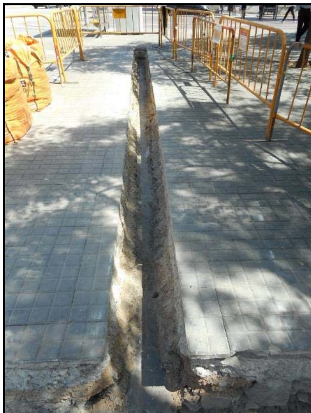
17. Tram de rasa en direcció sud finalitzat.
