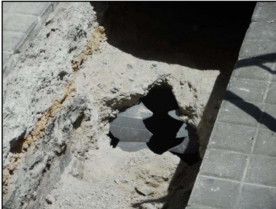
14. Servei anterior als treballs localitzat al tram de la Plaça de Pau Vila.
