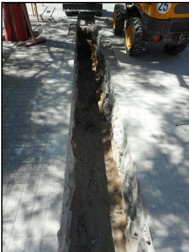
19. Buidat de la rasa en direcció Nord.
