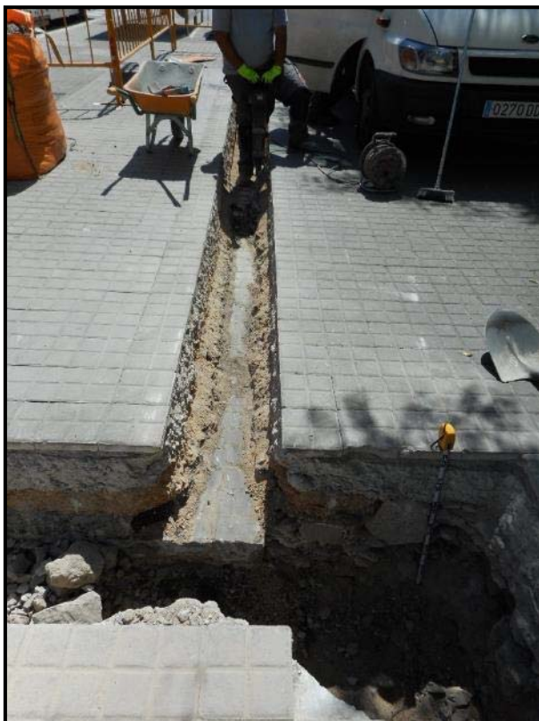
11. Tram de la rasa per al servei d'aigua en direcció Sud.
