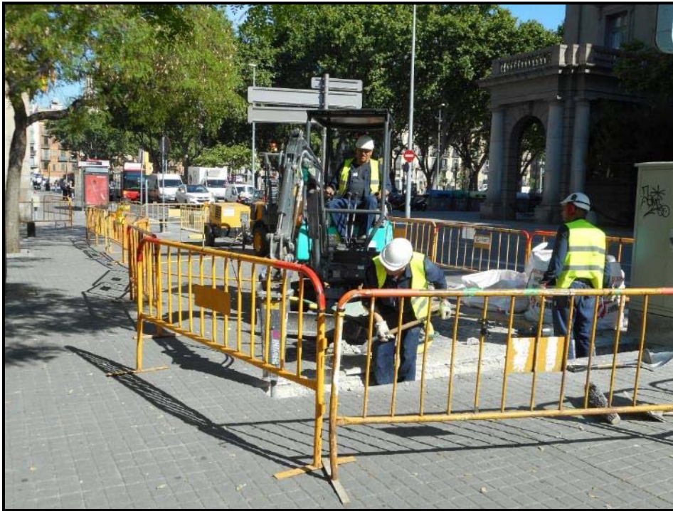
1. Inici dels treballs, cala 1 a la Plaça de Pau Vila.
