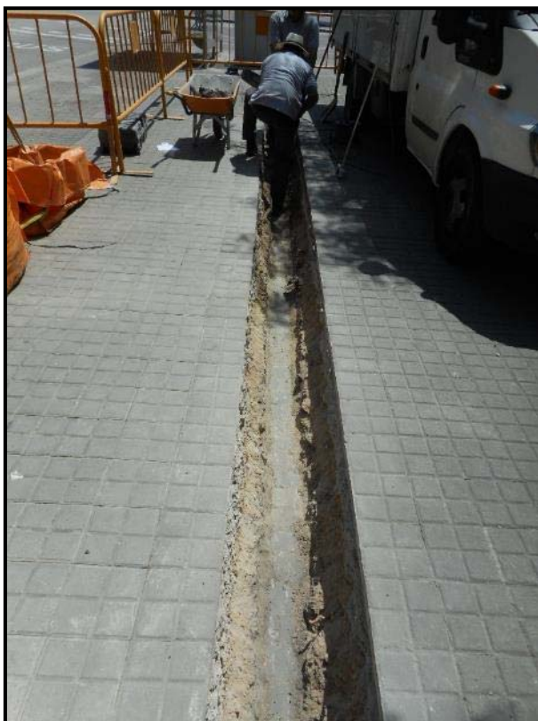
12. Tram de la rasa per al servei d'aigua en direcció Sud.
