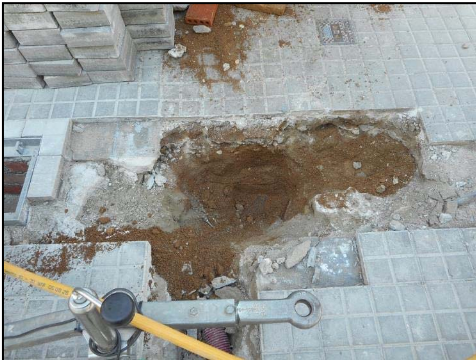
2. Cala 2 al carrer del Pas de Sota Muralla 2.
