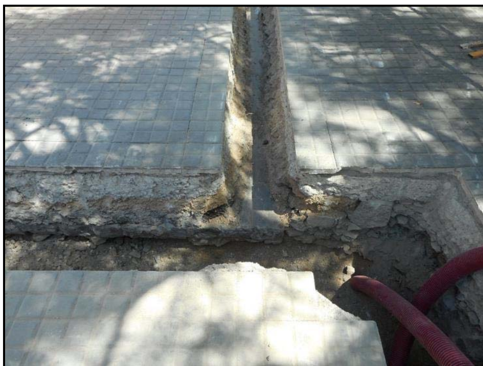
18. Connexió de la rasa Sud amb la nord.
