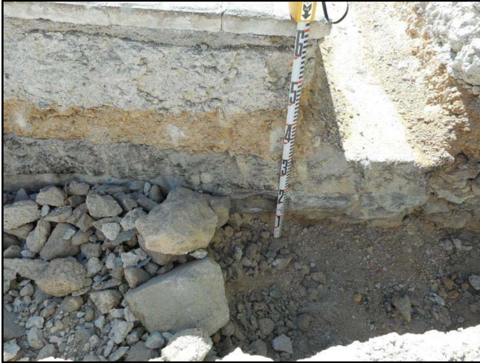
9. Secció del tram de rasa a la Plaça de Pau Vila.
