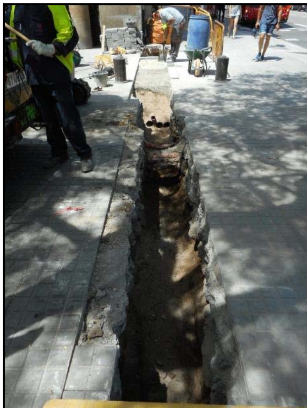
21. Finalització dels treballs de buidat de la rasa, instal·lació de tubs.
