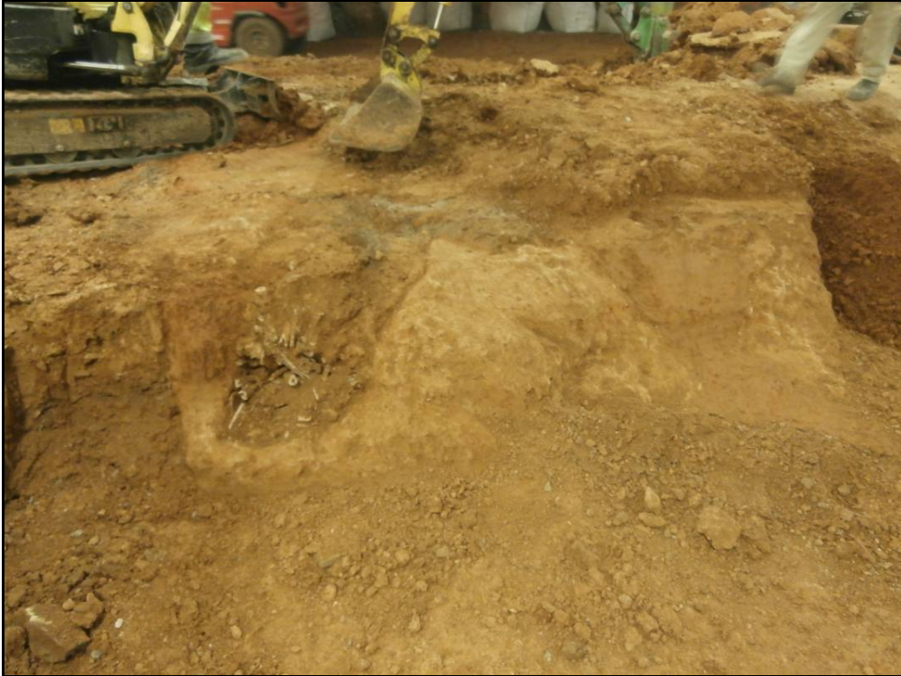
Fotografia 15: Troballa de la Fossa 2 durant el rebaix del terreny del soterrani.
