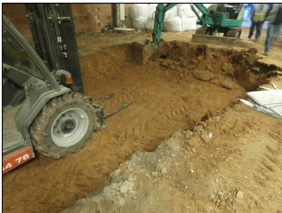
Fotografia 2: Rebaixos amb màquina del sòl del soterrani.
