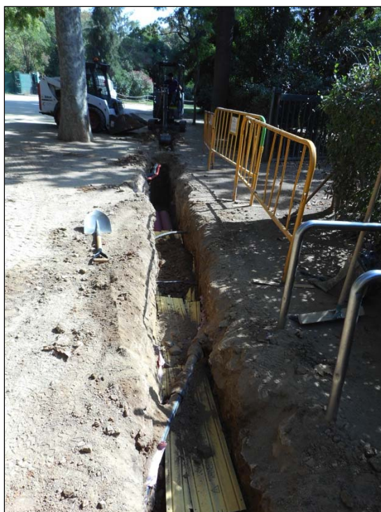
28. Localització de serveis d'aigua i llum al tram de la Gran Cascada.
