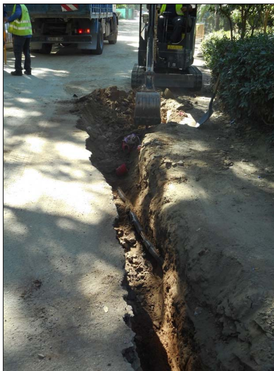
20. Buidat mecànic de la rasa al tram de la Gran Cascada.
