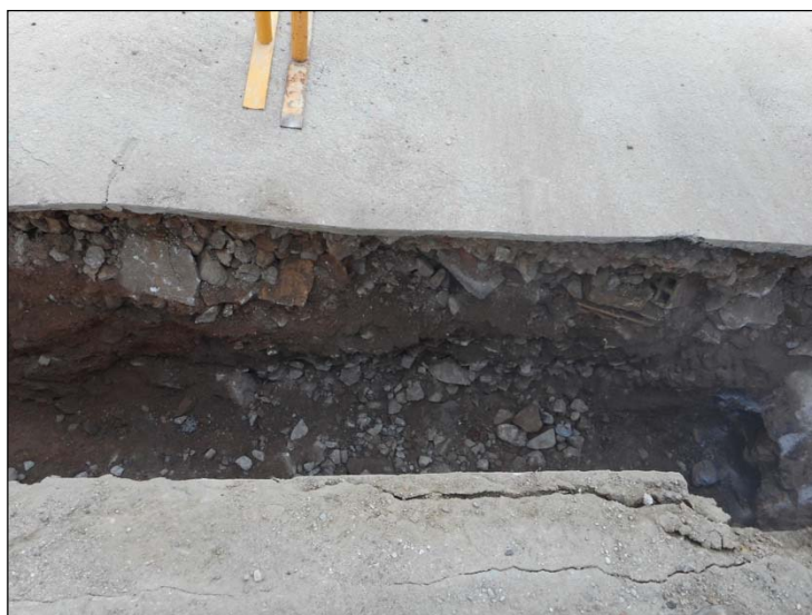
14. Detall del farciment de runa documentat al tram de la rasa del Passeig Joaquim Renart.
