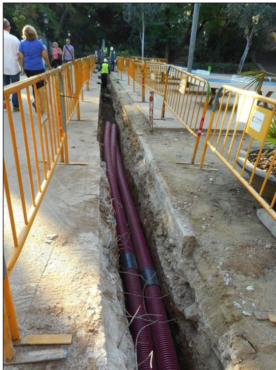
13. Instal·lació de tubulars al tram del Passeig Joaquim Renart.
