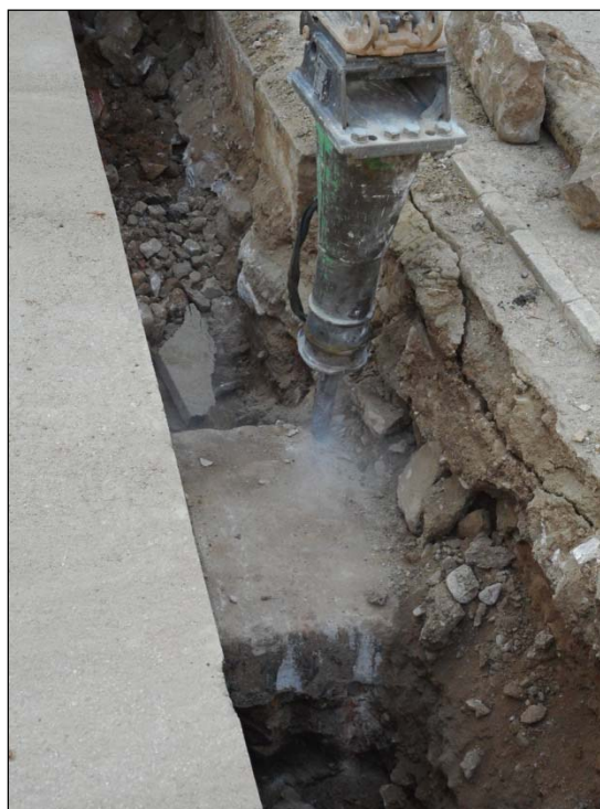
12. Desmuntatge de l'estructura de ciment.
