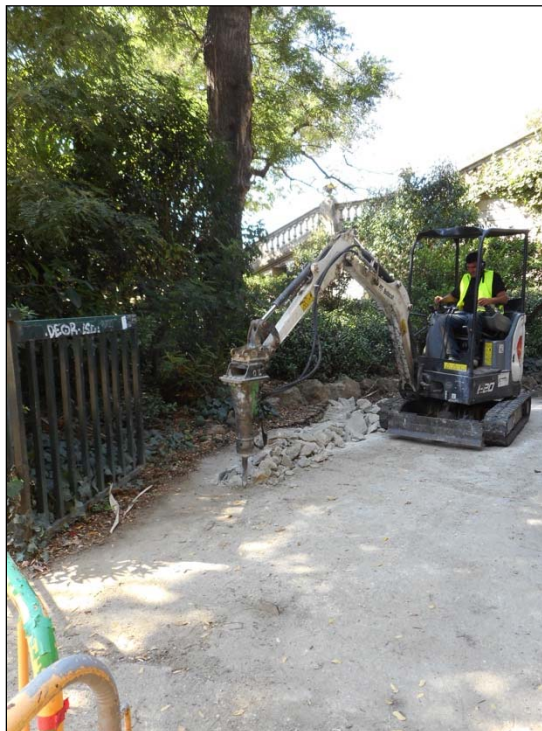
33. Obertura de la rasa a tocar de la Gran Cascada, enllaç amb estació transformadora.
