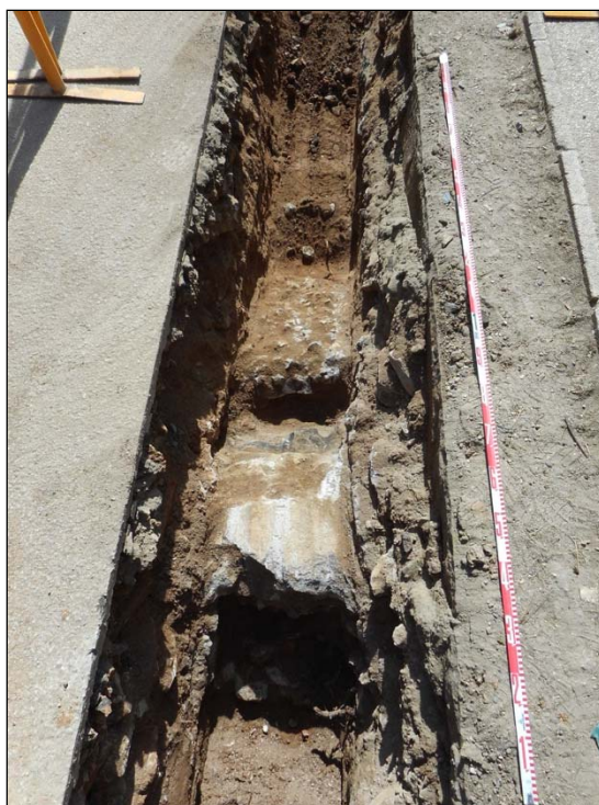
6. Localització d'una estructura de formigó.
