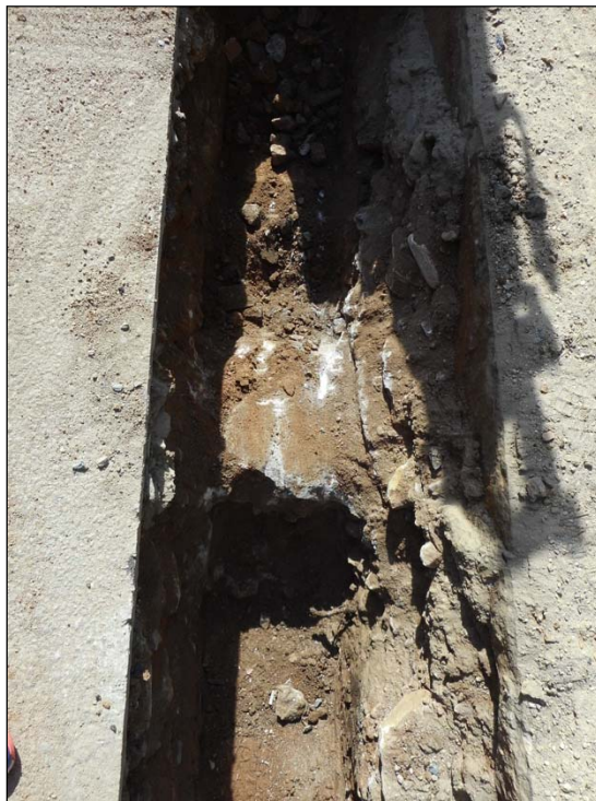
5. Localització d'una estructura de formigó.
