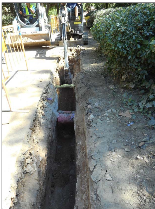
18. Buidat mecànic de la rasa al tram de la Gran Cascada.
