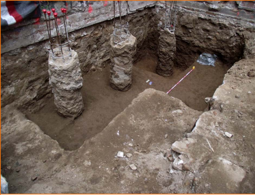
Foto 25. Fotografia final de la zona del fossat d'ascensor.
