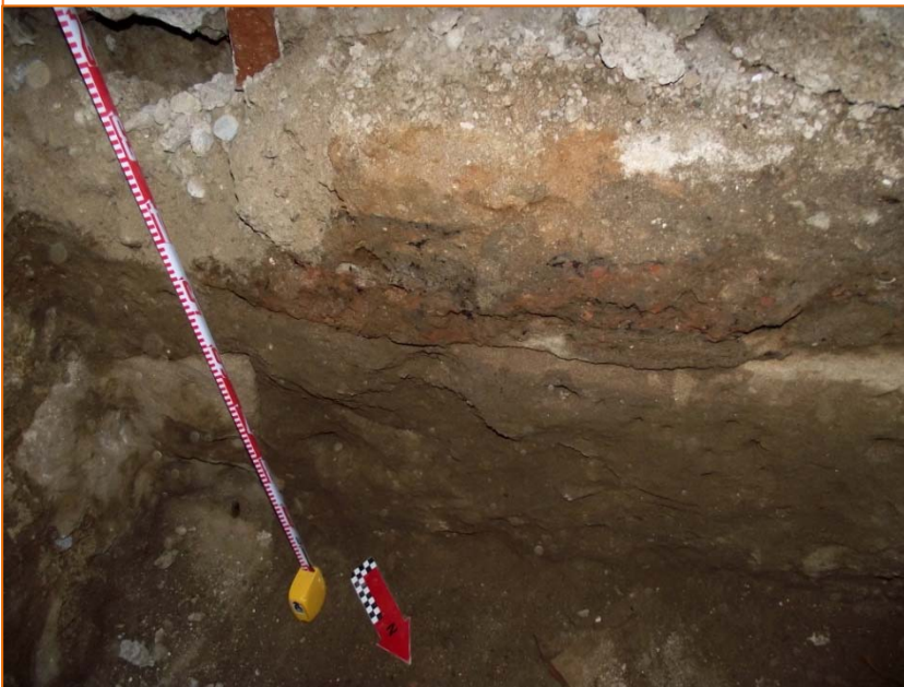
Foto 6. Vista de la cala d'obra amb l'estratigrafia documentada.
