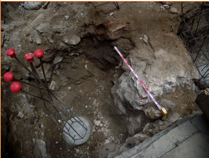
Foto 2. Mur riostra UE 027 i obertura del pilar 7.
