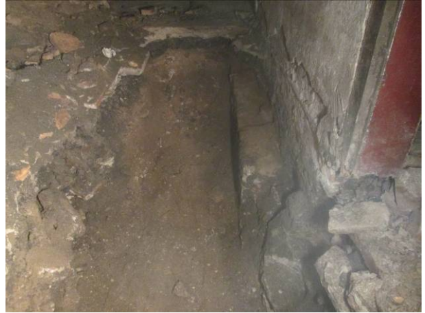
10. Detall del mur UE 203/303 a l'S3
