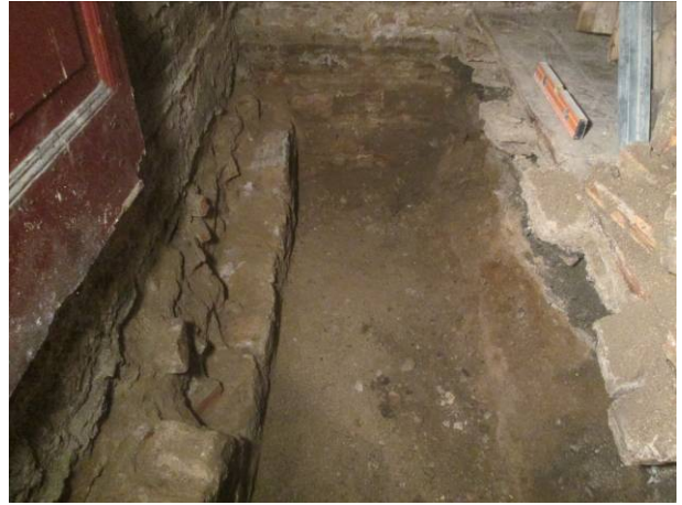
8. Detall del mur UE 203/303 a l'S3
