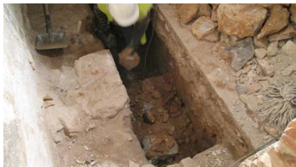
32. Desmuntatge del mur UE 504
