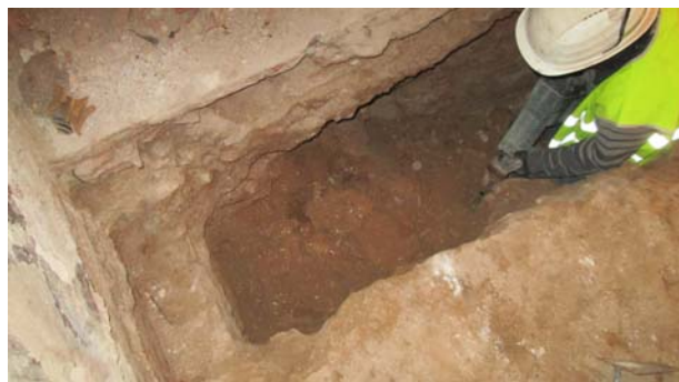
31. Desmuntatge del mur UE 517
