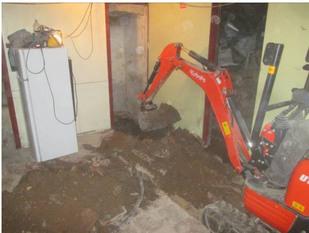
3. Inici de l'obertura del S2
