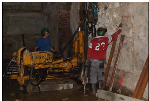
Realització dels diferents pilotatges al Cos A
