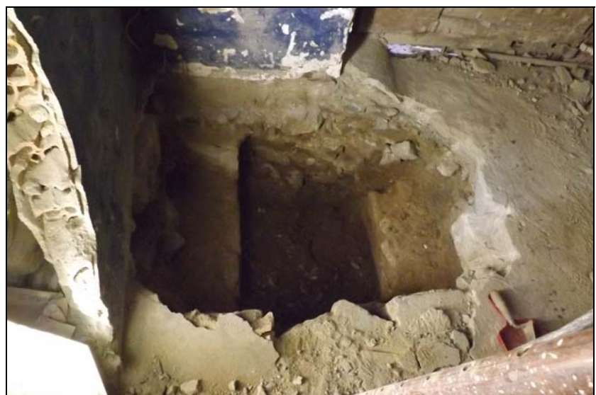
Dues vistes del procés d'excavació de la Cala 3. El mur UE 309 a l'esquerra i el graó UE 307 a la dreta
