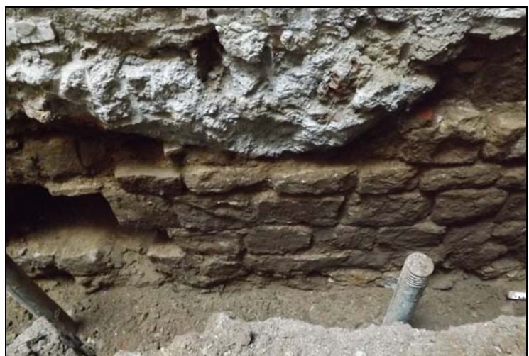
Vista general i de detall del mur mitger UE 9007 i la seva banqueteta UE 9008
