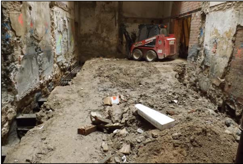
Vista general del Cos B amb les Traves 9 i 10 ja excavades i la Trava 11 al seu inici
