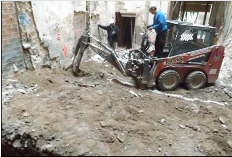
Vista general de Cos B a l'inici de la Trava 16
