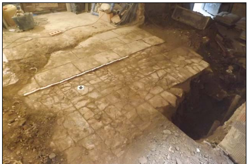
Dues imatges del paviment de lloses de pedra i de cairons (UE 12010 i UE 12011)
