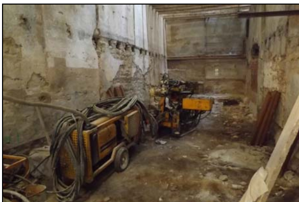
Realització dels diferents pilotatges al Cos A
