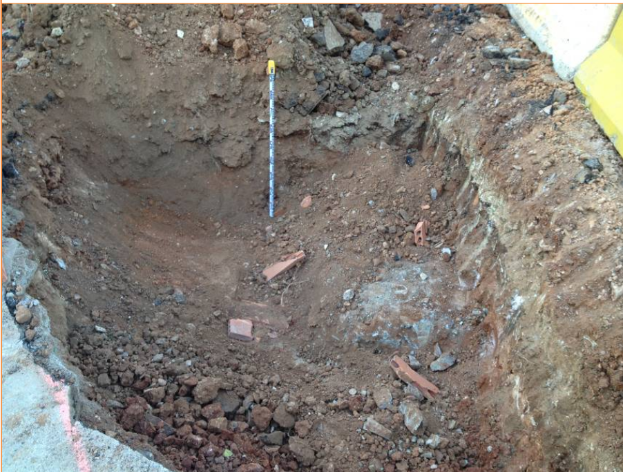
Foto 4. Arqueta de formigó i línia elèctrica a la part central.
