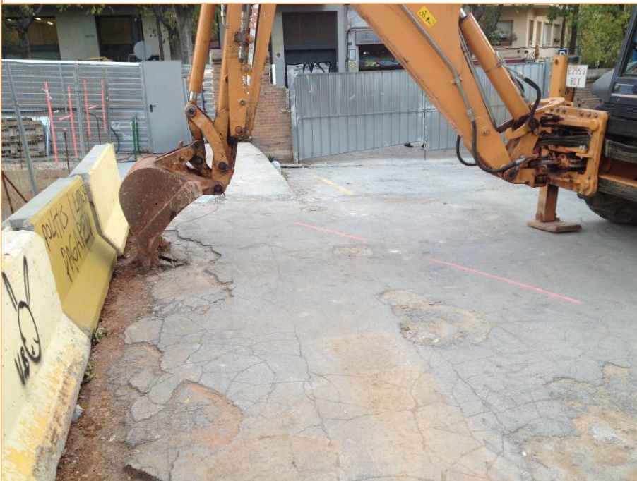
Foto 2. Inici dels treballs d'extracció de l'asfalt.
