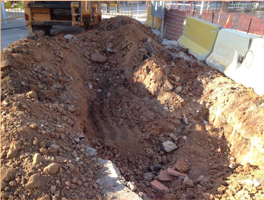
Foto 5. Treballs d'obertura de la rasa paral·lela a la línia elèctrica.
