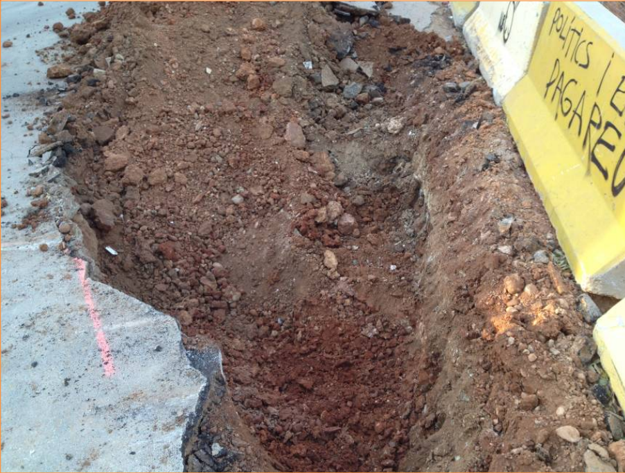
Foto 3. Treballs d'obertura de la banda est, nivell de rebliment.
