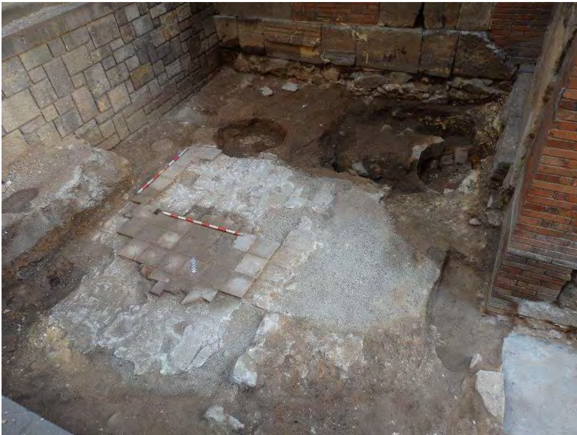
Estructures conservades del semisoterrani, molt malmeses. (Antequera. 2015).
