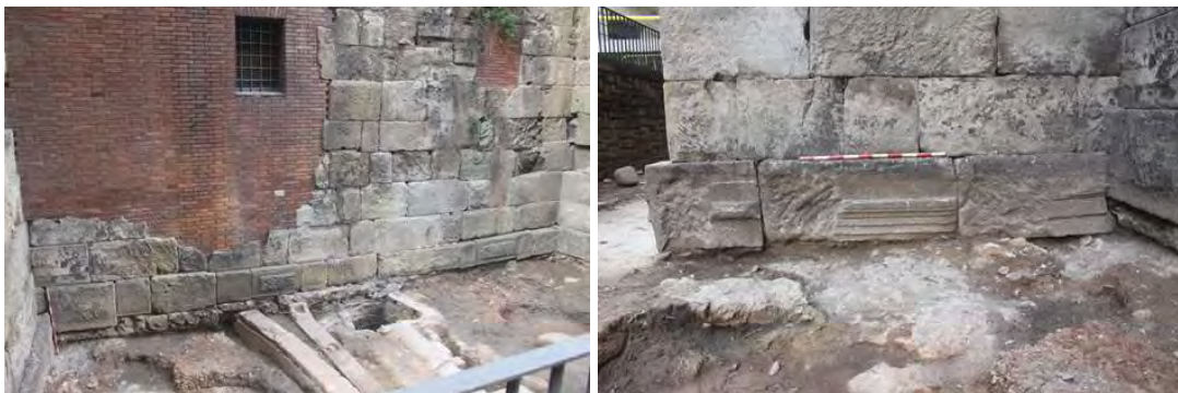
Sòcol i fonament entre la torre 16 i 17 (esquerra) i sòcol de la torre 17 realitzat amb elements motllurats
