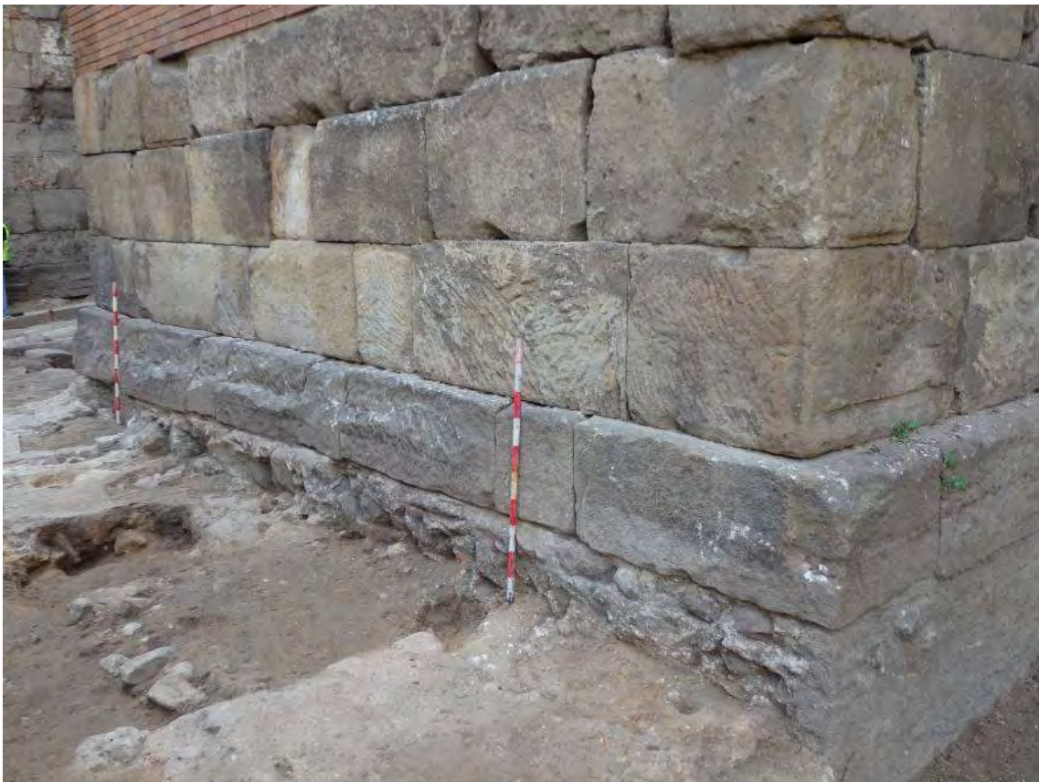
Vista de la fonamentació cara nord-est de la torre 16 (Artigues. 2016)
