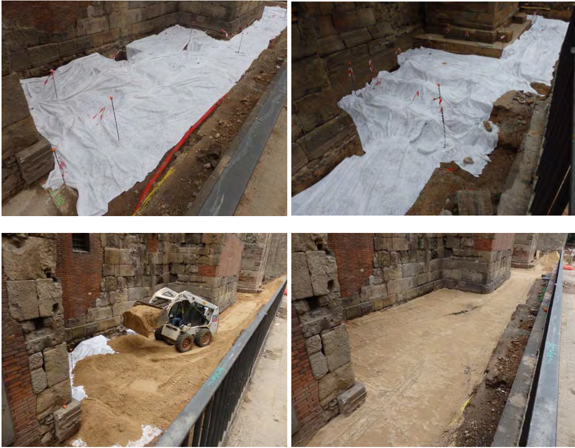
Procés de cobriment i anivellació de les restes (Antequera. 2016)
