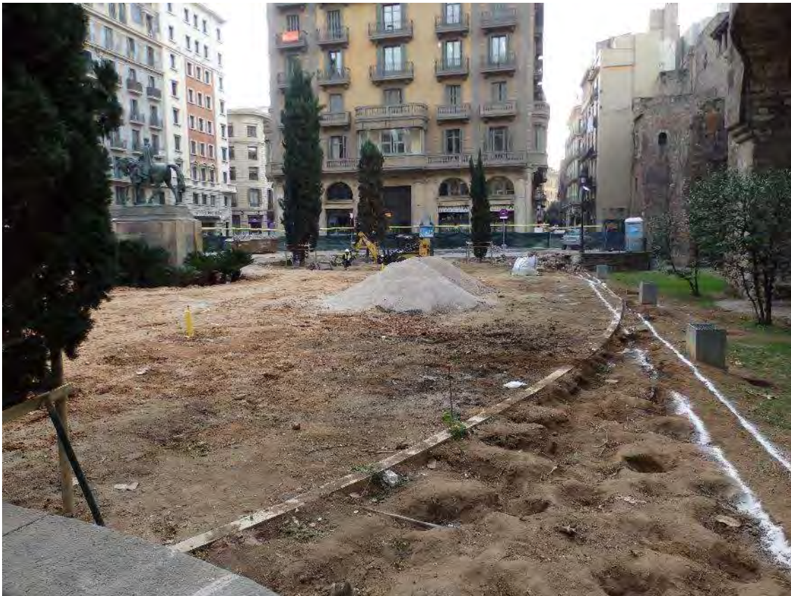
Vista general de la plaça sense el paviment, amb les plantes eliminades que no anaven a ser conservades i amb el replanteig d'alguns de les rases (Antequera. 2015)
