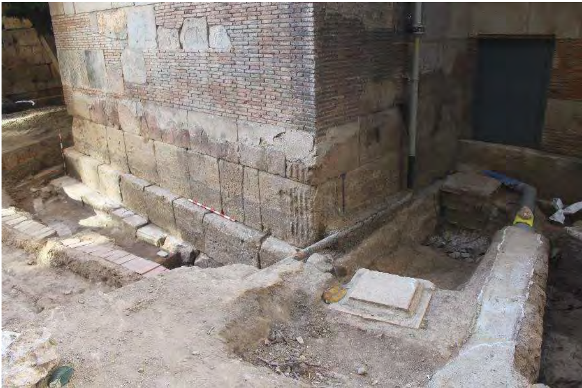
Vista de les cares nord i ponent de la torre 12, en el que es veu la base i fonamentacions conservades. (Artigues. 2016)
