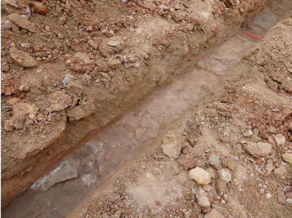
Vista general de la rasa 400, amb les estructures documentades. En el centre el paviment UE 405 (Antequera. 2015)
