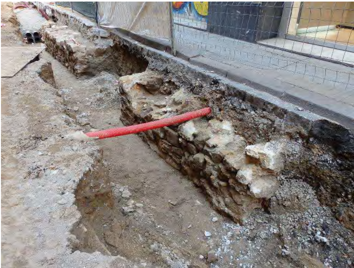
Vista general de la fonamentació de façana UE 907. (Antequera. 2016)
