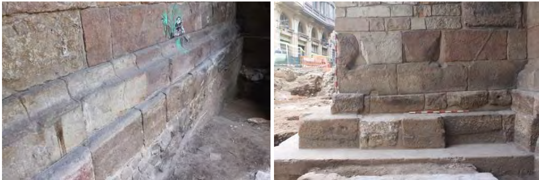
Tram del sòcol entre la torre 14 i 15 fonamentació reforçada de la torre 15. Cara Oest.
