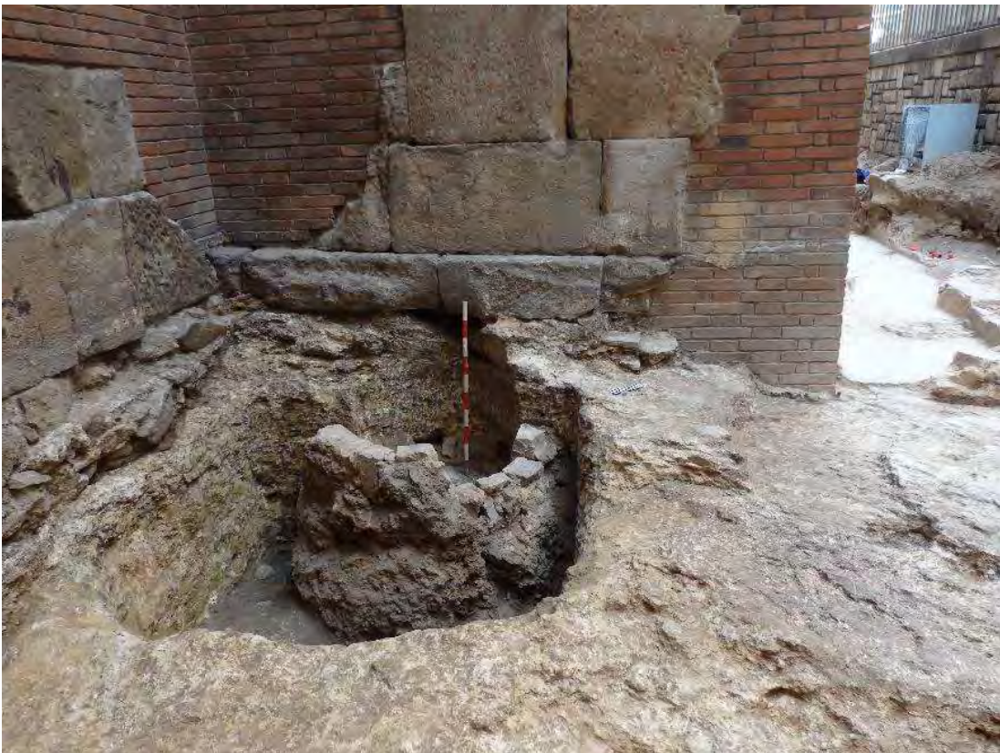
Vista del sòcol de la muralla on s'observa com descansa directament sobre la roca. (Artigues 2016)
