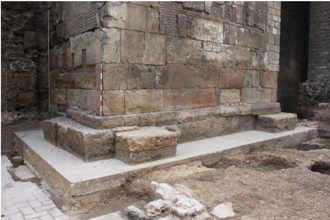
Recalçat i reforç de la fonamentació de la torre 15 (Artigues. 2016)
