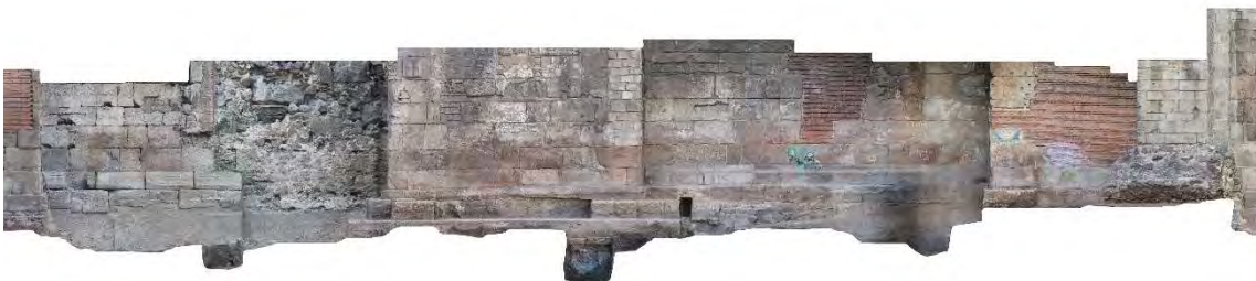
Tram del sòcol, fonamentació i llenç inferior de la muralla, entre la torre 14 i 16
