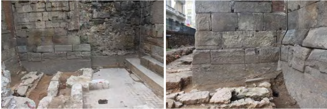
Tram entre la torre 15 i 16 i cara oest de la torre 16. La fonamentació es troba oculta sota el formigó
