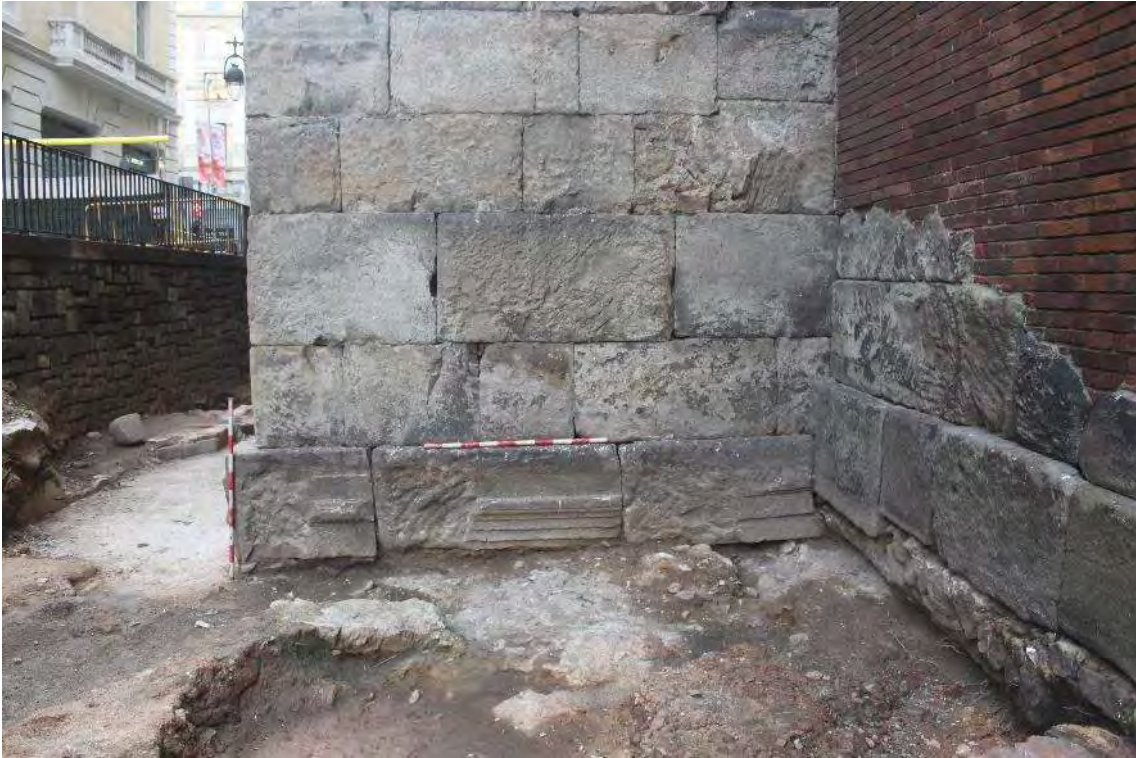
Sòcol de la torre 17 cara nord-oest, on són visibles les motlures aprofitades. (Artigues 2016)
