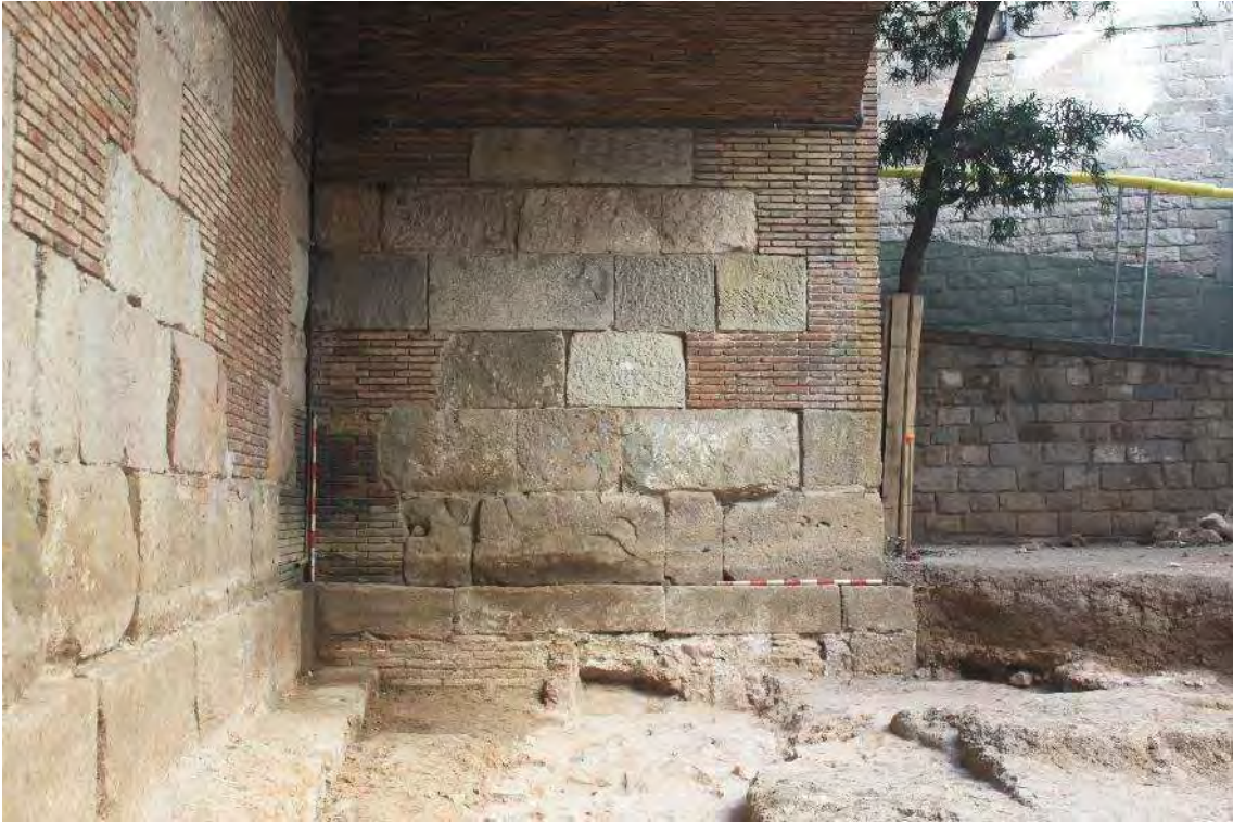
Alçat del parament est de la torre 8, una obra nova que descansa sobre estructures de les antigues edificacions del carrer Tapineria. (Artigues. 215)
