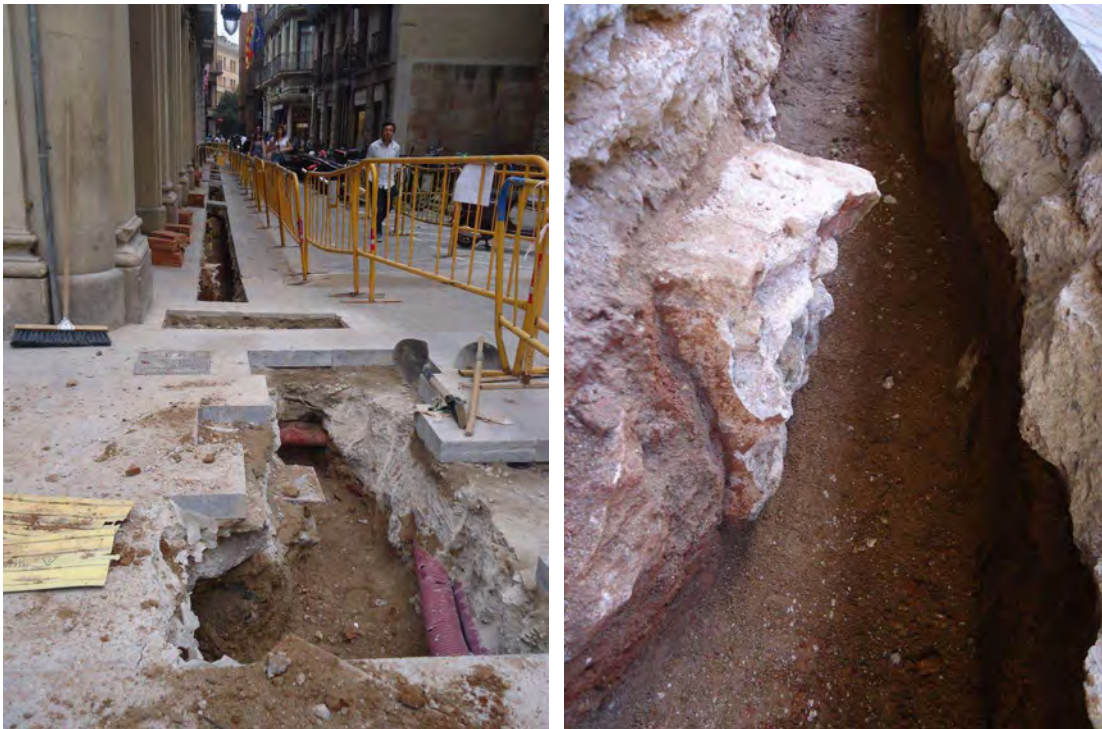
Vista general de la ras i de l'estructura UE 3104 (Antequera. 2015)
