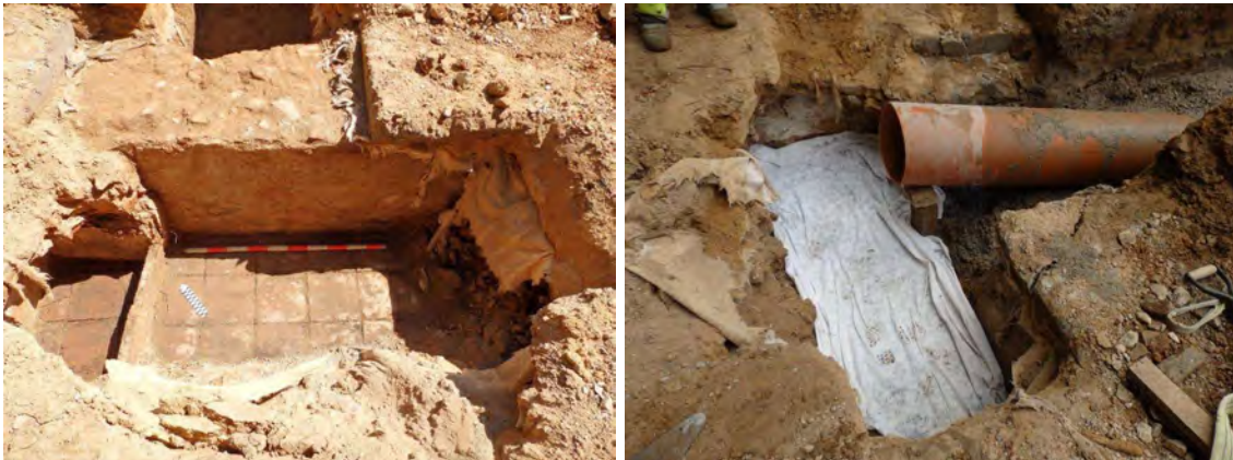
Mur UE 257 i del paviment UE 662, a el cobriment i ubicació de l'embornal. (Antequera. 2016)
