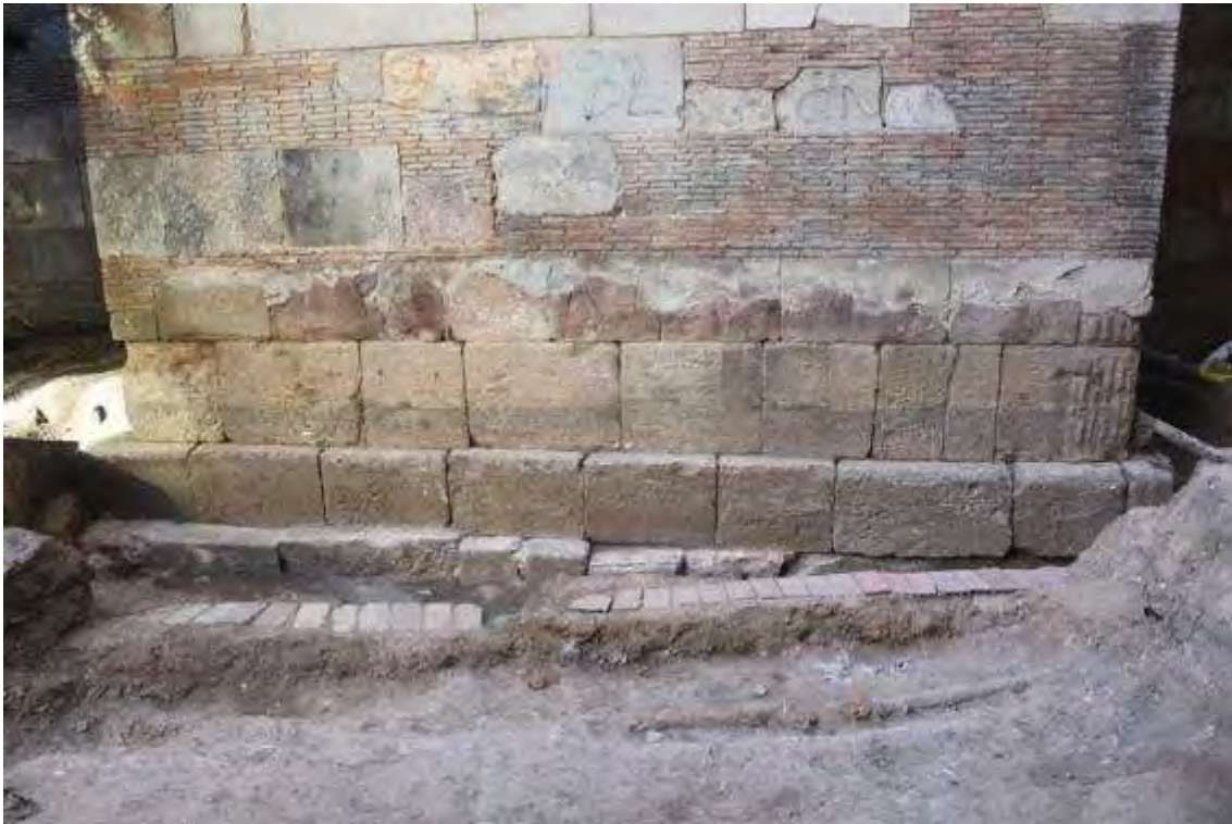
Vista de la cara nord de la torre 12 en el que s'aprecien els elements originals dels afegits. Es pot observar com la fonamentació segueix una alineació diferents. (Artigues 2016)
