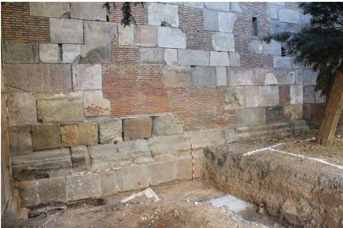
Vista general de la llenç de muralla entre la torre 12 i 13 amb el parament, banquetta i el sòcol motllurat de la muralla i la banquetta (Artigues. 2106).
