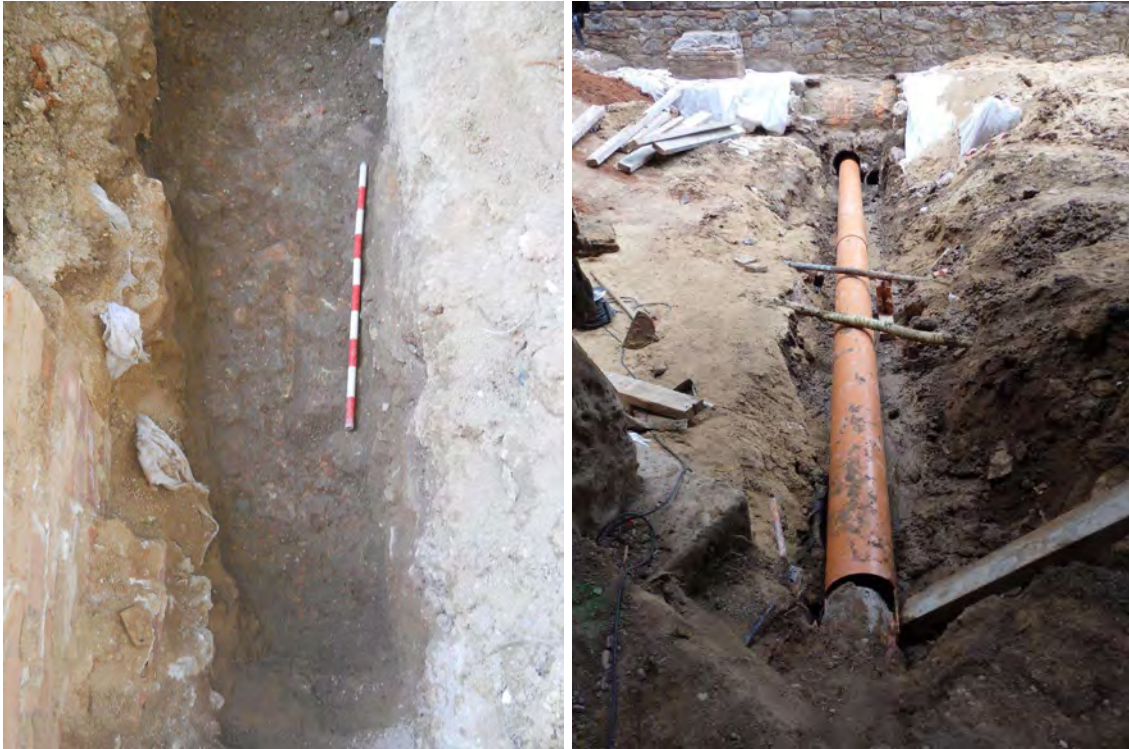
Vista puntual del paviment UE 712 i del nou servei (Antequera. 2016)
