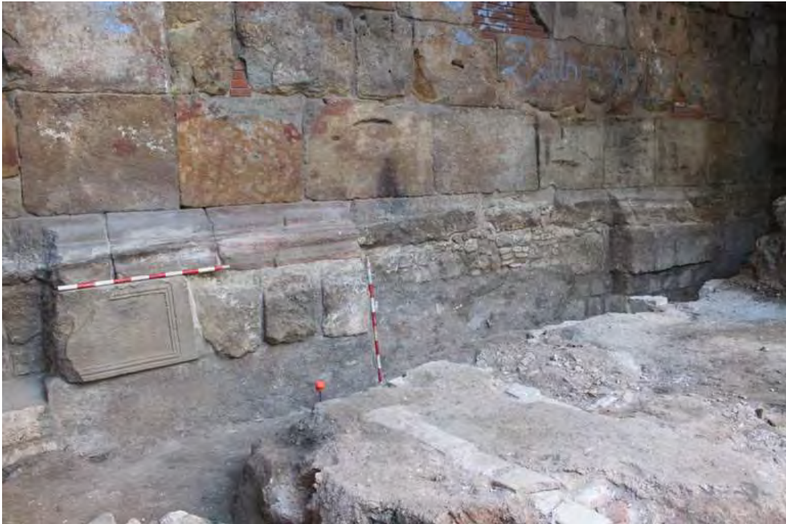
Llenç de muralla amb el sòcol i fonamentació afectat pels antics soterranis. Es veu amb claredat el recalçat amb formigó de la muralla. (Artigues. 2015)
