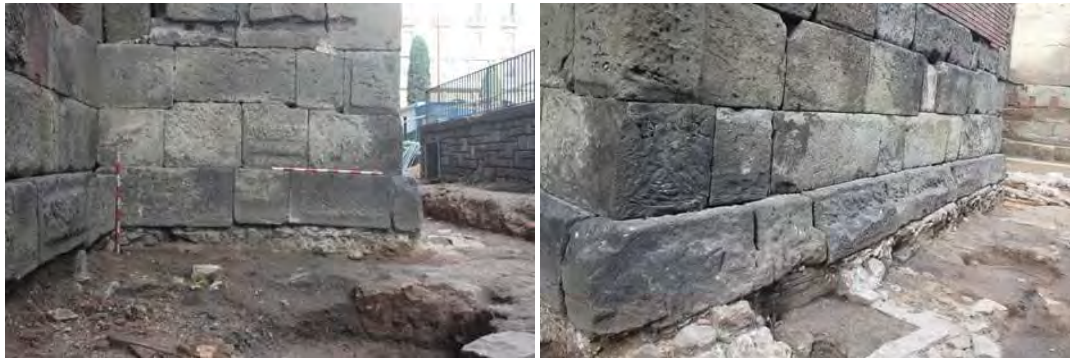
Cara est i nord de la torre 16. sòcol amb carreus aprofitats d'altres monuments
