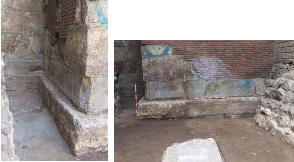
Sòcol de la banda de llevant de la torre 14 i de la cara nord
