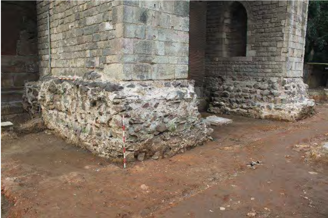
Vista general de les fonamentacions dels estrep de la capella (Artigues. 2016)
