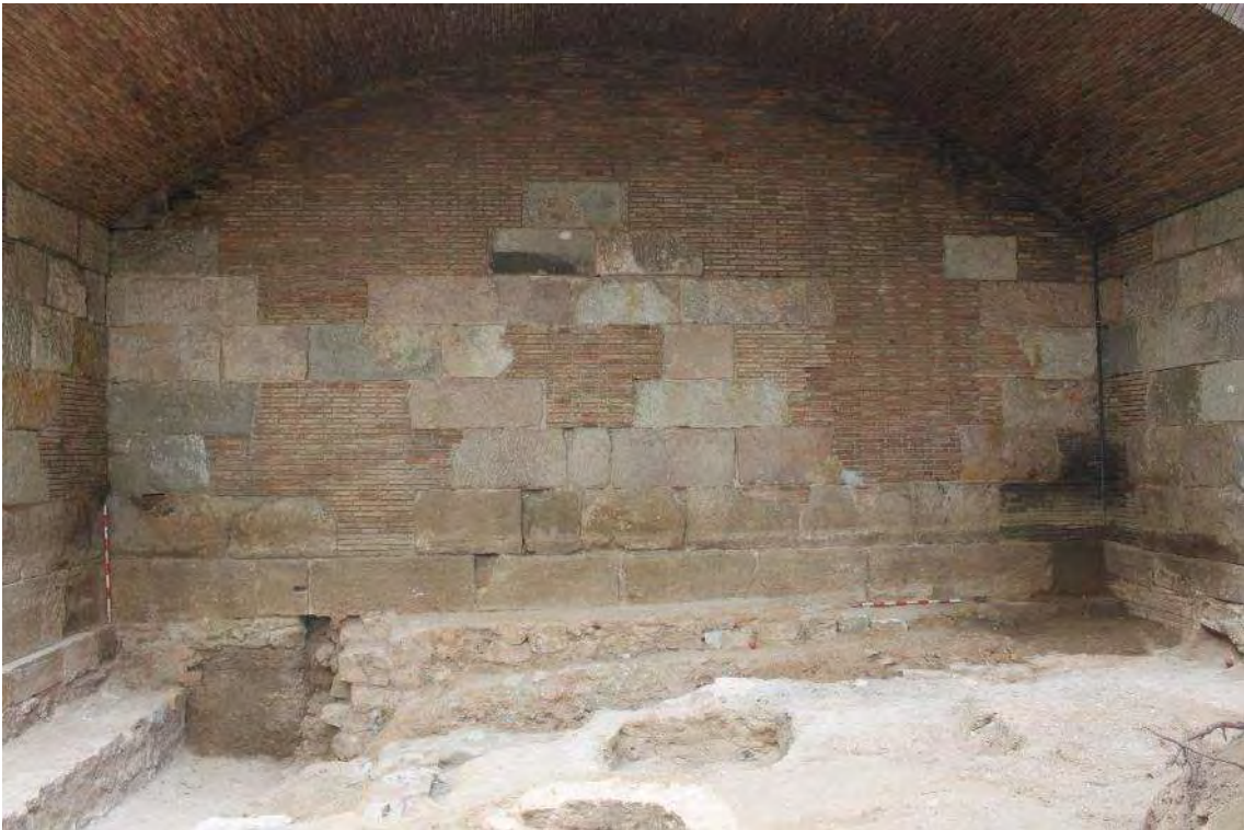
Alçat de la muralla entre torres, una obra de nova construcció. Es pot observar com la fonamentació està tallada pel recalçat de la torre 9. (Artigues. 2015)
