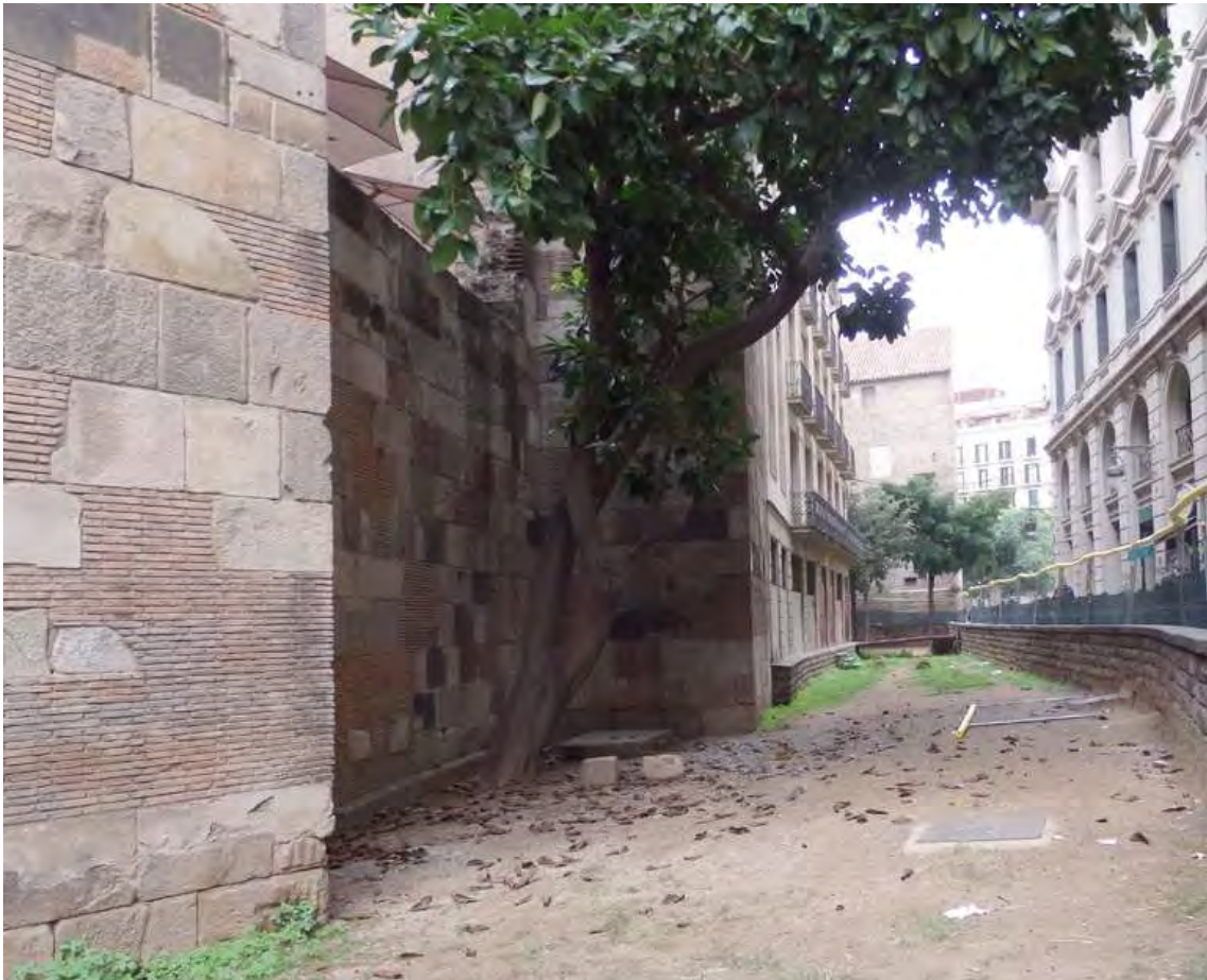
Vista de la zona amb el ficus, les arrels del qual ocupen tota la superfície. Al fons a l'esquerra a tocar de la torre 11, l'entrada a l'ETT. (Antequera. 2015)
