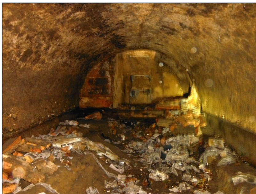
Fotografia 8. Vista de la volta des de l'interior del Rec Comtal.
