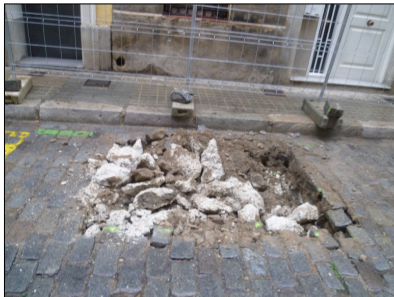
Fotografia 21. Obertura cales a la banda nord del col·lector.
