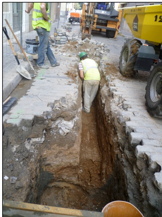
Fotografia 25. Obertura rasa que uneix dues de les cales.
