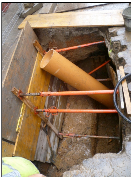
Fotografia 29. Treballs de construcció del nou embornal.
