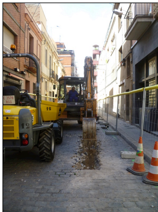
Fotografia 11. Obertura rasa a la banda nord del col·lector.
