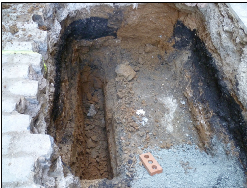
Fotografia 18. Vista de la cala oberta al sud del col·lector.
