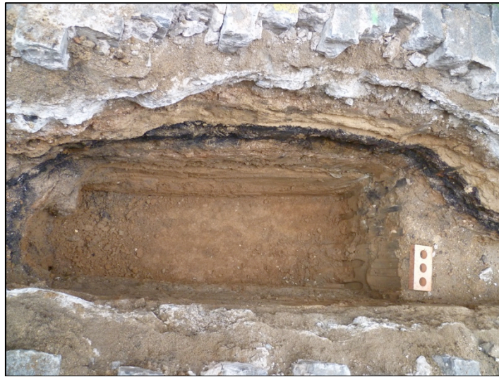
Fotografia 14. Vista de la cala oberta en la banda nord del col·lector per a la construcció del nou embornal.
