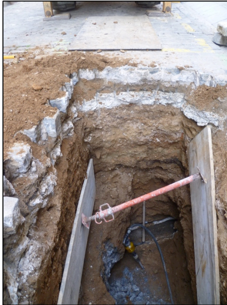
Fotografia 24. Vista interior cala amb apuntalament interior de les parets de la cala per tal de poder acabar de fer el rebaix necessari.
