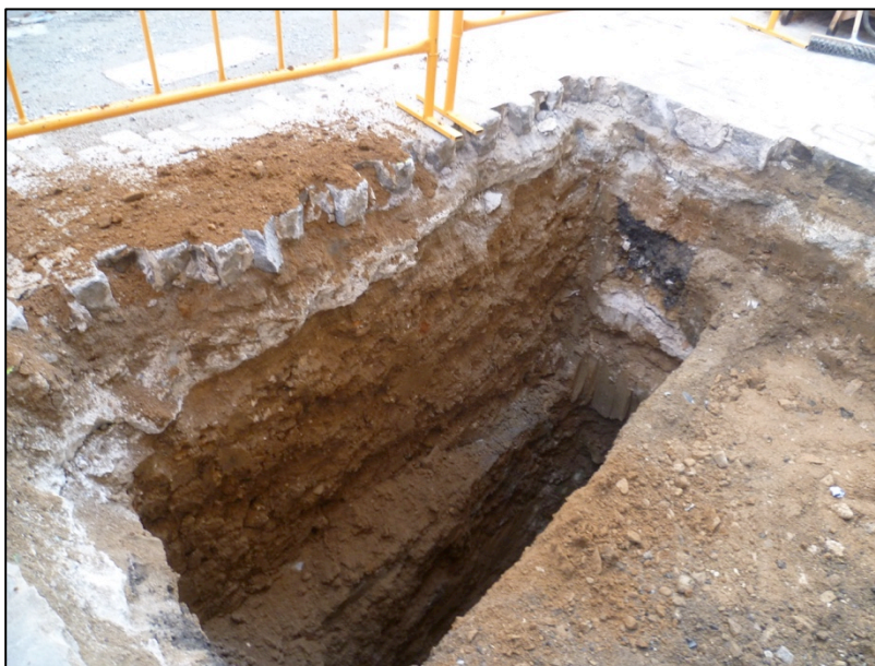
Fotografia 28. Vista interior d'una de les cales per a la construcció d'un embornal.
