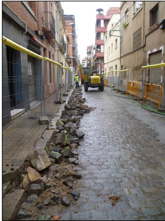
Fotografia 16. Aixecament del paviment UE200 en el decurs de l'obertura de la rasa oberta la banda sud del col·lector.
