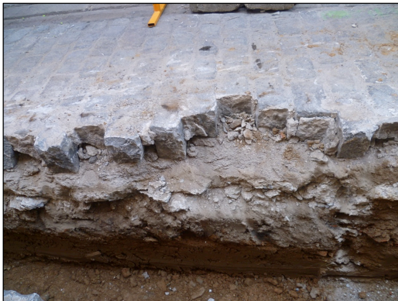
Fotografia 13. Detall seqüència estratigràfica documentada a la rasa en qüestió. Amb UE200 i UE201.
