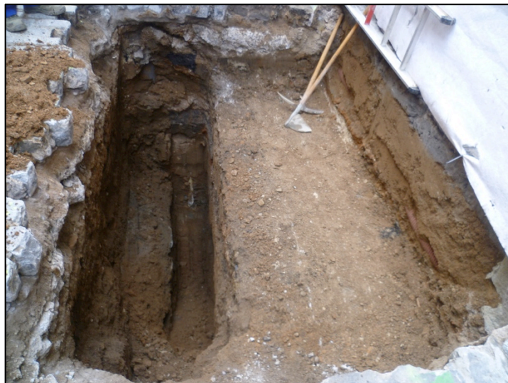
Fotografia 26. Vista d'una de les cales obertes a la banda sud del col·lector amb presència del prisma de formigó.
