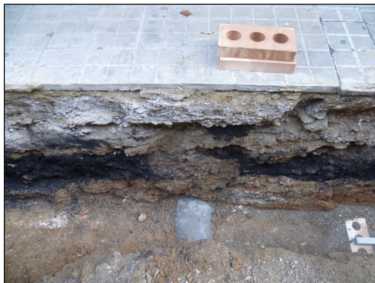
Fotografia 17. Detall secció estratigràfica rasa. UE 200 i UE201 amb presència de serveis.
