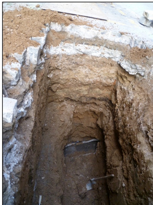
Fotografia 23. Vista interior d'una de les cales amb presència del col·lector UE306 i un clavegueró de les finques del carrer afectat.
