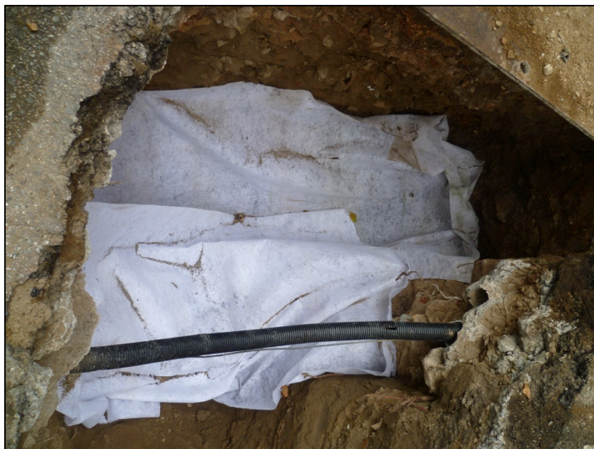
Fotografia 9. Cobriment i protecció estructures documentades en la cala.
