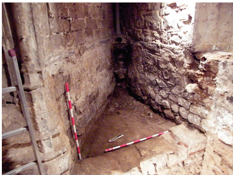
Fig.12 Vista final un cop desmuntat el mur UE 700 i buidat en part el rebliment UE 705
