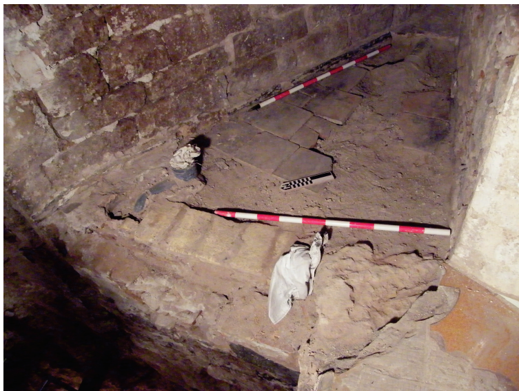
Fig.11 Espai a rebaixar (UE705) i alhora desmuntar el mur UE 700.
