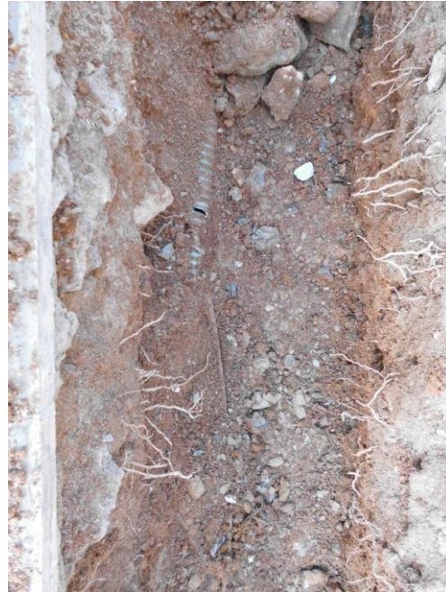
4) Fotografia de la cota final de rebaix. Detall del servei localitzat. Autora: Maria Pujals - ARKPADOC SC
