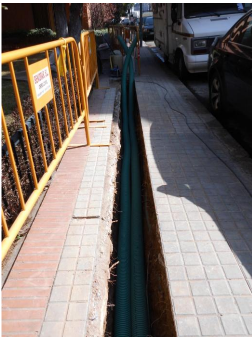
5) Rasa finalitzada amb els tubs de PVC ja col·locats. Autora: Maria Pujals - ARKPADOC SC
