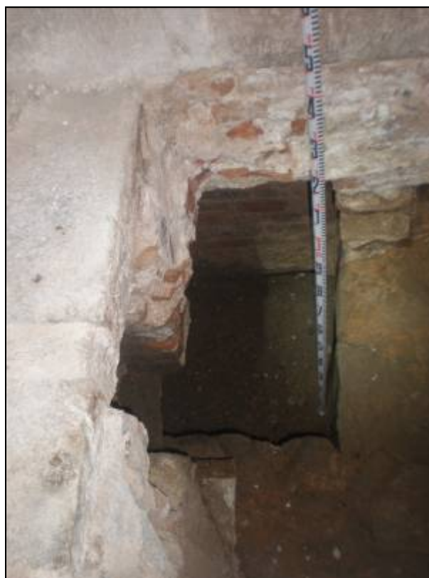
Vista parcial del dipòsit UE 10003. Al fons, arc de descàrrega UE 10008.
