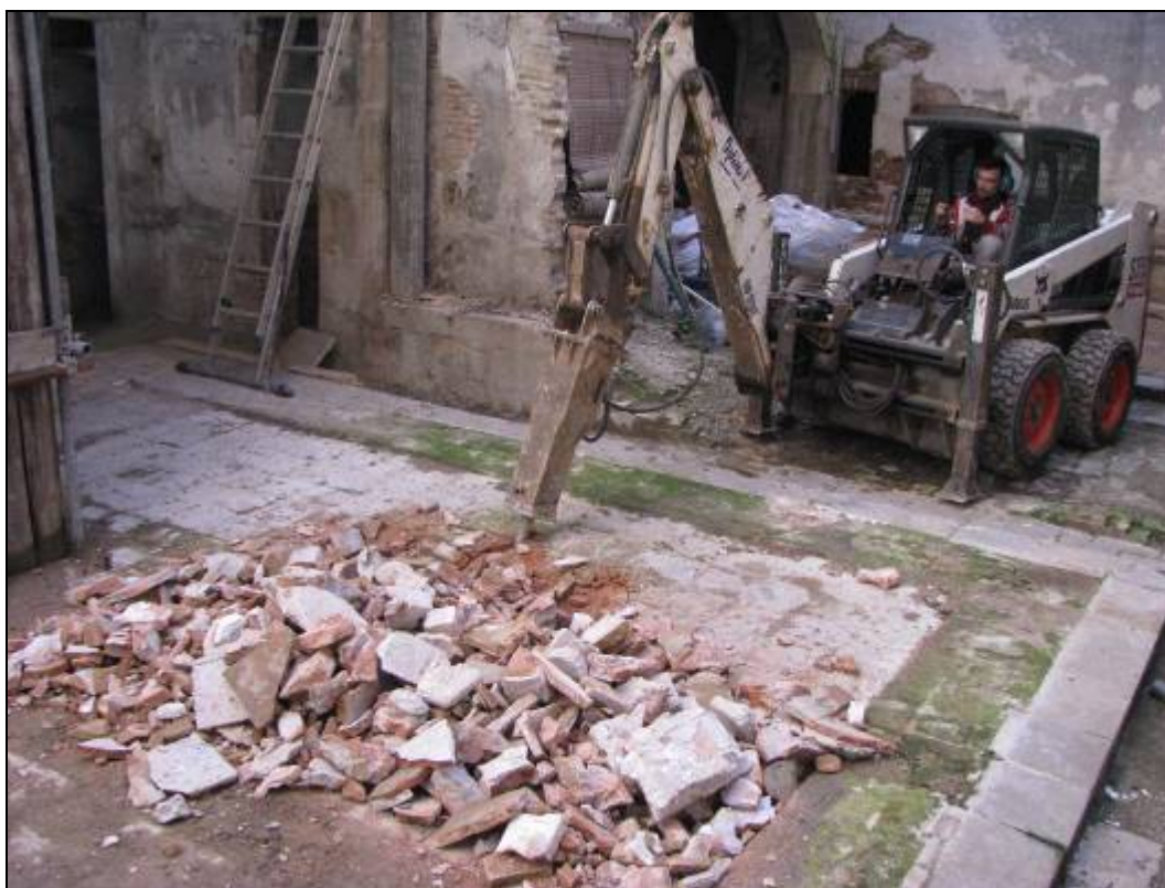
Obertura de la cala amb Bobcat.
