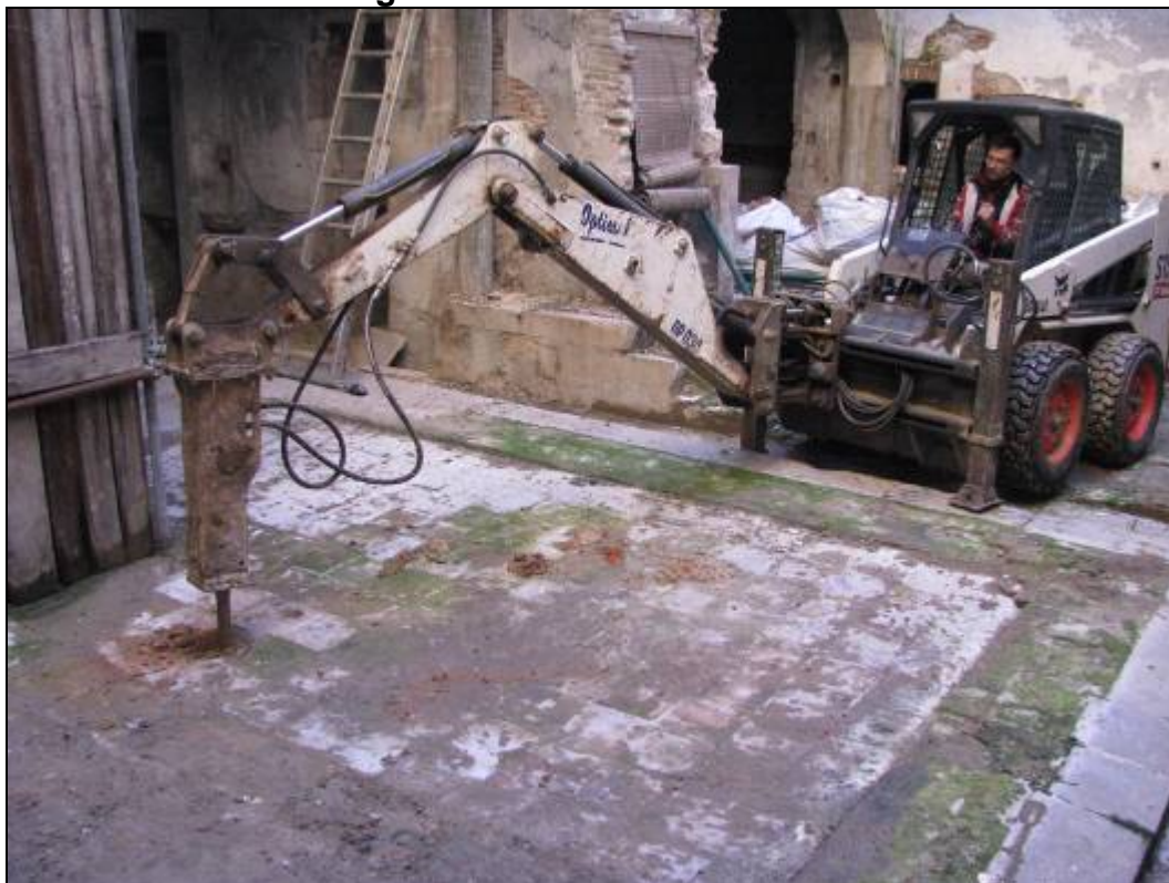
Inici dels treballs d'obertura de la cala.
