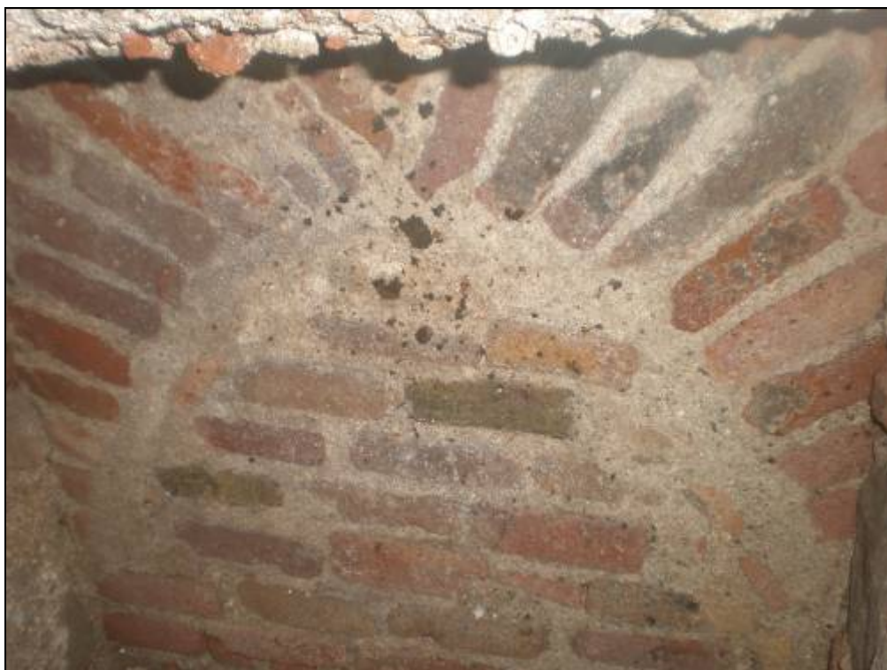
Mur amb arc de descàrrega UE 20000.
