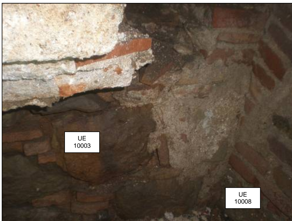
Mur N del dipòsit 10003 i arc de descàrrega UE 10008
