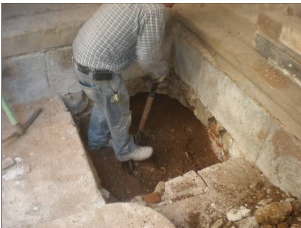
Procés d'excavació de l'estrat UE 30001.
