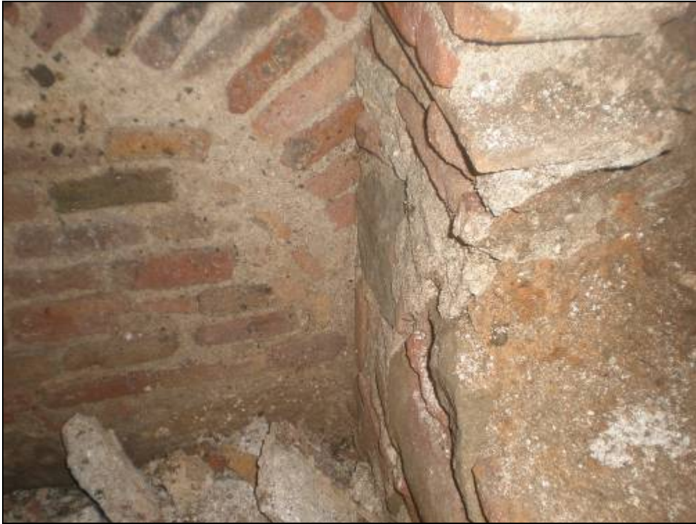
Mur sud del dipòsit UE 10003 recolzat a l'arc de descàrrega UE10008.
