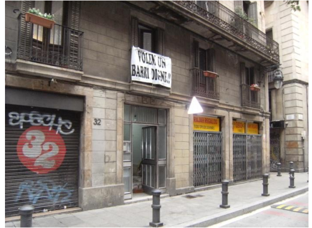
FOTO 2. Vista general de la finca
