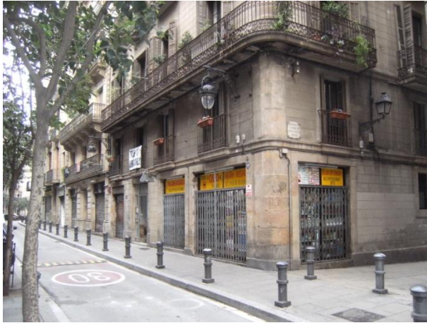
FOTO 1. Vista general de la finca
