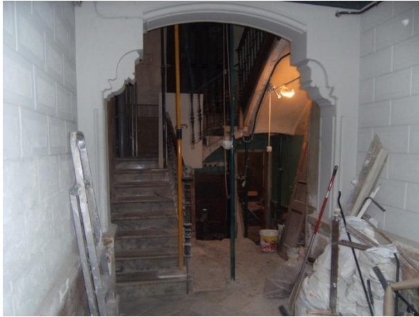
FOTO 5. Inici de les tasques d'excavació del fossar de l'ascensor
