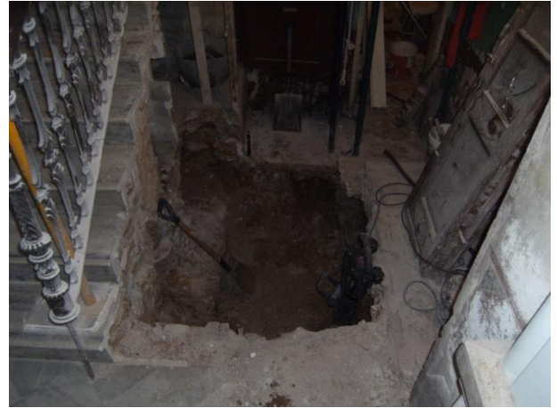
FOTO 6. Final de les tasques d'excavació del fossat
