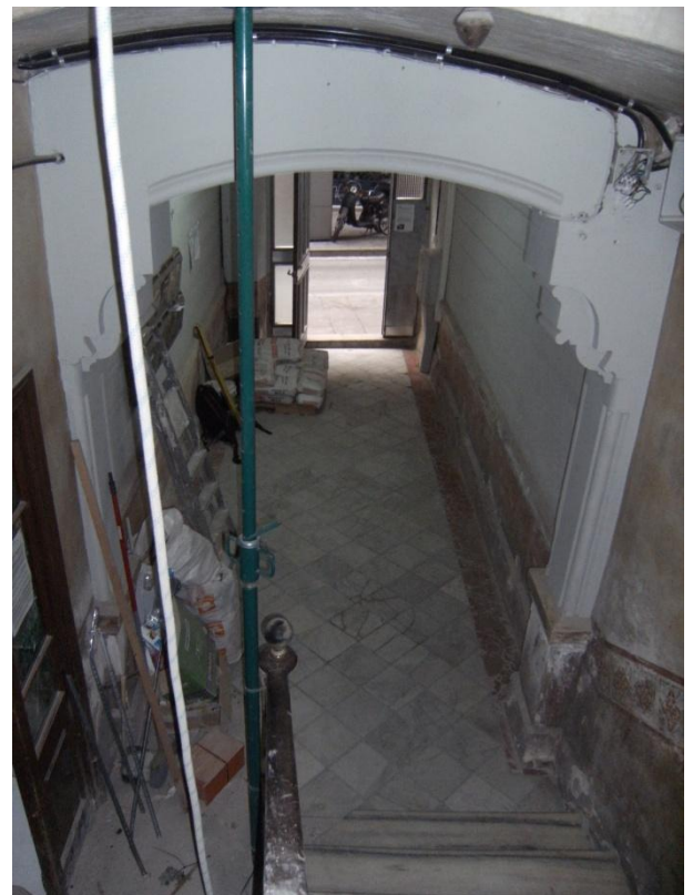
FOTO 4. Detall Vestíbul d'entrada
