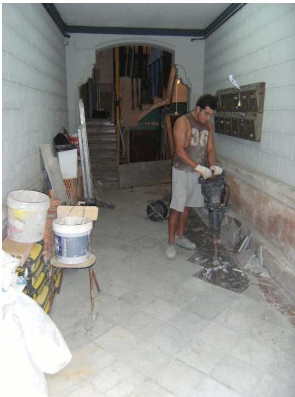
FOTO 7. Tasques d'excavació de la rasa de serveis
