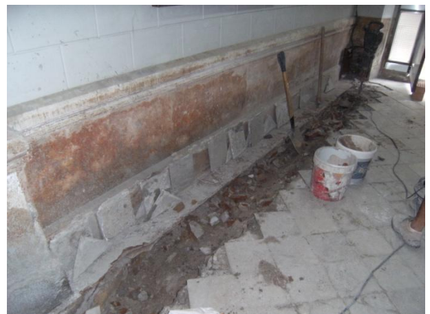
FOTO 8. Final d'excavació de la rasa de serveis
