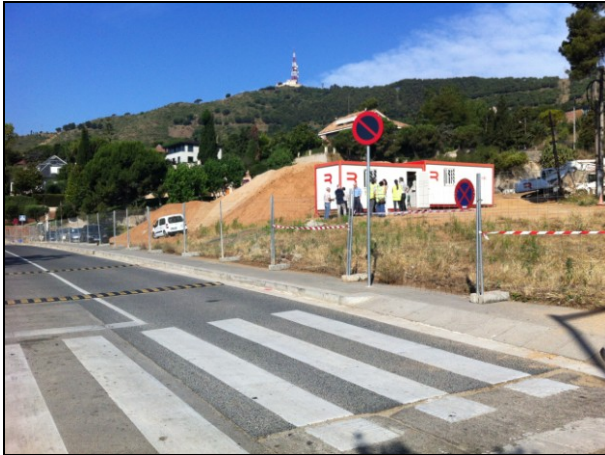
FOTO 1. Vista preliminar de l'àrea que requeria control arqueològic abans d'iniciar les remocions
