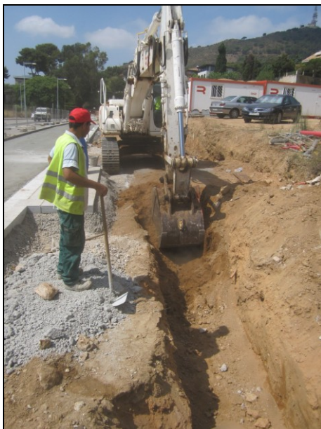
FOTO 7. Realització de la rasa de serveis paral·lela al carrer de Montevideo
