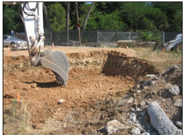
FOTO 4. Realització del rebaix mitjançant una excavadora giratòria
