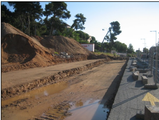
FOTO 3. Vista, mirant cap el NE, del rebaix paral·lel al carrer de Montevideo
