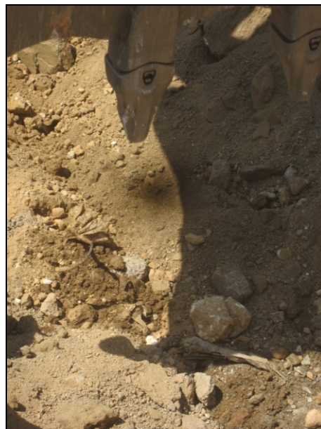
FOTO 10. Detall de la presència de plàstics i deixalles diverses a l'estrat excavat
