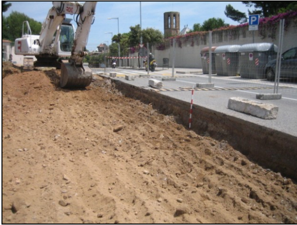
FOTO 5. Una altra perspectiva de la realització del rebaix que, en aquest punt, no superà els 70 cm
