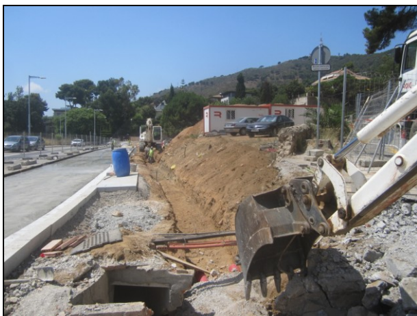
FOTO 11. Vista final de la rasa realitzada en direcció SO
