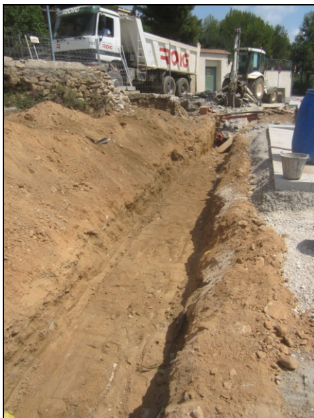
FOTO 9. Vista de la rasa de serveis en direcció NE
