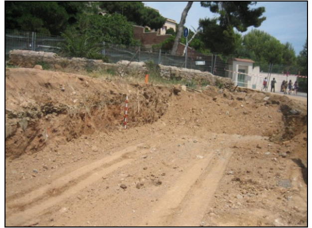
FOTO 6. El costat de muntanya del rebaix assolí més potència com a conseqüència del pendent ascendent que presenta el terreny
