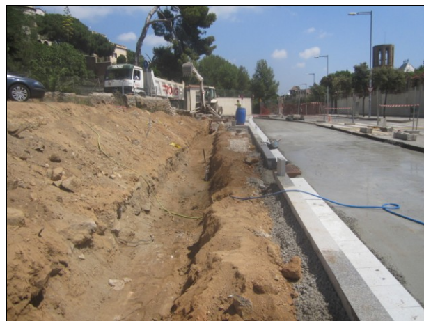
FOTO 12. Vista final de la rasa realitzada en direcció NE
