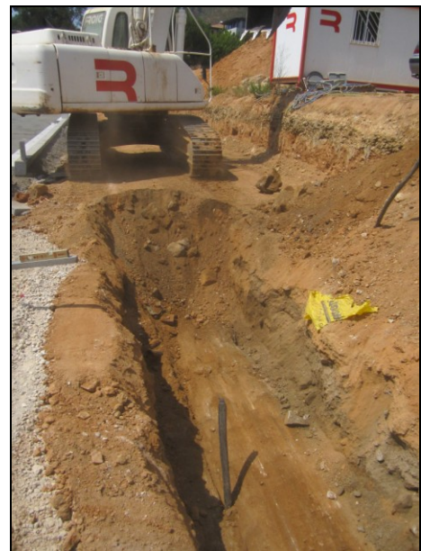
FOTO 8. L'estrat excavat estava farcit de materials contemporanis com plàstics i trossos de canonades de PVC
