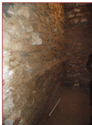
24)Construcció escala. Mur UE 032.
