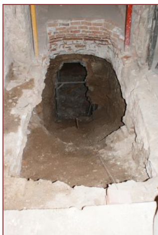
27) Construcció escala. Demolició parcial del mur UE 035 vist des de la planta baixa de la finca.
