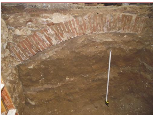
9) Fossat ascensor. Arc de descàrrega UE 005.
