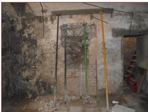
7) Construcció escala. Demolició parcial del mur UE 030.
