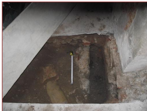
14)Pati interior. Rasa 2. Mur UE 016, claveguera UE 018 i col·lector contemporani.
