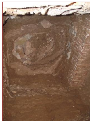
18)Construcció escala. Estructura escala existent, vista des del soterrani.
