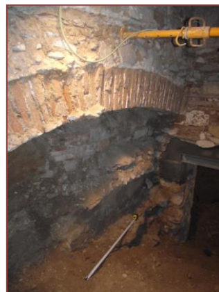
26) Construcció escala. Mur de tapiat UE 039 i arc de descàrrega UE 037.
