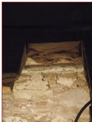
21)Construcció escala. Motllura de pedra reaprofitada a la construcció del mur UE 030.
