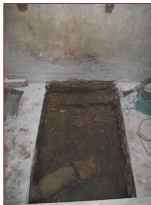
16)Pati interior. Rasa 2. Mur UE 014.
