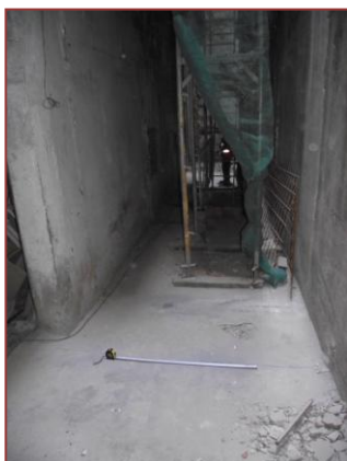
11) Pati interior. Zona on s'obren les rases 1 i 2.
