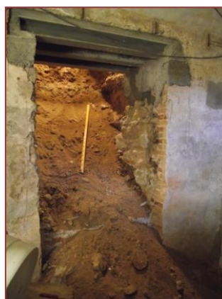
22)Construcció escala. Procés d'excavació per a la construcció de l'escala.
