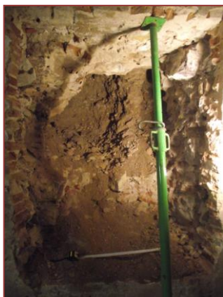
15)Construcció escala. Excavació dels estrats UEs 022 i 023.
