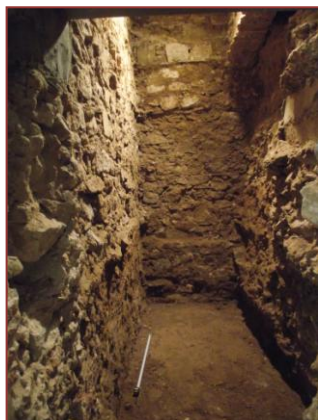
25) Construcció escala. Mur UE 035.
