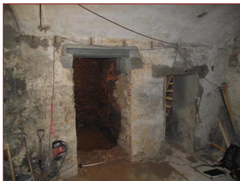
23)Construcció escala. Porta d'accés acabada.
