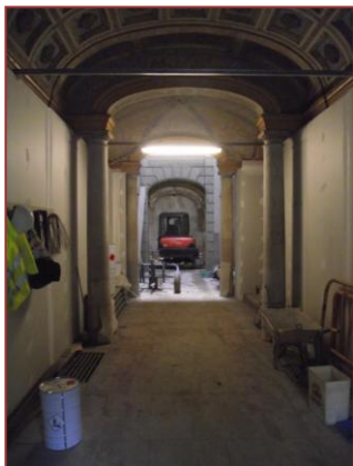
1) Interior finca afectada.
