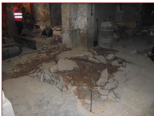
5) Fossat ascensor. Demolició del paviment UE 001.
