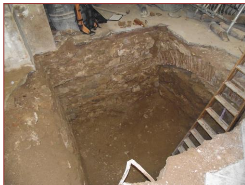
8) Fossat ascensor. Riostra UE 003 i arc de descàrrega UE 005.
