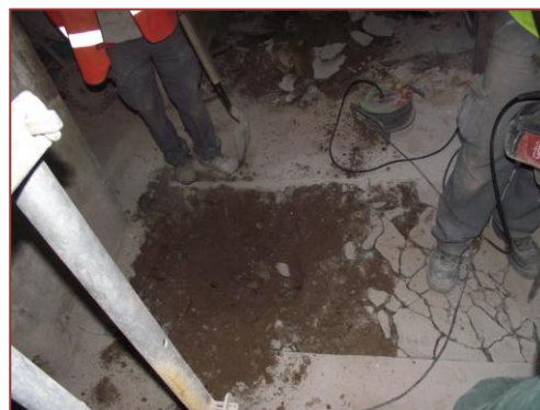
12) Pati interior. Rasa 1. Demolició del paviment UE 011 i estrat UE 013.
