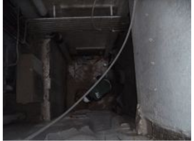
FOTO 6. Inici de les tasques d'excavació
