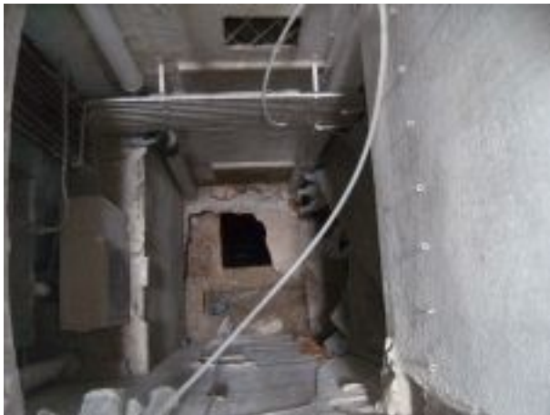
FOTO 7. Aparició del pou sota la llosa de formigó
