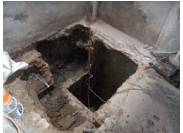
FOTO 8. Final de l'excavació
