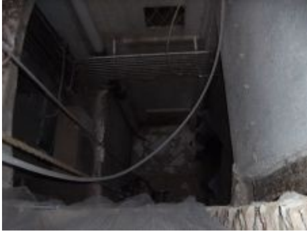
FOTO 5. Pati de llums, on s'havia d'efectuar el fossat de l'ascensor
