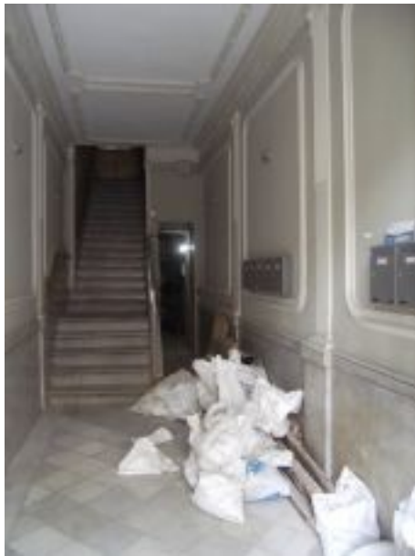
FOTO 3. Vestíbul de l'immoble
