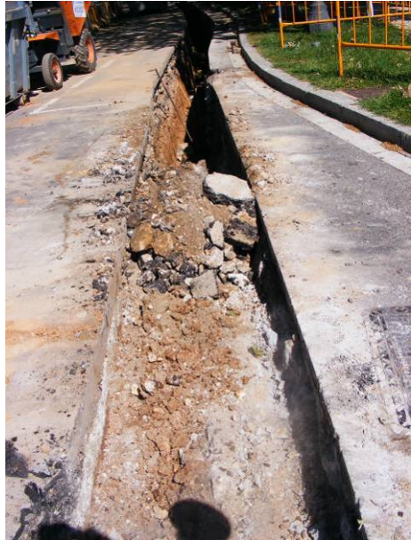
14. Localització de l'abocament de formigó.
