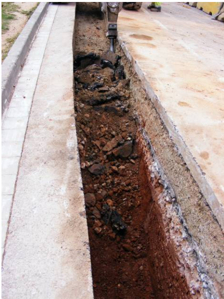
9. Extraient el segon nivell d'asfalt UE 5.
