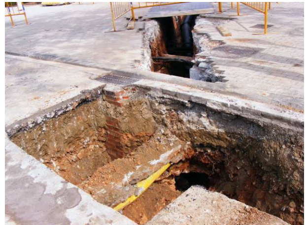
8. Obertura de la rasa a l'Avinguda de l'Estadi.
