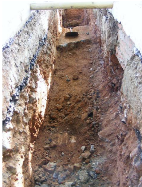
12. Tram central de la rasa, amb un col·lector a cota 1'10 m.
