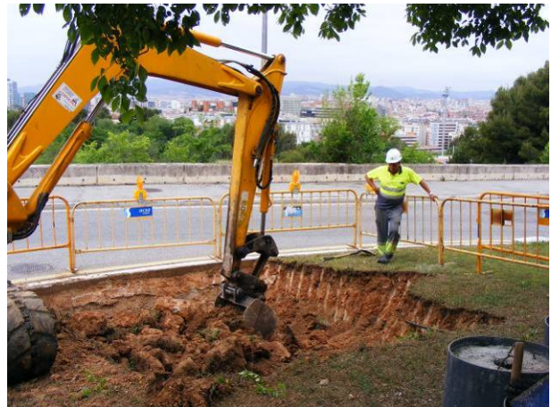
16. Inici del rebaix per a la localització de l'arqueta.
