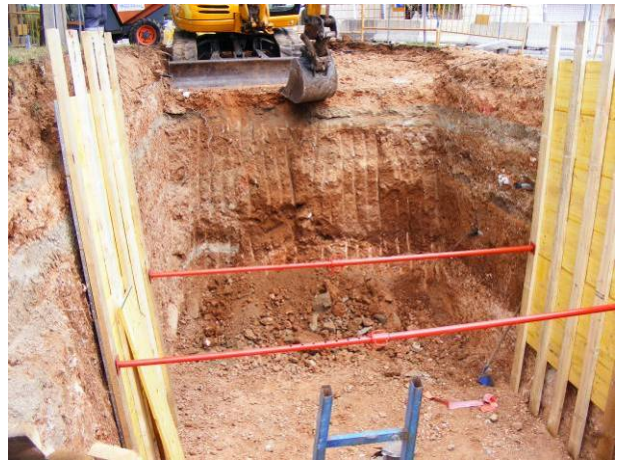
22. Finalització de la rasa de l'arqueta, connexió amb la rasa de la canonada.
