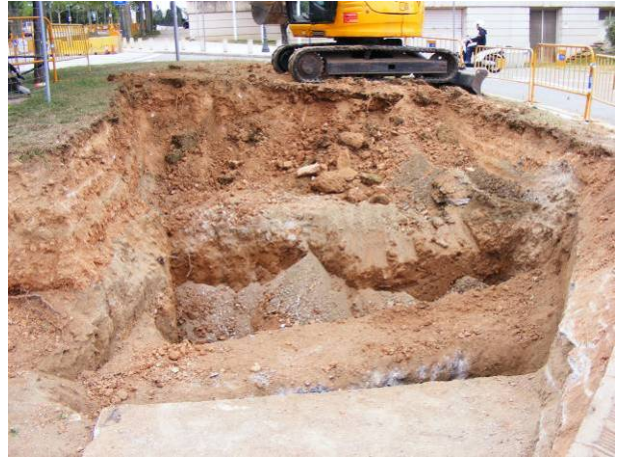
18. Inici del rebaix a la rotonda.
