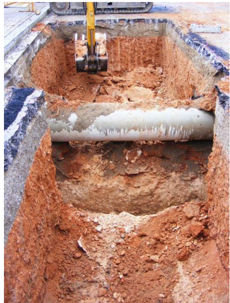
4. Rasa de l'arqueta i canonada on s'havia de fer la connexió.
