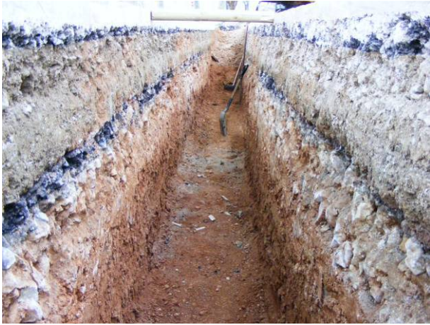
13. Tram central de la rasa. (UE 1, 2, 5, 6 i 8.)
