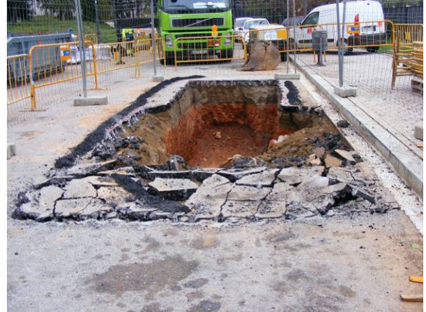
2. Treballs d'obertura de l'arqueta a l'inici de la rasa.
