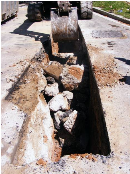
15. Retirada de l'abocament de formigó.
