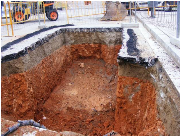
3. Rasa de construcció de l'arqueta.
