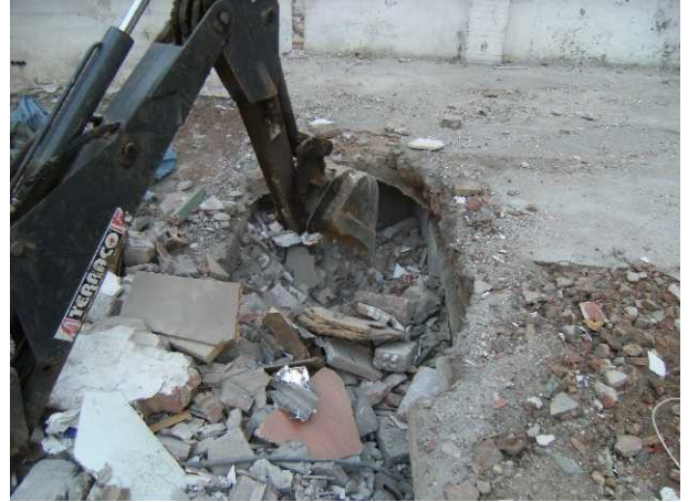
FOTO 6. Inici de retirada de la coberta caiguda
