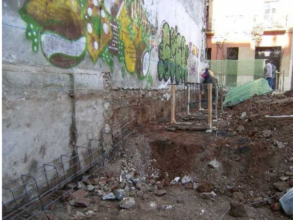
FOTO 13. Inici de les tasques d'excavació de les pantalles perimetrals
