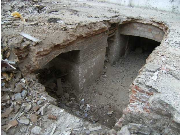
FOTO 9. Estat final de l'estructura un cop retirada la runa interior
