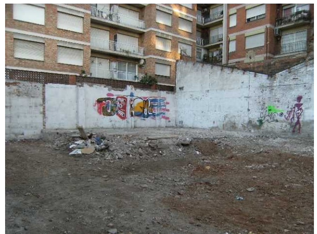
FOTO 4. Estat inicial del solar. Es pot apreciar l'estructura que aflorava al rasant de la finca
