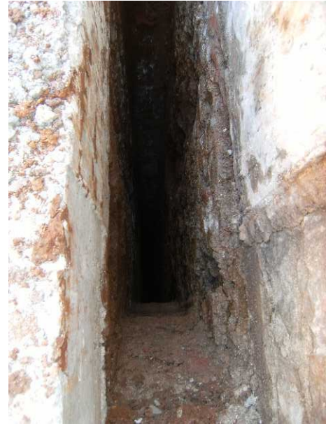
FOTO 14. Detall de la rasa de la pantalla perimetral
