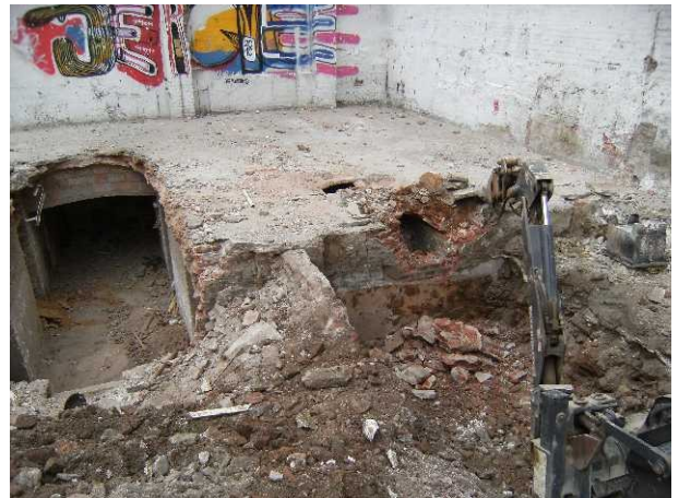
FOTO 8. Obertura de la coberta per accedir a l'interior de l'estructura
