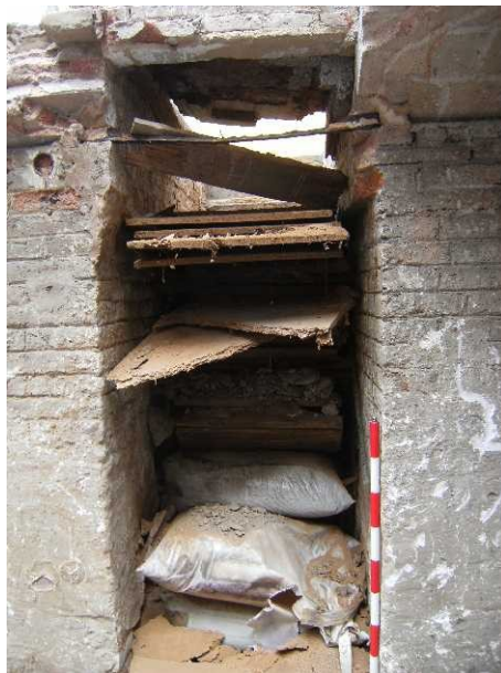
FOTO 11. Detall de l'accés al soterrani
