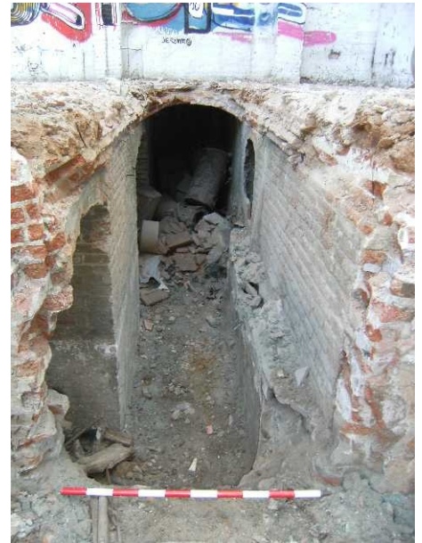
FOTO 10. Estat final de l'estructura un cop retirada la runa interior
