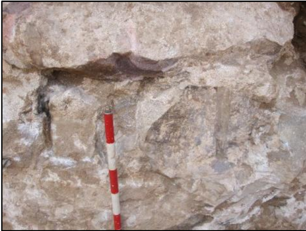
FOTO 41. Detall d'un dels forats de les barrinades efectuades en el tram d'escarpa UE 06.
