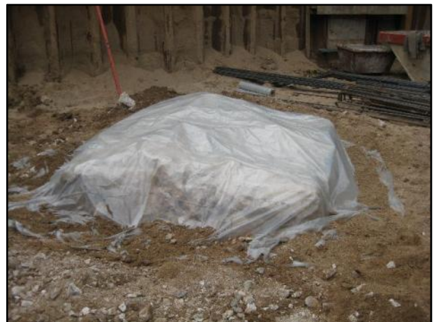
FOTO 36. Vista del cobriment amb plàstic del contrafort UE 10 abans de procedir a la realització de la llosa de formigó.
