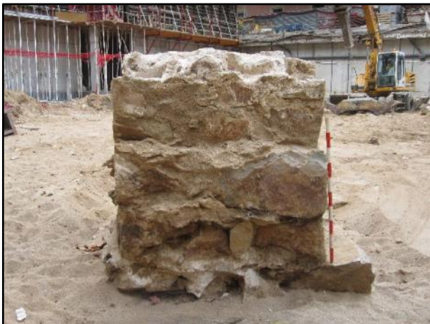
FOTO 27. Vista frontal del contrafort UE 12.
