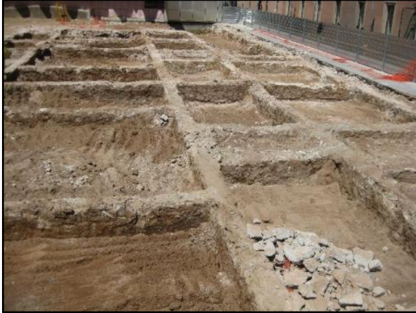
FOTO 5. Vista general de les fonamentacions de l'edifici enderrocat (Wellington 2).
