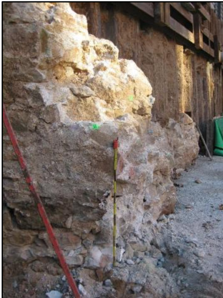
FOTO 39. Vista lateral (costat est) del contrafort UE 08, una vegada duts a terme els treballs de desmuntatge.
