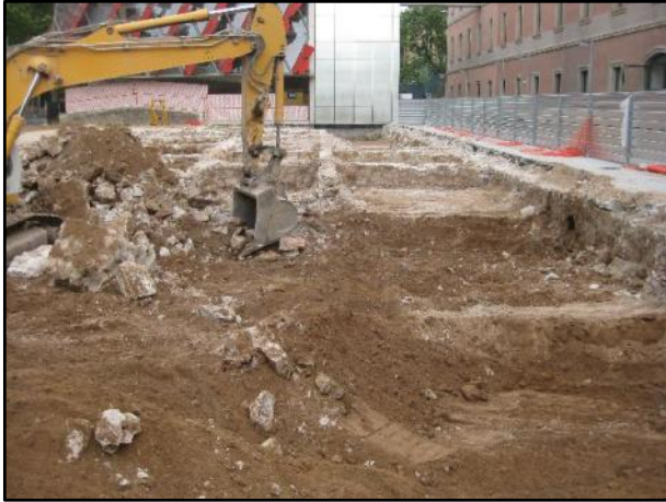
FOTO 9. Vista general dels treballs mecànics de rebaix del terreny.
