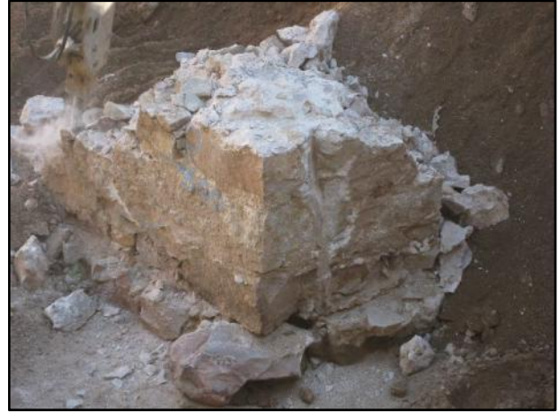
FOTO 34. Vista dels treballs de desmuntatge del contrafort UE 12.
