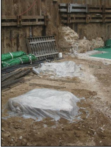
FOTO 37. Vista general del cobriment amb plàstic dels contraforts UE 10 i UE 12 abans de procedir a la realització de la llosa de formigó.
