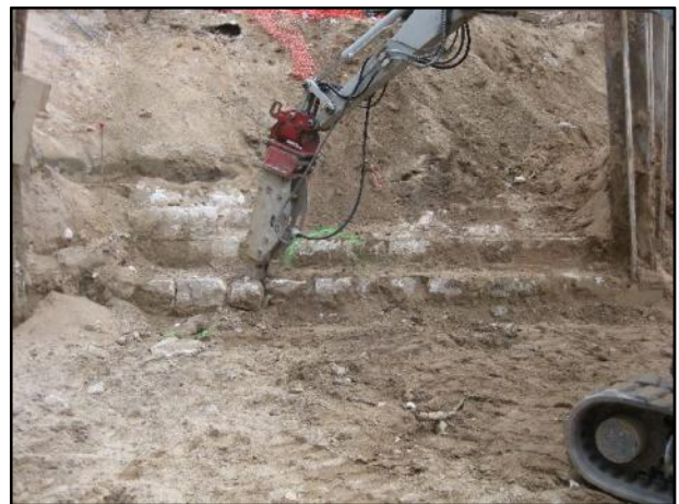
FOTO 32. Vista dels treballs de desmuntatge del tram d'escarpa UE 16.
