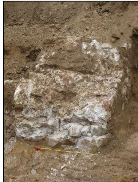
FOTO 40. Vista frontal del contrafort UE 14, una vegada realitzats els treballs de desmuntatge.
