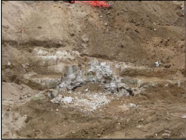
FOTO 33. Vista del tram d'escarpa UE 16, una vegada finalitzats els treballs de desmuntatge.
