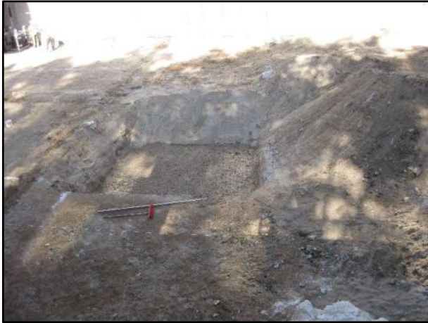
FOTO 17. Vista general de la fossa de la base de la grua en el solar de Wellington 3.
