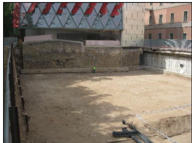
FOTO 12. Vista general del solar de Wellington 2, una vegada efectuat el rebaix previst en el projecte d'obra.
