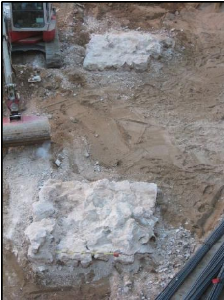
FOTO 35. Vista general dels contraforts UE 10 i UE 12, una vegada finalitzats els treballs de desmuntatge.
