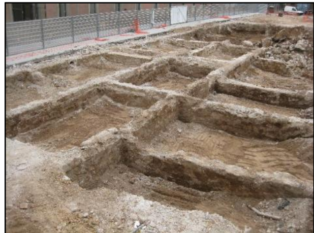
FOTO 4. Vista general de les fonamentacions de l'edifici enderrocat (Wellington 2).
