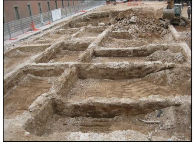
FOTO 6. Vista general de les fonamentacions de l'edifici enderrocat (Wellington 2).
