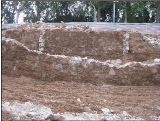
FOTO 7. Vista general on s'aprecia l'inici d'un dels trams de construcció de la fonamentació de l'edifici enderrocat (Wellington 2).
