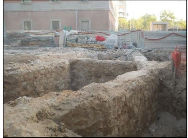
FOTO 14. Vista general de les fonamentacions de l'edifici enderrocat (Wellington 3).
