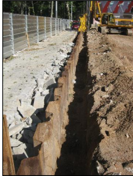
FOTO 2. Vista de la rasa efectuada per a la col·locació de la cable-estaca (costat carrer Wellington).
