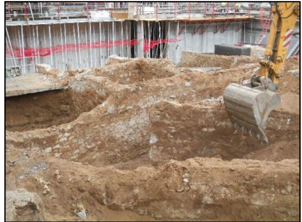
FOTO 16. Vista general de les fonamentacions de l'edifici enderrocat (Wellington 3).
