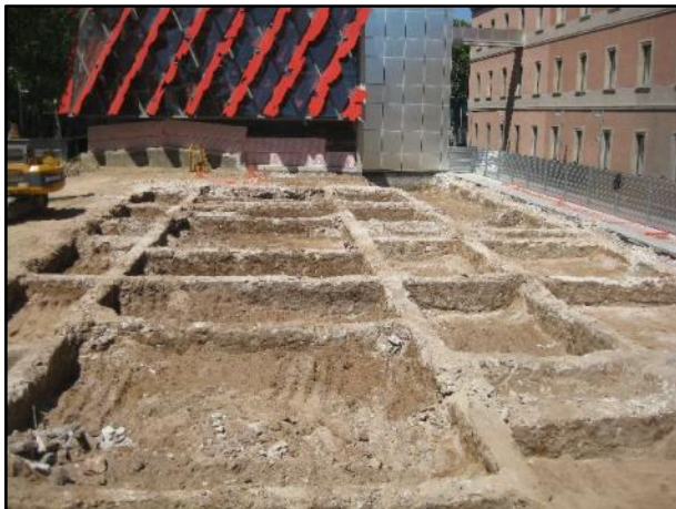
FOTO 3. Vista general de les fonamentacions de l'edifici enderrocat (Wellington 2).
