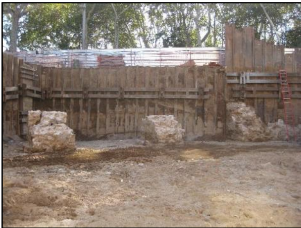
FOTO 19. Vista general de la disposició dels contraforts UE 08, UE 10 i UE 12.
