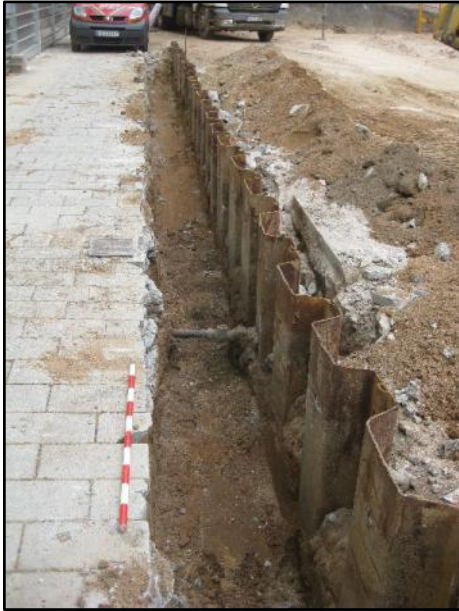
FOTO 1. de la rasa efectuada per a la col·locació de la cable-estaca (costat carrer Wellington).
