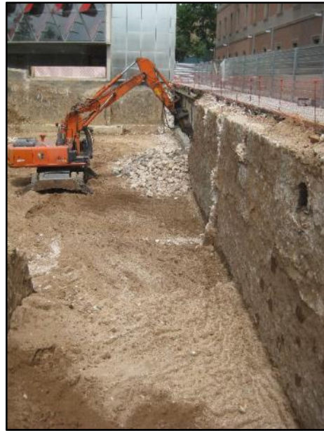
FOTO 10. Vista general dels treballs de desmuntatge de les fonamentacions dels edificis d'habitatges de la Caserna militar.
