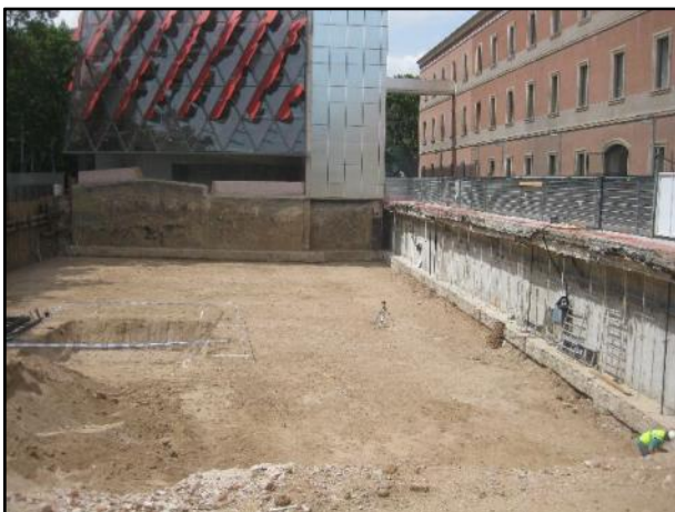
FOTO 11. Vista general del solar de Wellington 2, una vegada efectuat el rebaix previst en el projecte d'obra.
