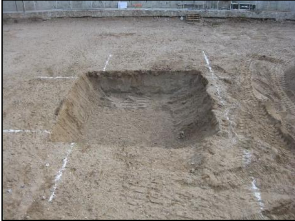
FOTO 13. Vista general de la fossa de la base de la grua en el solar de Wellington 2.
