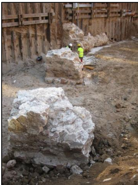
FOTO 23. Vista general dels contraforts UE 08, UE 10 i UE 12.
